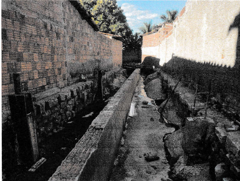
FIGURA 1 – EXECUÇÃO DE FORMAS E CONCRETAGEM DE PILARETES DO TRECHO ENTRE A RUA DELFINO FRANCISCO E A RUA MARIA EVARISTO DE PAIVA;
