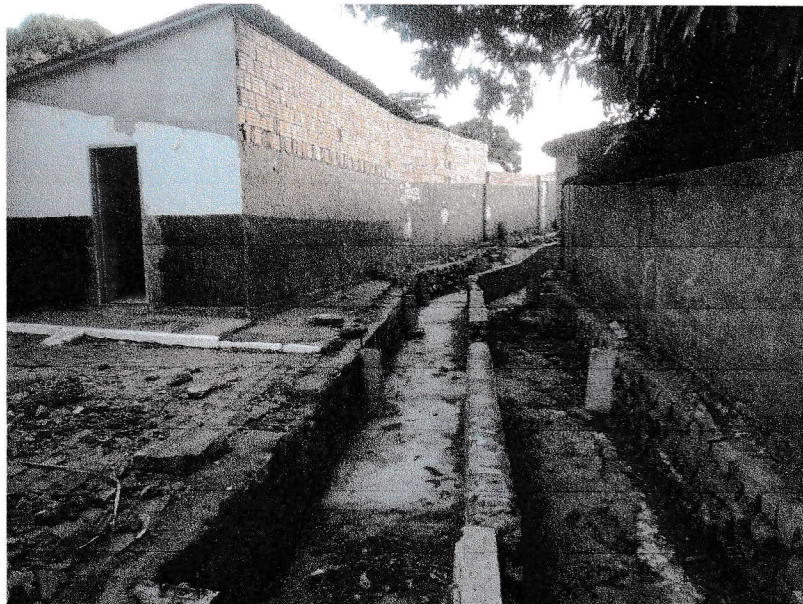
FIGURA 6 - EXECUÇÃO DE CHAPISCO, REVESTIMENTO ARGAMASSADO E CONTRAPISO DO TRECHO ENTRE A RUA MARIA EVARISTO DE PAIVA E A RUA BEVENUTO ALVES DA ROCHA;
