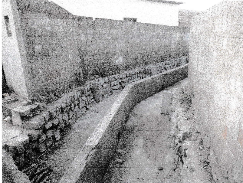
FIGURA 5 – EXECUÇÃO DE CHAPISCO, REVESTIMENTO ARGAMASSADO E CONTRAPISO DO TRECHO ENTRE A RUA DELFINO FRANCISCO E A RUA MARIA EVARISTO DE PAIVA;
