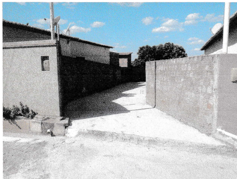
FIGURA 10 - EXECUÇÃO DE CONCRETAGEM DE LAJE E VIGAMENTOS DO TRECHO ENTRE A RUA DELFINO FRANCISCO E A RUA MARIA EVARISTO DE PAIVA;
