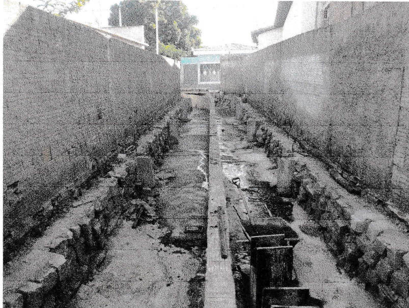
FIGURA 3 – EXECUÇÃO DE CONTRAPISO DO TRECHO ENTRE A RUA DELFINO FRANCISCO E A RUA MARIA EVARISTO DE PAIVA;
