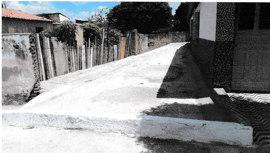
FIGURA 9 – SERVIÇO DE LIMPEZA FINAL DA OBRA - TRECHO ENTRE A RUA 15 DE NOVEMBRO E RUA 07 DE SETEMBRO;
