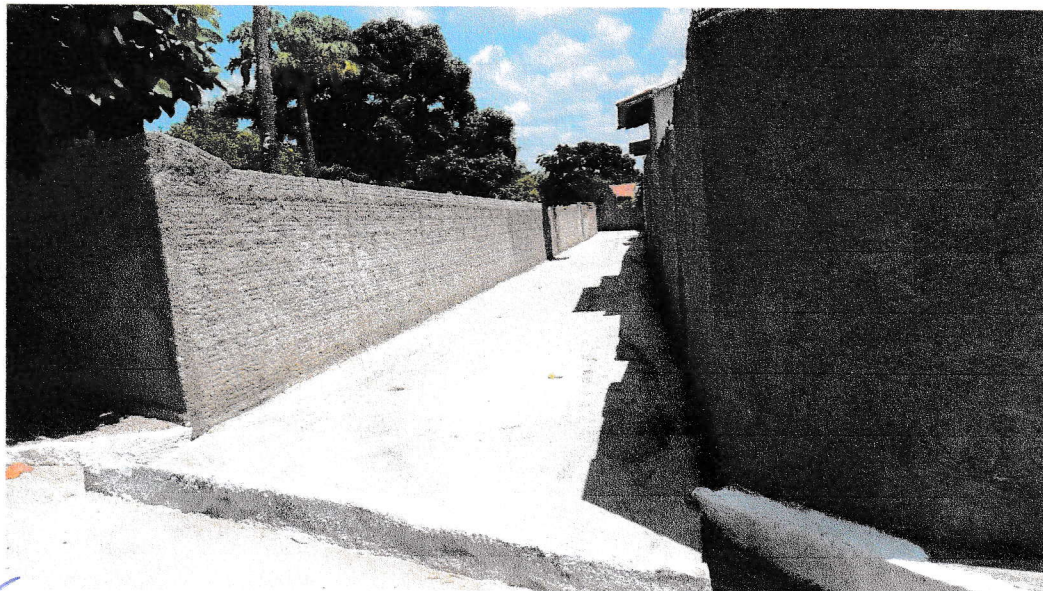
FIGURA 8 - SERVIÇO DE LIMPEZA FINAL DA OBRA - TRECHO ENTRE A RUA PROFESSORA DALILA DA FONSECA ROCHA E RUA 15 DE NOVEMBRO;
