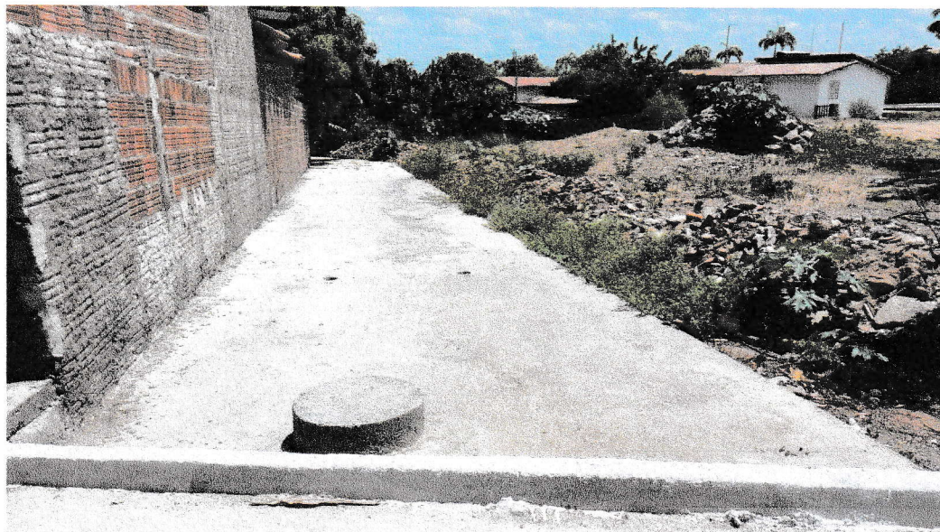
FIGURA 6 - SERVIÇO DE LIMPEZA FINAL DA OBRA – TRECHO ENTRE A RN – 177 E RUA PROFESSORA DALILA DA FONSECA ROCHA;
