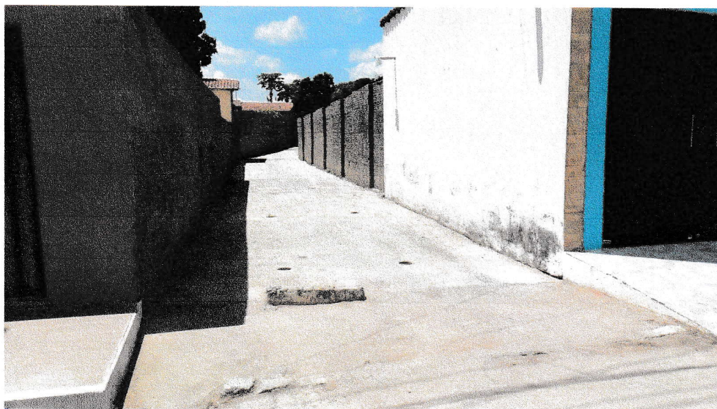
FIGURA 10 - SERVIÇO DE LIMPEZA FINAL DA OBRA - TRECHO ENTRE A RUA 15 DE NOVEMBRO E RUA 07 DE SETEMBRO;
