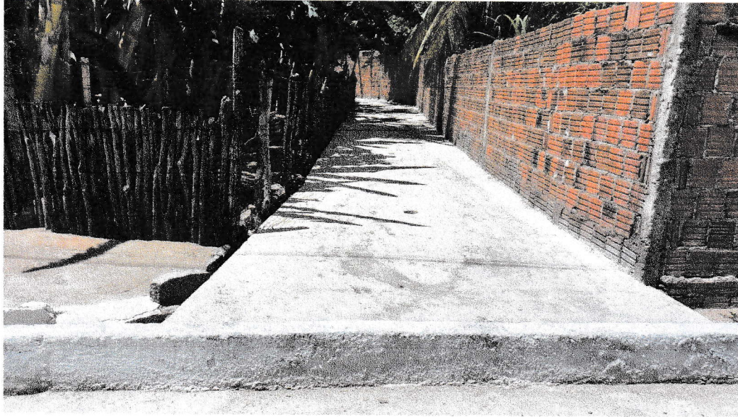
FIGURA 7 – SERVIÇO DE LIMPEZA FINAL DA OBRA – TRECHO ENTRE A RN – 177 E RUA PROFESSORA DALILA DA FONSECA ROCHA;
