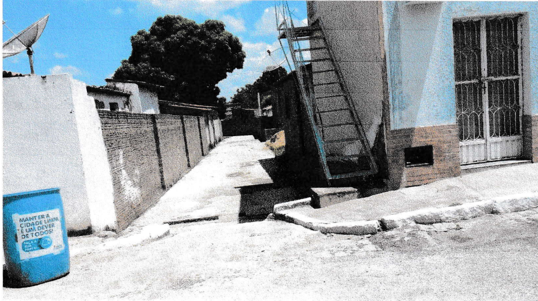
FIGURA 11 – SERVIÇO DE LIMPEZA FINAL DA OBRA - TRECHO ENTRE A RUA 07 DE SETEMBRO E A RUA DELFINO FRANCISCO;
