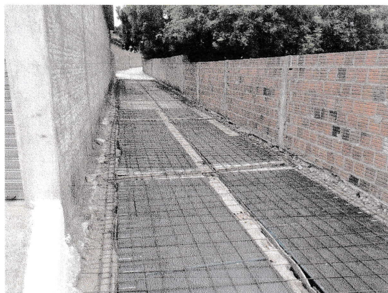
FIGURA 4 – EXECUÇÃO DE FORMAS E ARMAÇÃO DE LAJES E VIGAMENTOS DO TRECHO ENTRE A RUA MARIA EVARISTO DE PAIVA E A RUA BEVENUTO ALVES DA ROCHA;
