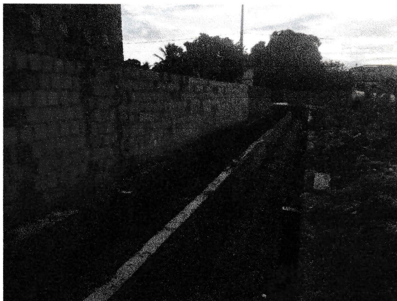
FIGURA 7 – EXECUÇÃO DE ALVENARIA DE TIJOLOS CERAMICOS, CHAPISCO E REBOCO DO TRECHO ENTRE A RUA BEVENUTO ALVES DA ROCHA E A RUA VICENTE DAS CHAGAS DE OLIVEIRA;
