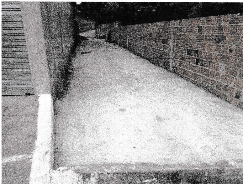
FIGURA 5 – EXECUÇÃO DE CONCRETAGEM DE LAJE E VIGAMENTOS DO TRECHO ENTRE A RUA MARIA EVARISTO DE PAIVA E A RUA BEVENUTO ALVES DA ROCHA;
