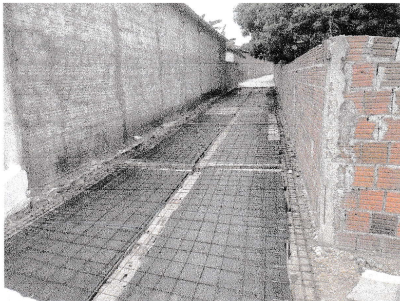
FIGURA 3 – EXECUÇÃO DE FORMAS E ARMAÇÃO DE LAJES E VIGAMENTOS DO TRECHO ENTRE A RUA MARIA EVARISTO DE PAIVA E A RUA BEVENUTO ALVES DA ROCHA;
