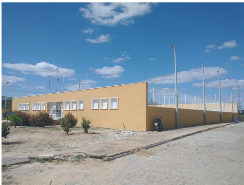
Figura 22 – EXECUÇÃO DE SERVIÇOS PINTURA DAS ÁREAS EXTERNAS;
