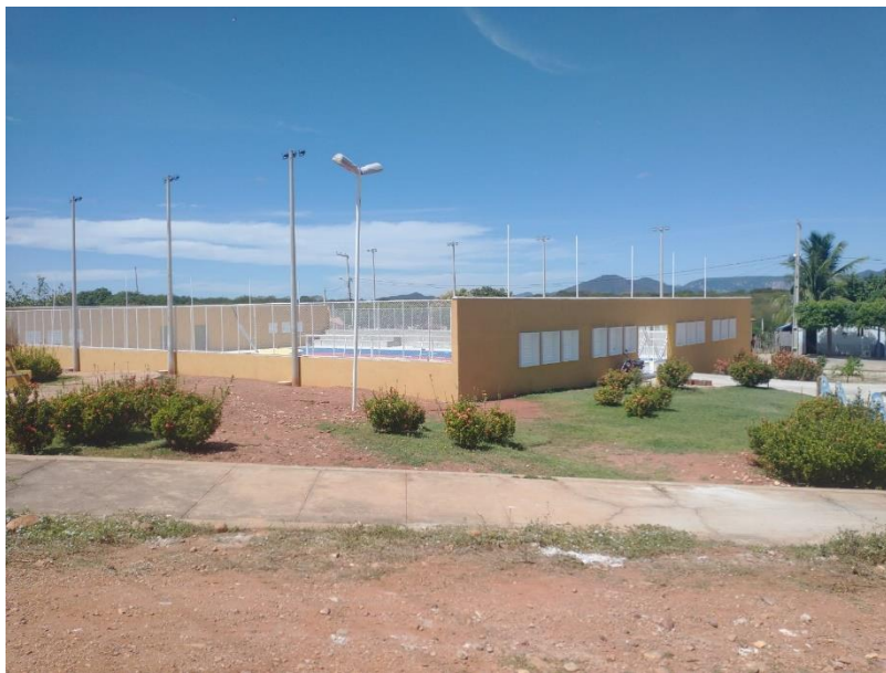
Figura 19 – EXECUÇÃO DE SERVIÇOS PINTURA DAS ÁREAS EXTERNAS;
