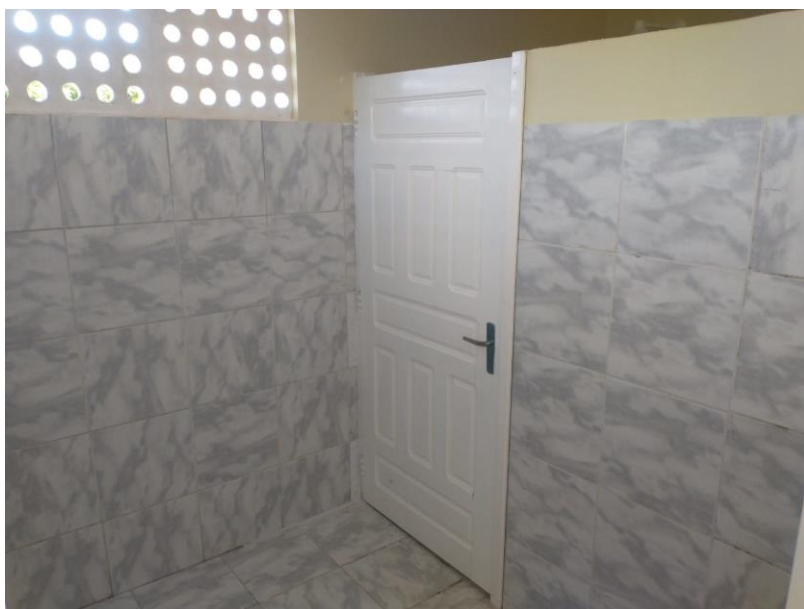
Figura 2 – EXECUÇÃO DE SERVIÇOS DE SUBSTITUIÇÃO DE ESQUADRIAS E FECHADURAS;
