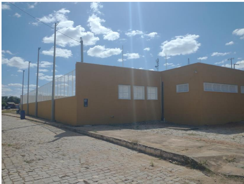
Figura 21 – EXECUÇÃO DE SERVIÇOS PINTURA DAS ÁREAS EXTERNAS;
