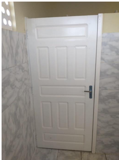
Figura 3 – EXECUÇÃO DE SERVIÇOS DE SUBSTITUIÇÃO DE ESQUADRIAS E FECHADURAS;
