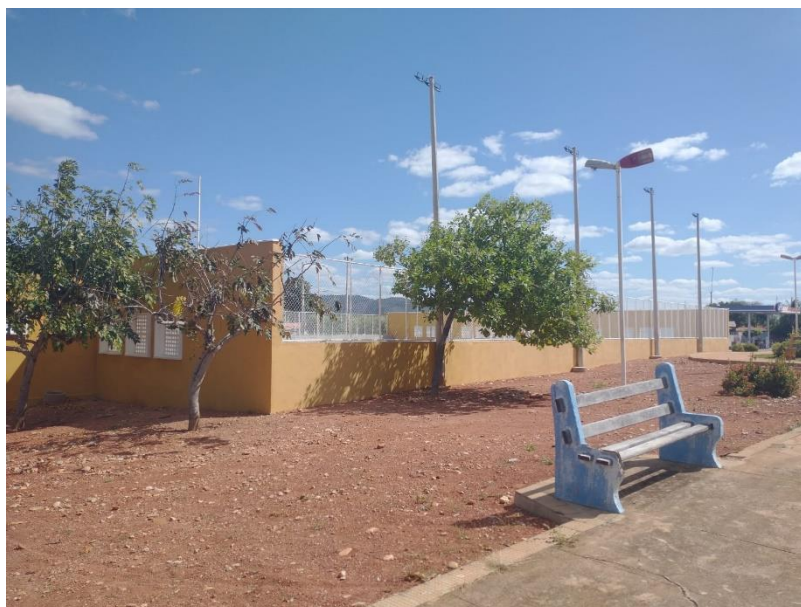
Figura 20 – EXECUÇÃO DE SERVIÇOS PINTURA DAS ÁREAS EXTERNAS;
