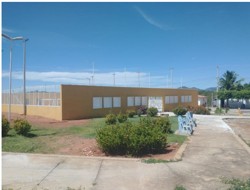
Figura 17 – EXECUÇÃO DE SERVIÇOS PINTURA DAS ÁREAS EXTERNAS;
