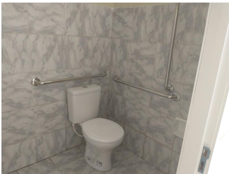
Figura 10 – EXECUÇÃO DE SERVIÇOS DE FIXAÇÃO DE BARRAS DE APOIO E ACESSIBILIDADE E SUBSTITUIÇÃO DE LOUÇAS SANITÁRIAS;
