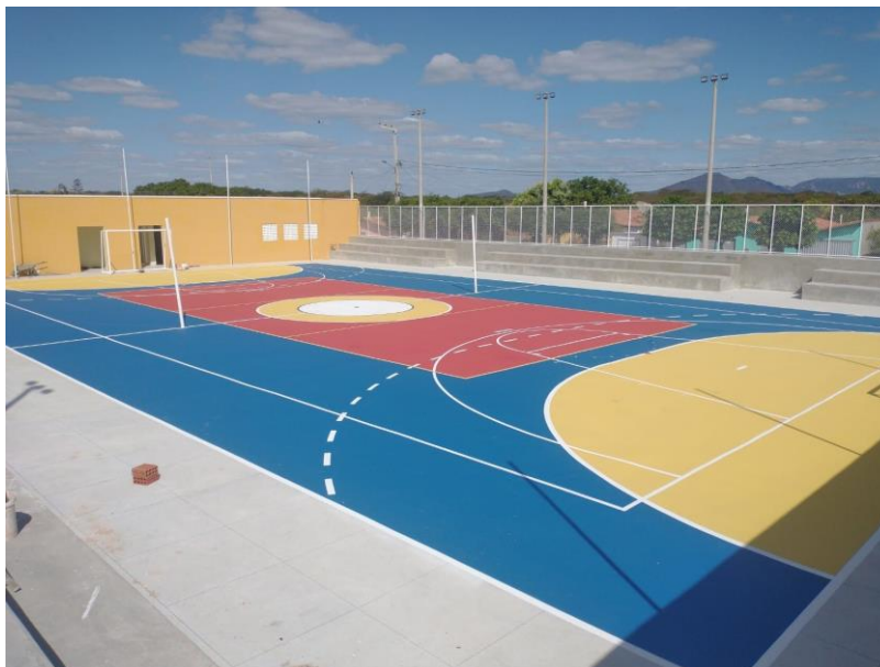
Figura 13 – EXECUÇÃO DE SERVIÇOS PINTURA DAS ÁREAS EXTERNAS, MARCAÇÃO E PINTURA DA QUADRA POLIESPORTIVA;
