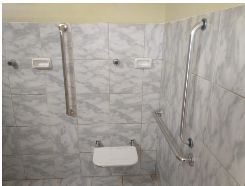
Figura 6 – EXECUÇÃO DE SERVIÇOS DE FIXAÇÃO DE BARRAS DE APOIO E ACESSIBILIDADE E SUBSTITUIÇÃO DE LOUÇAS SANITÁRIAS;
