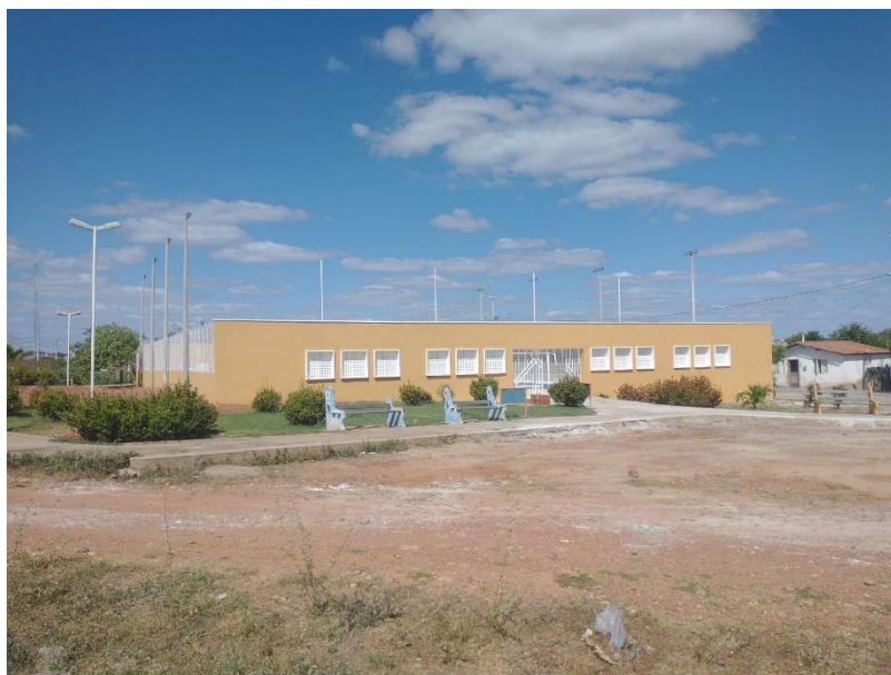
Figura 18 – EXECUÇÃO DE SERVIÇOS PINTURA DAS ÁREAS EXTERNAS;
