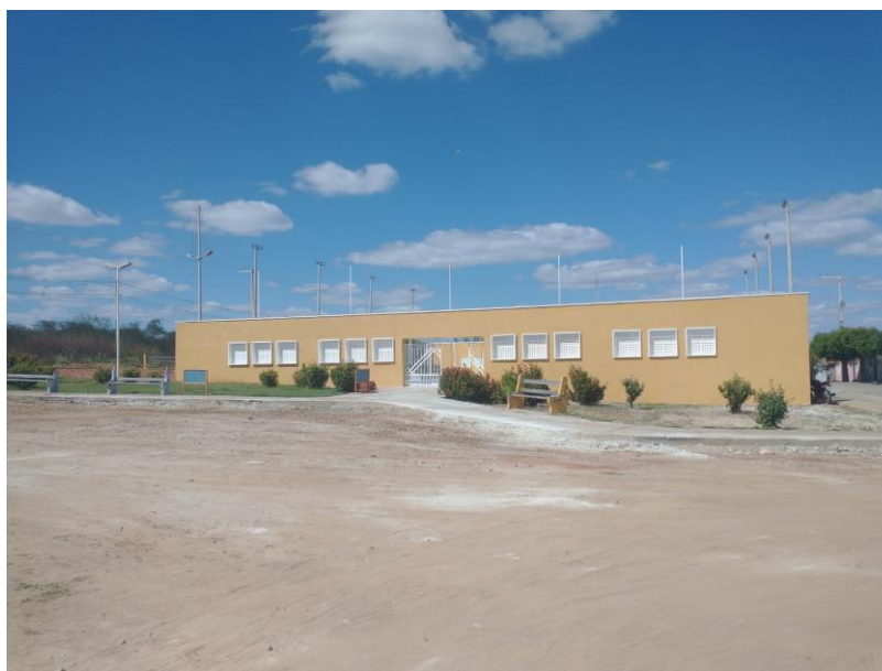
Figura 16 – EXECUÇÃO DE SERVIÇOS PINTURA DAS ÁREAS EXTERNAS;
