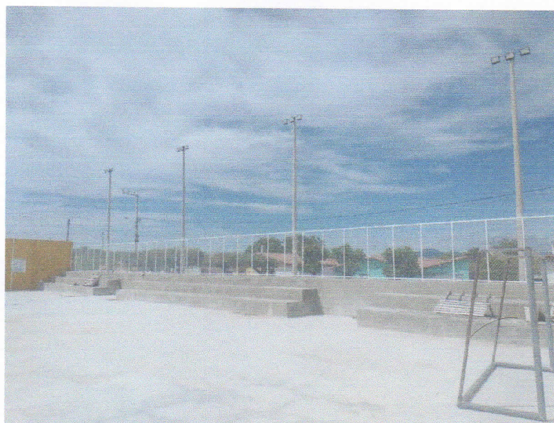
Figura 4 – INSTALAÇÃO DE REFLETORES PARA ILUMINAÇÃO DA QUADRA POLIESPORTIVA;
