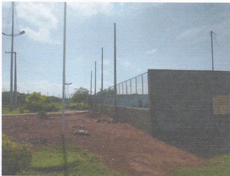
FIGURA 1 – FIXAÇÃO DE POSTE PARA ILUMINAÇÃO COM REFLETORES;
