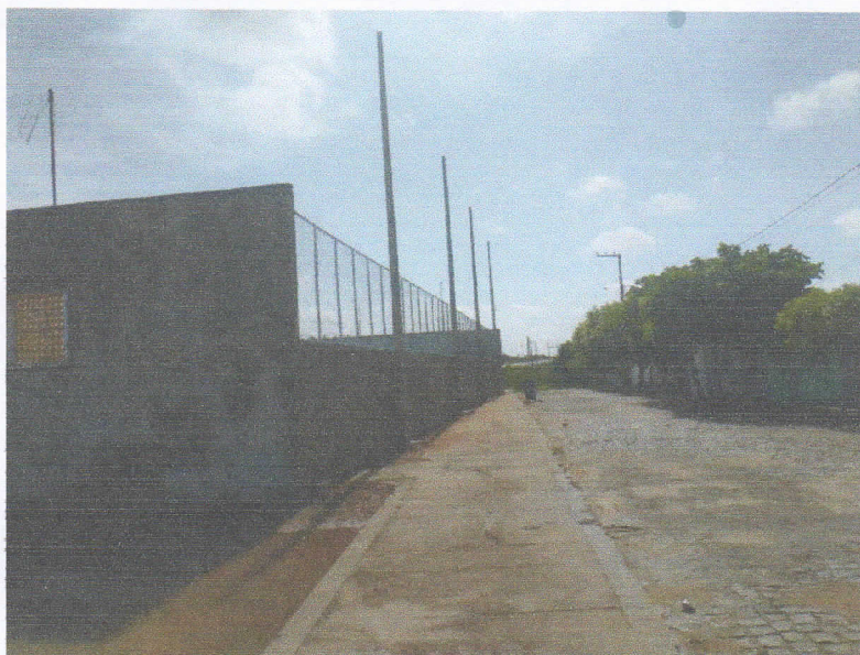
Figura 2 – FIXAÇÃO DE POSTE PARA ILUMINAÇÃO COM REFLETORES;
