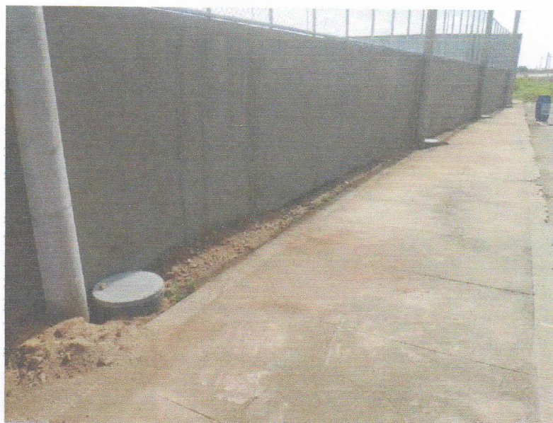
Figura 3 – EXECUÇÃO DE CAIXAS DE PASSAGEM PARA INSTALAÇÕES ELÉTRICAS DOS POSTES;
