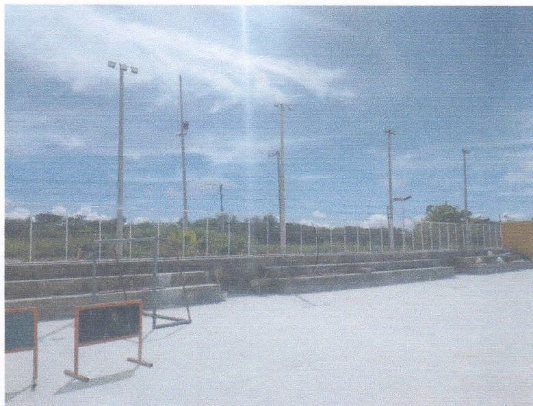
Figura 5 – INSTALAÇÃO DE REFLETORES PARA ILUMINAÇÃO DA QUADRA POLIESPORTIVA;
