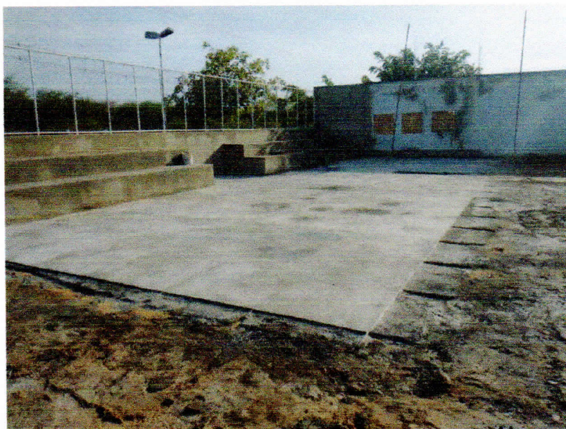
Figura 2 – INÍCIO DA EXECUÇÃO DE PISO GRANILITE;
