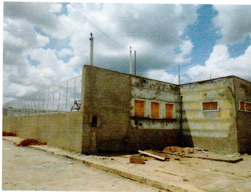
Figura 13 - EXECUÇÃO DE PADRÃO DE ENTRADA DE ENERGIA;
