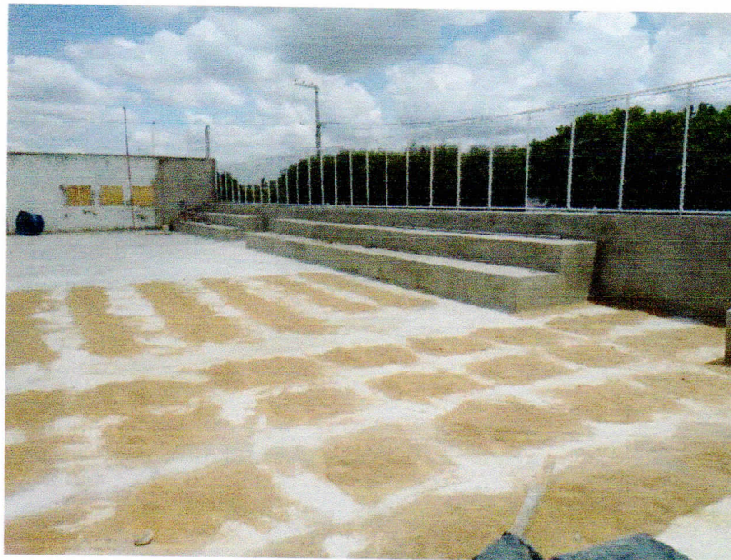
Figura 5 – EXECUÇÃO DE PISO GRANILITE (POLIMENTO);
