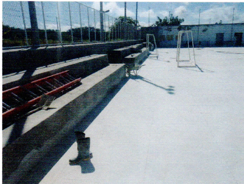
Figura 9 - EXECUÇÃO DE PISO GRANILITE (FINALIZADO);
