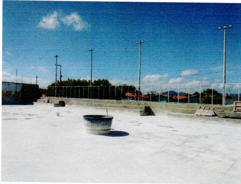
Figura 7 – EXECUÇÃO DE PISO GRANILITE (FINALIZADO);
