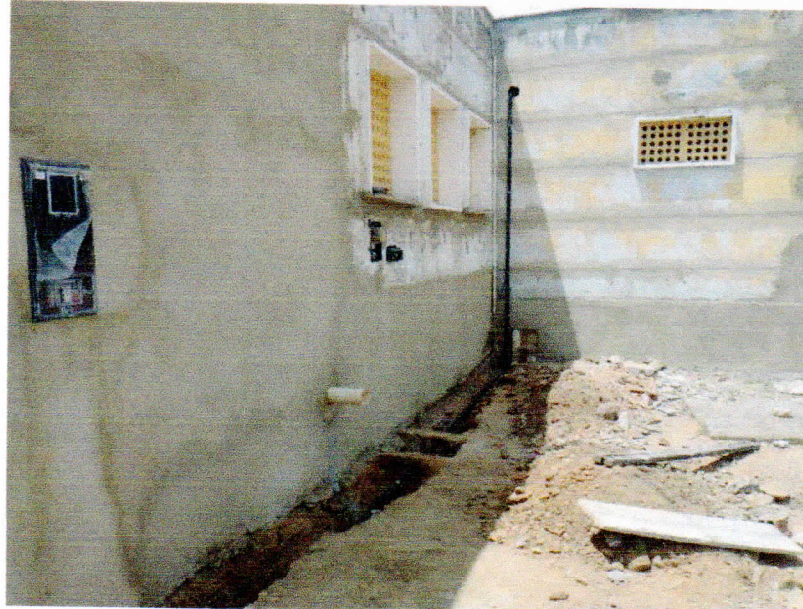
Figura 12 – EXECUÇÃO DE PADRÃO DE ENTRADA DE ENERGIA E INSTALAÇÕES;
