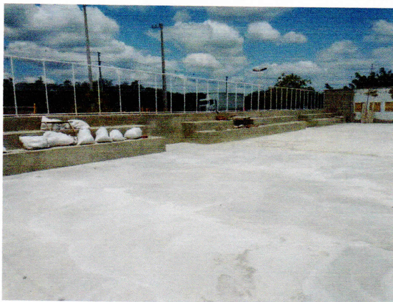
Figura 4 - EXECUÇÃO DE PISO GRANILITE (PRONTO PARA POLIMENTO);
