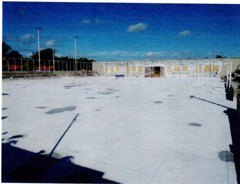
Figura 8 – EXECUÇÃO DE PISO GRANILITE (FINALIZADO);
