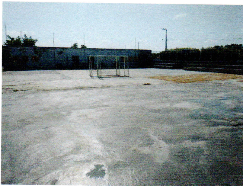
Figura 3 - EXECUÇÃO DE PISO GRANILITE (PRONTO PARA POLIMENTO);
