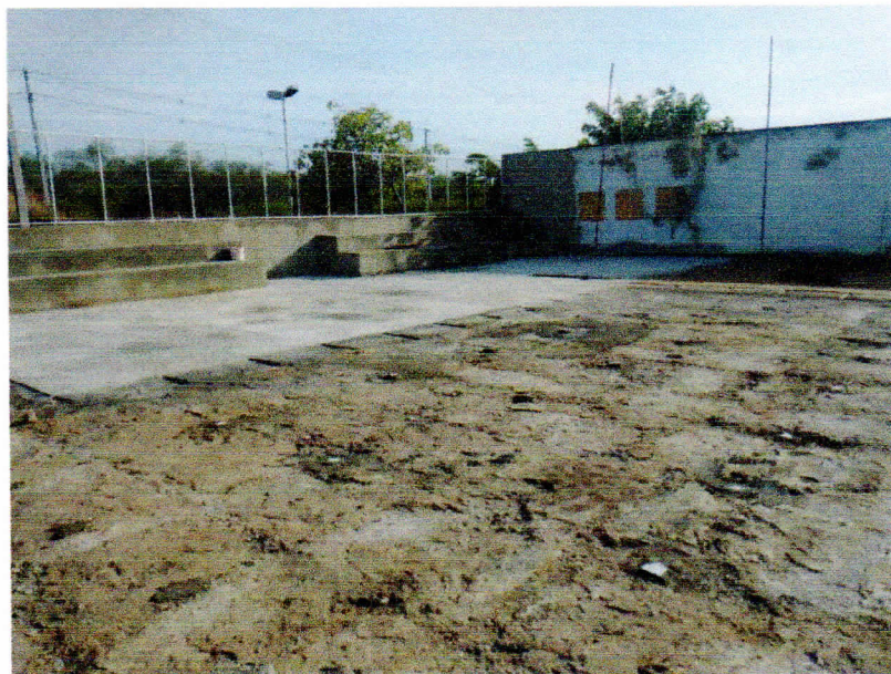
FIGURA 1 – INÍCIO DA EXECUÇÃO DE PISO GRANILITE;
