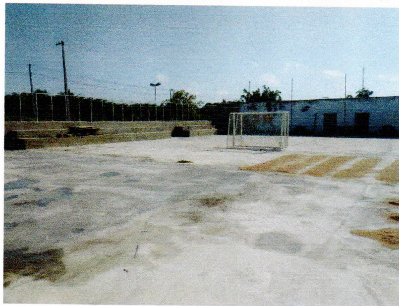
Figura 6 - EXECUÇÃO DE PISO GRANILITE (POLIMENTO);
