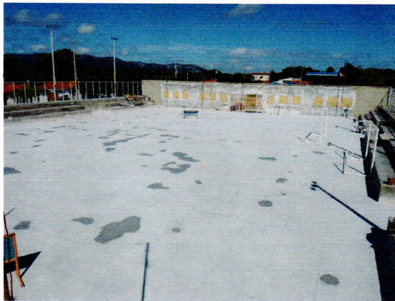
Figura 10 – EXECUÇÃO DE PISO GRANILITE (FINALIZADO);
