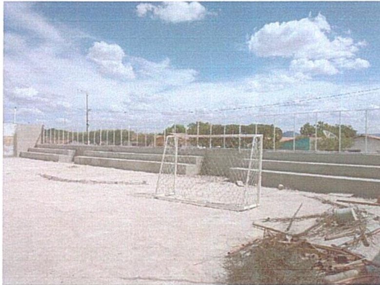
Figura 9 - EXECUÇÃO E PINTURA DE ALAMBRADOS, REBOCO E ACABAMENTOS EM ARQUIBANCADAS;
