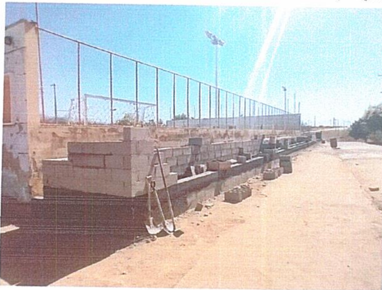
Figura 4 - EXECUÇÃO DE ALVENARIA EM BLOCOS DE CONCRETO (ARQUIBANCADAS);
