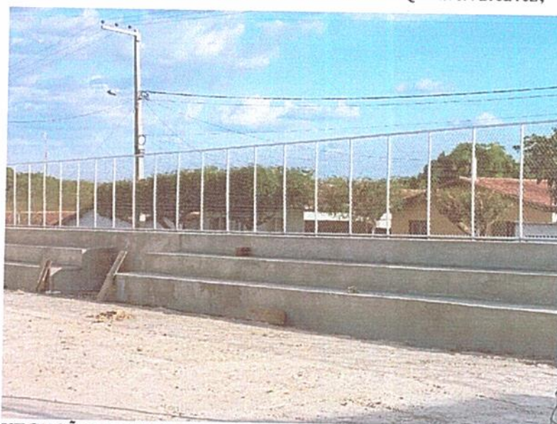
Figura 8 – EXECUÇÃO E PINTURA DE ALAMBRADOS, REBOCO E ACABAMENTOS EM ARQUIBANCADAS;
