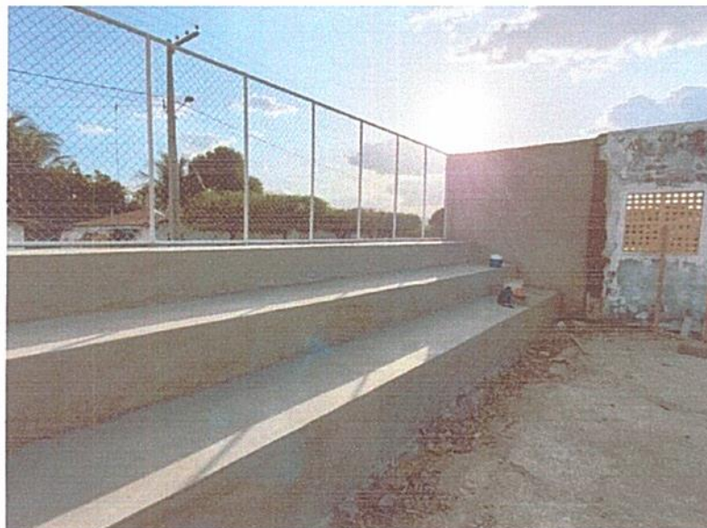
Figura 10 – EXECUÇÃO E PINTURA DE ALAMBRADOS, REBOCO E ACABAMENTOS EM ARQUIBANCADAS;
