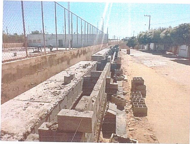
Figura 3 - EXECUÇÃO DE ALVENARIA EM BLOCOS DE CONCRETO (ARQUIBANCADAS);
