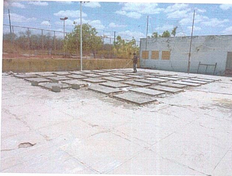
FIGURA 1 – FABRICAÇÃO E CURA E LAJES PRÉ-FABRICADAS DE CONCRETO (ARQUIBANCADAS);
