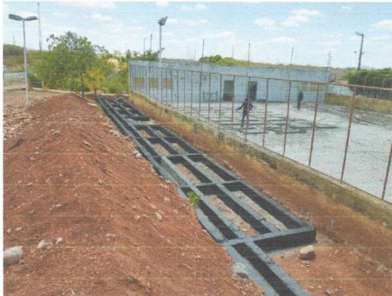
Figura 20 – CONCRETAGEM DE VIGAS E IMPERMEABILIZAÇÃO;
