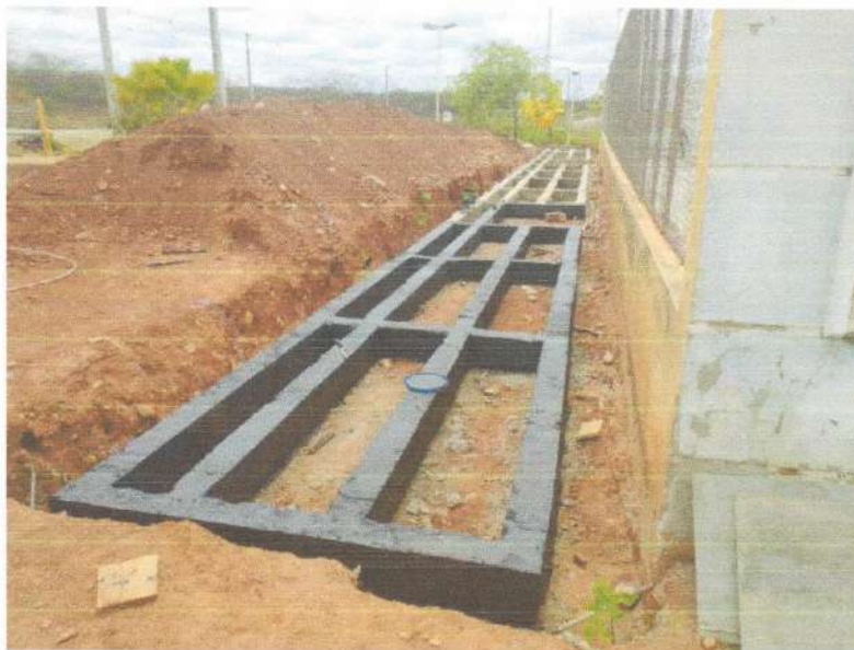
Figura 18 – CONCRETAGEM DE VIGAS E IMPERMEABILIZAÇÃO;
