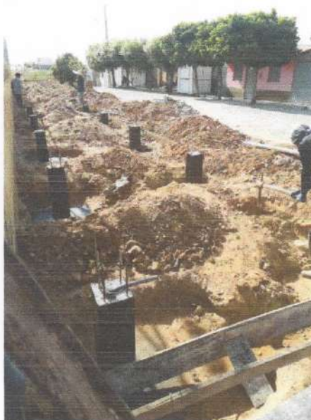
Figura 12 – CONCRETAGEM E IMPERMEABILIZAÇÃO DE SAPATAS DE FUNDAÇÕES;
