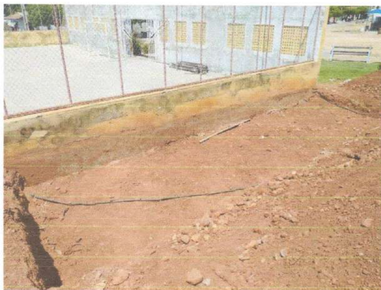
Figura 5 - ESCAVAÇÕES PARA EXECUÇÃO DE FUNDAÇÃO;
