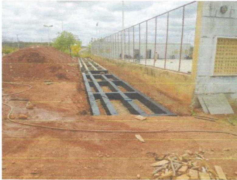
Figura 19 - CONCRETAGEM DE VIGAS E IMPERMEABILIZAÇÃO;
