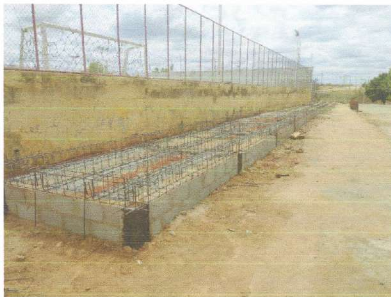
Figura 15 – EXECUÇÃO DE ARMADURAS PARA CONCRETAGEM DE VIGAMENTO DAS ARQUIBANCADAS;
