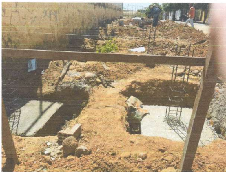
Figura 11 - CONCRETAGEM DE FUNDAÇÕES;
