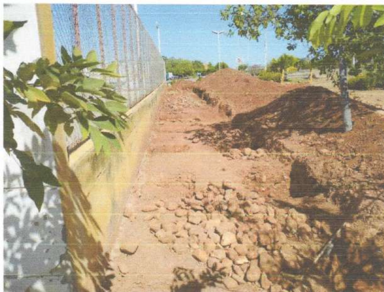
Figura 6 - ESCAVAÇÕES PARA EXECUÇÃO DE SAPATAS DE FUNDAÇÃO;
