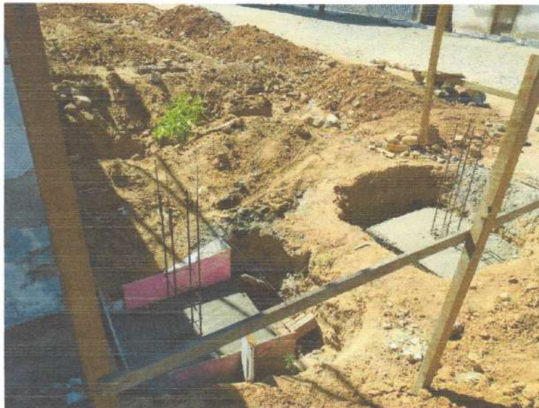
Figura 8 – CONCRETAGEM DE FUNDAÇÕES;
