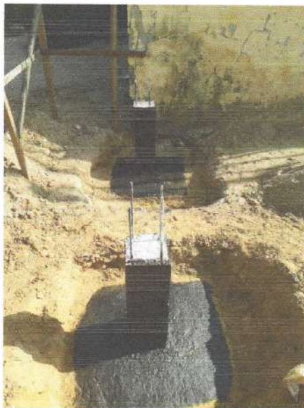
Figura 13 – CONCRETAGEM E IMPERMEABILIZAÇÃO DE SAPATAS DE FUNDAÇÕES;
