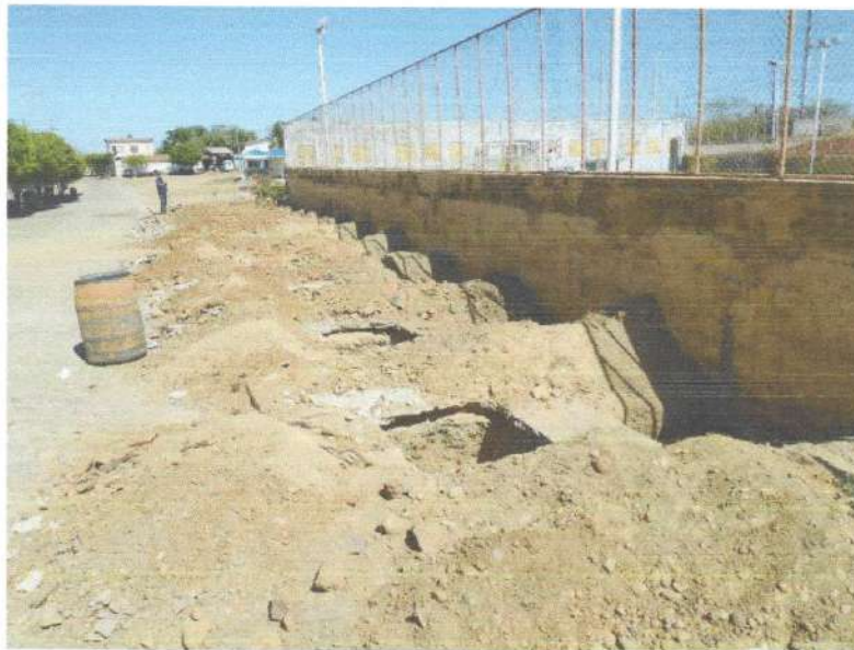
Figura 3 - ESCAVAÇÕES PARA EXECUÇÃO DE SAPATAS DE FUNDAÇÃO;
