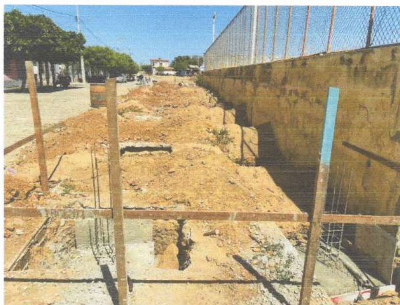
Figura 10 – CONCRETAGEM DE FUNDAÇÕES;
