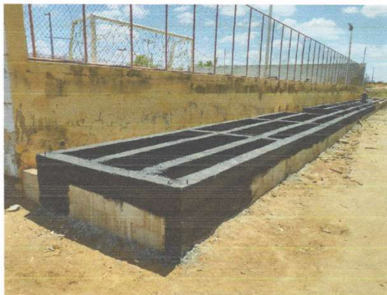
Figura 22 – CONCRETAGEM DE VIGAS E IMPERMEABILIZAÇÃO;
