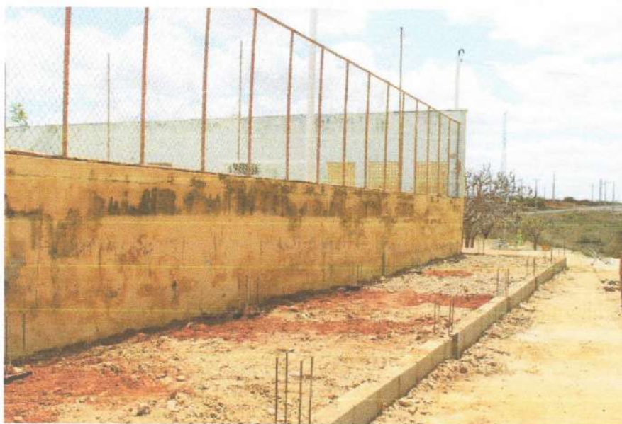
Figura 14 – MOVIMENTAÇÃO DE TERRA E REATERRO DE FUNDAÇÕES;
