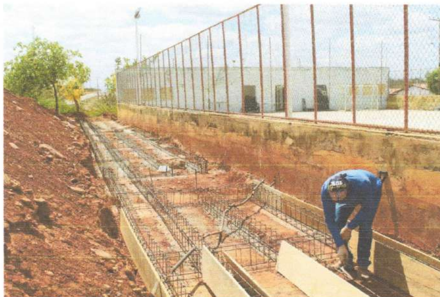
Figura 16 – EXECUÇÃO DE FORMAS E ARMADURAS;
