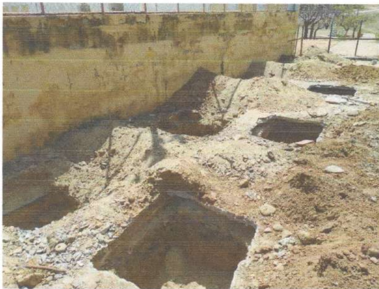
Figura 4 - ESCAVAÇÕES PARA EXECUÇÃO DE SAPATAS DE FUNDAÇÃO;
