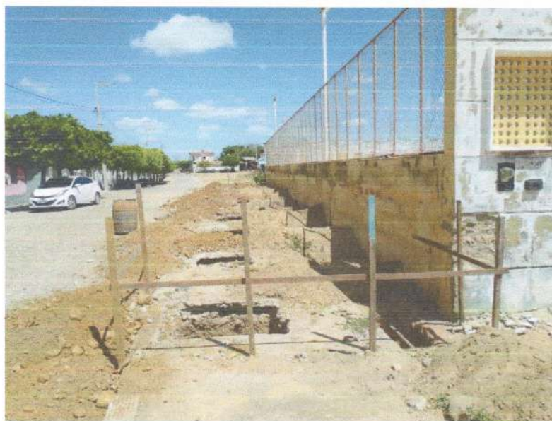
Figura 2 - EXECUÇÃO DE GABARITO PARA LOCAÇÃO DE OBRA;
