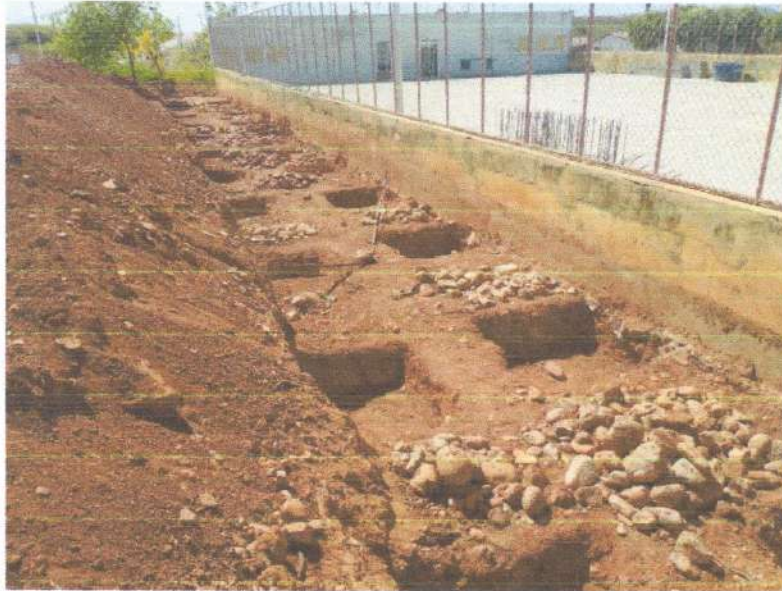
Figura 7 - ESCAVAÇÕES PARA EXECUÇÃO DE SAPATAS DE FUNDAÇÃO;
