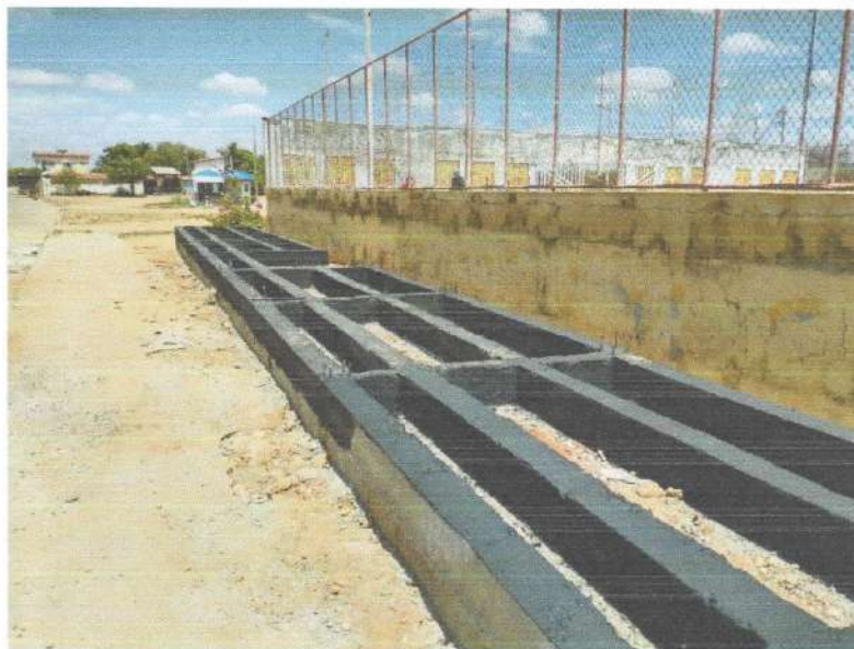
Figura 21 - CONCRETAGEM DE VIGAS E IMPERMEABILIZAÇÃO;
