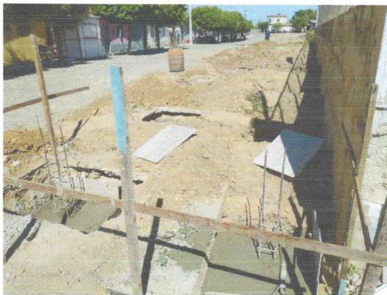
Figura 9 - CONCRETAGEM DE FUNDAÇÕES;
