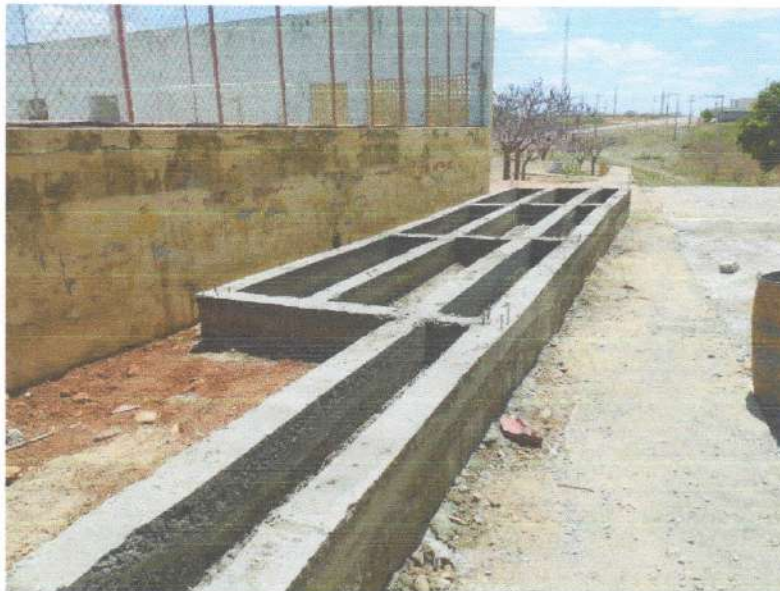
Figura 17 - CONCRETAGEM DE VIGAMENTO DAS ARQUIBANCADAS;
