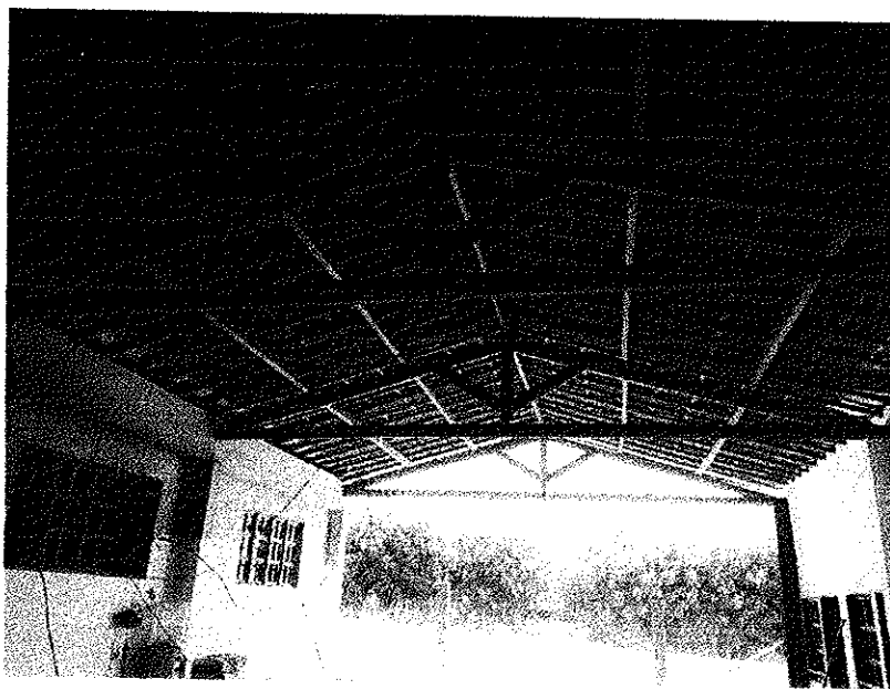
Figura 1 – EXECUÇÃO DE TESOURAS DE MADEIRA, TRAMA DE MADEIRA E COBERTURA EM TELHAS CERÂMICAS;
