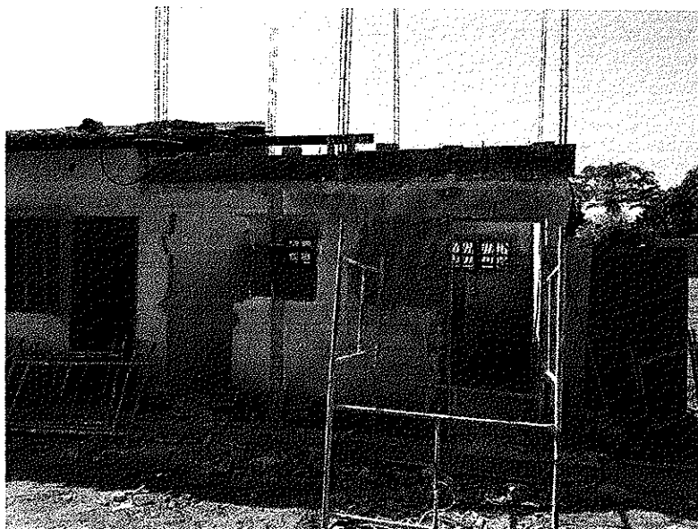
Figura 6 - EXECUÇÃO DE ESTRUTURAS DE CONCRETO ARMADO;
