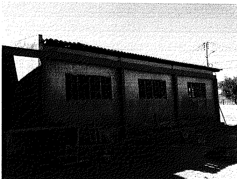
Figura 4 - EXECUÇÃO DE ESTRUTURAS DE CONCRETO ARMADO;
