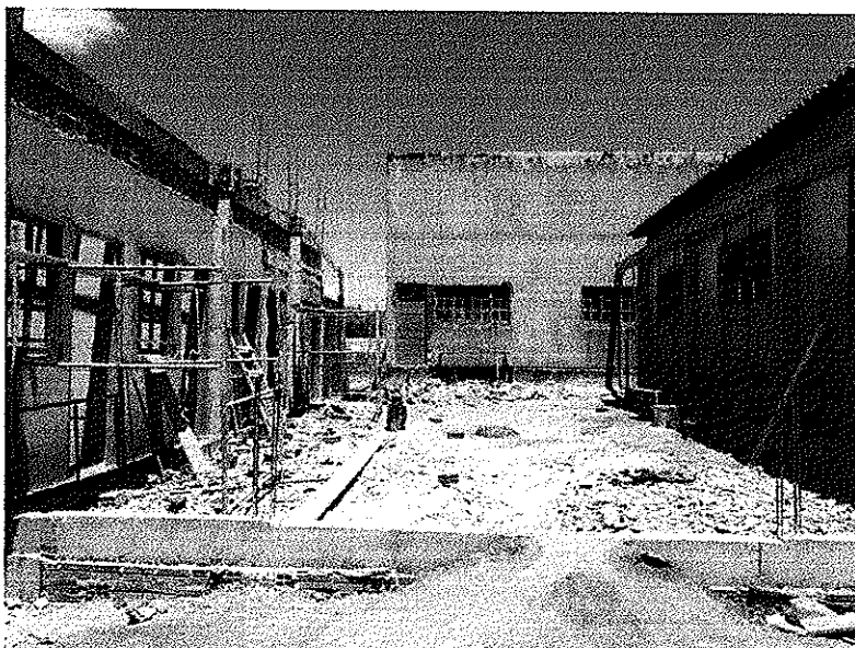
Figura 5 - EXECUÇÃO DE ALVENARIAS E ESTRUTURAS DE CONCRETO ARMADO;
