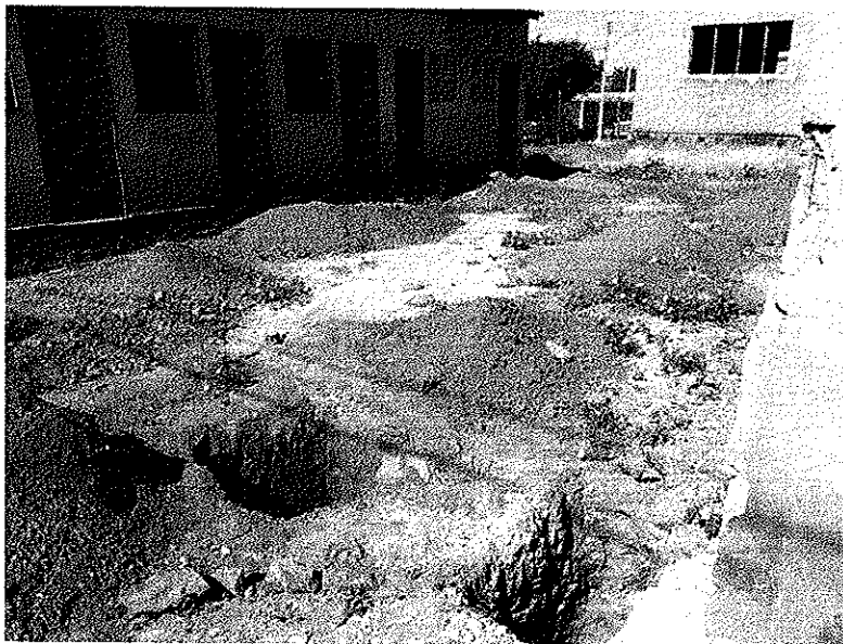
Figura 1 – EXECUÇÃO DA MOVIMENTAÇÃO DE TERRA, FUNDAÇÕES;
