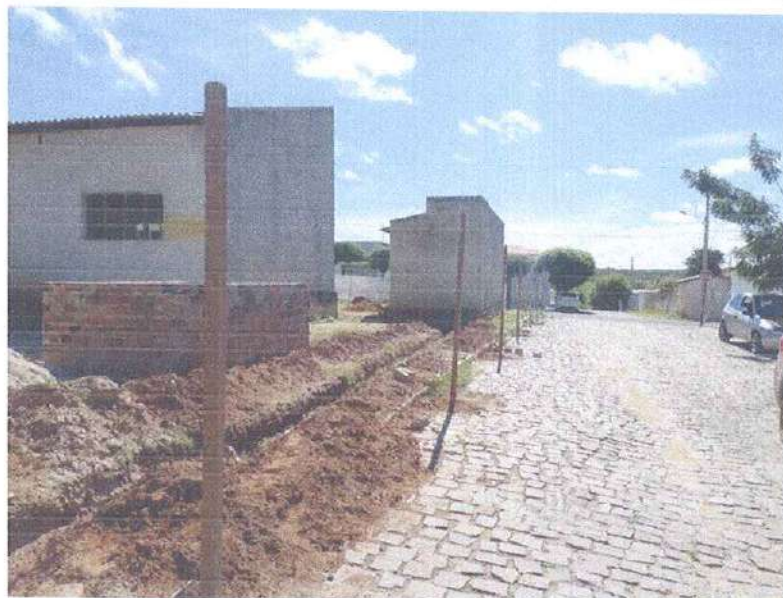
Figura 2 – EXECUÇÃO DE ESTRUTURAS PARA FIXAÇÃO DE TAPUMES COM TELHAS METÁLICAS;
