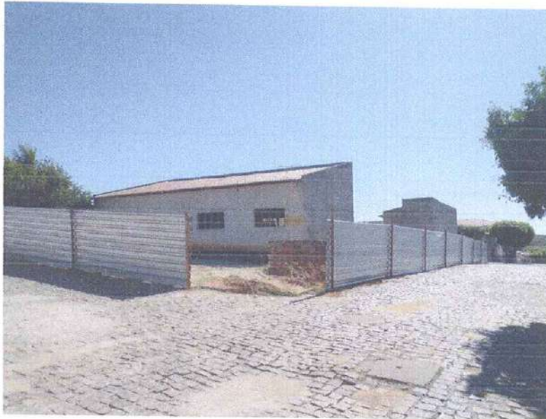
Figura 5 - TAPUMES COM TELHAS METÁLICAS;
