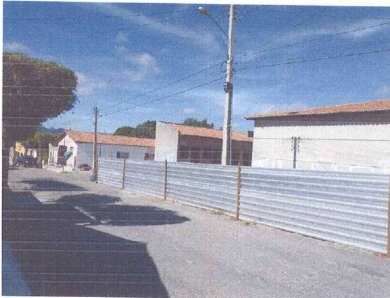
Figura 3 - TAPUMES COM TELHAS METALICAS;
