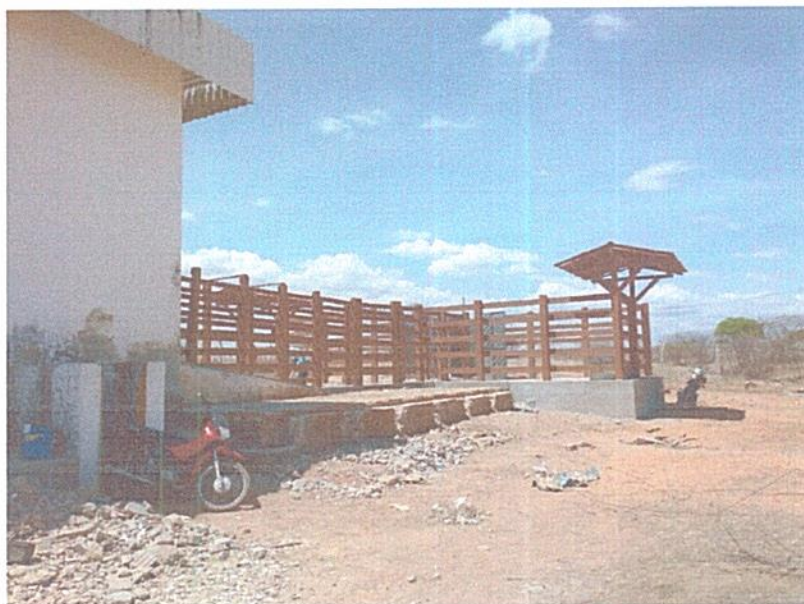
Figura 5 – EXECUÇÃO DE PINTURA DOS CURRAIS;
