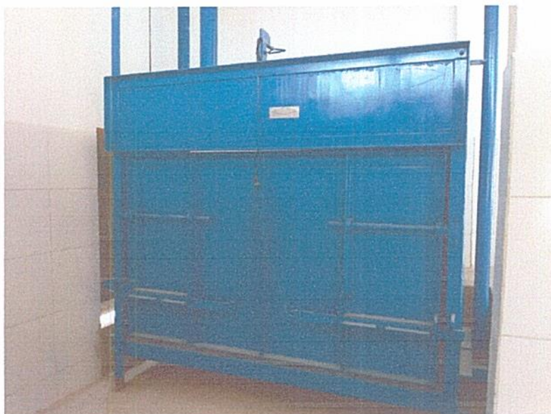
Figura 3 – EXECUÇÃO DE RECUPERAÇÃO E PINTURA DA CABINE DE ATORDOAMENTO;
