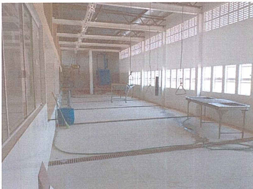
Figura 1 – EXECUÇÃO DE PISO EM GRANILITE NA ÁREA DE ABATE;
