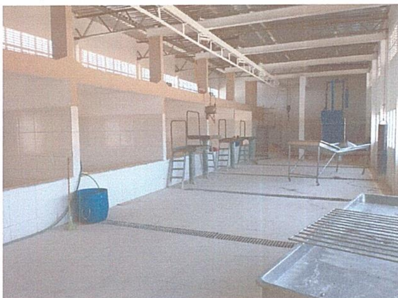
Figura 2 - EXECUÇÃO DE PISO EM GRANILITE NA ÁREA DE ABATE;
