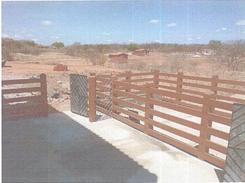
Figura 7 - EXECUÇÃO DE PINTURA DOS CURRAIS;
