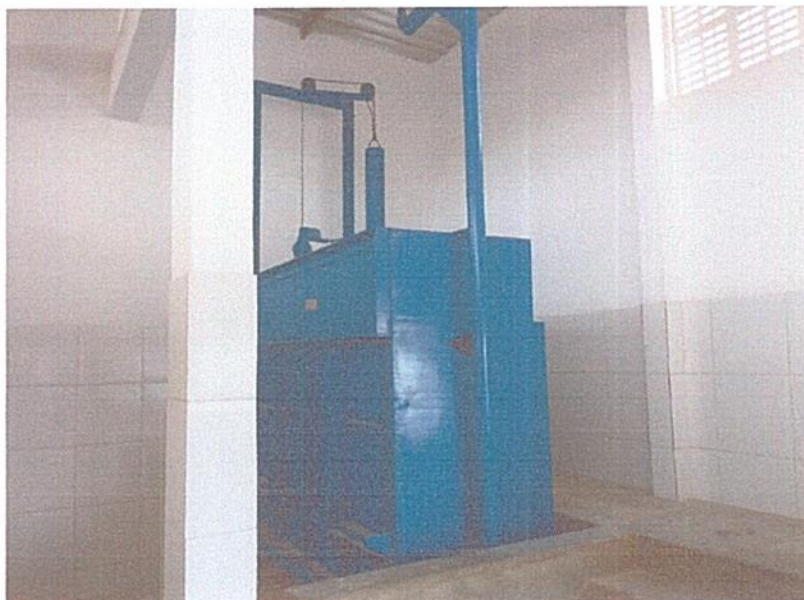
Figura 4 – EXECUÇÃO DE RECUPERAÇÃO E PINTURA DA CABINE DE ATORDOAMENTO;
