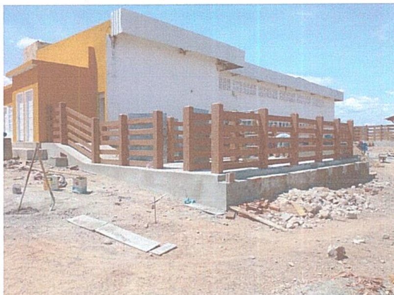
Figura 6 - EXECUÇÃO DE PINTURA DOS CURRAIS;
