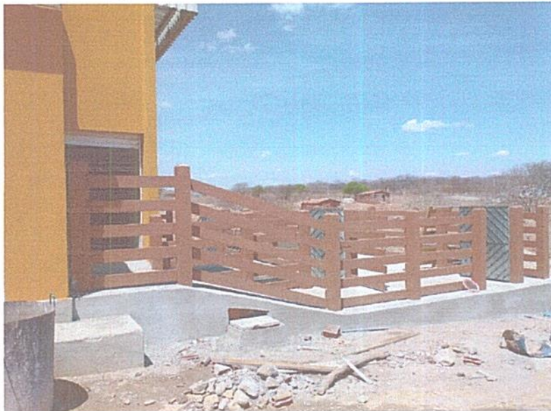
Figura 8 – EXECUÇÃO DE PINTURA DOS CURRAIS;
