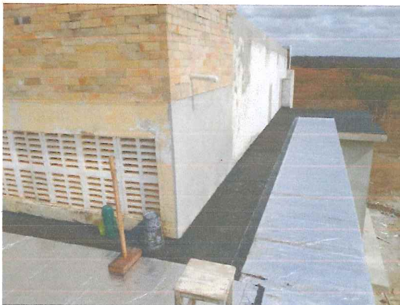
Figura 7 - EXECUÇÃO DE IMPERMEABILIZAÇÃO COM MANTA ASFÁLTICA;
