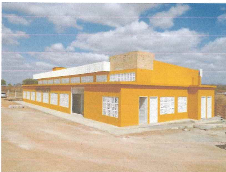
Figura 4 – EXECUÇÃO DE ACABAMENTOS E PINTURA EXTERNA;;
