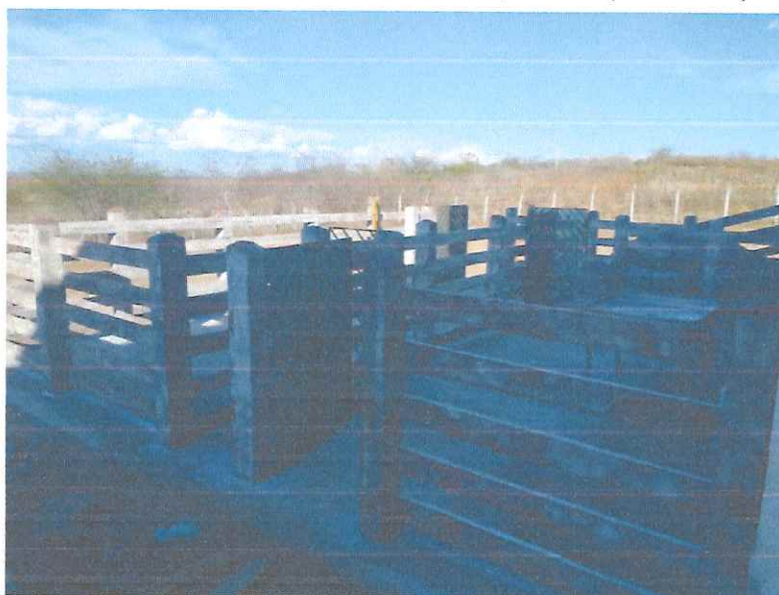
Figura 12 – EXECUÇÃO DE CURRAIS;
