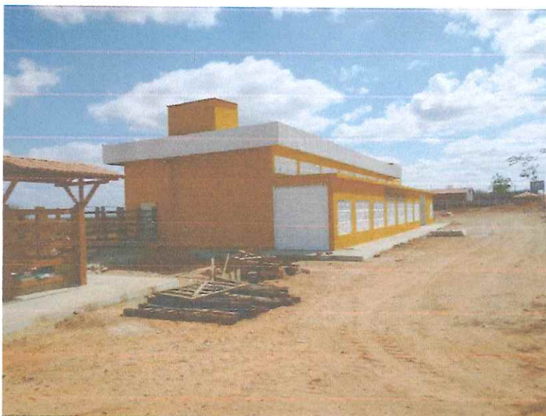
Figura 3 – EXECUÇÃO DE ACABAMENTOS E PINTURA EXTERNA;;
