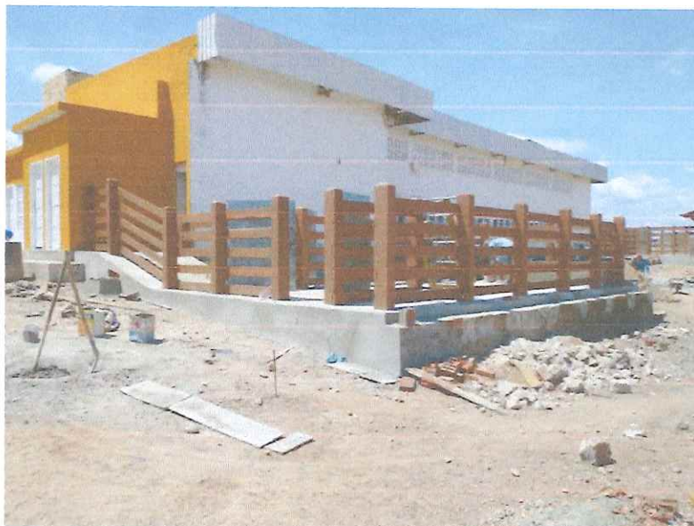
Figura 14 – EXECUÇÃO DE CURRAIS;
