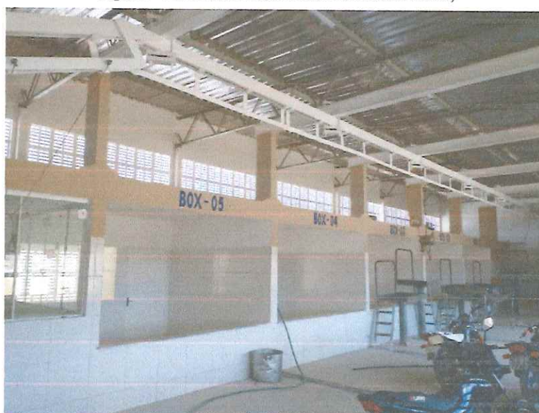
Figura 10 – PINTURA INTERNA DE PAREDES E TETO;
