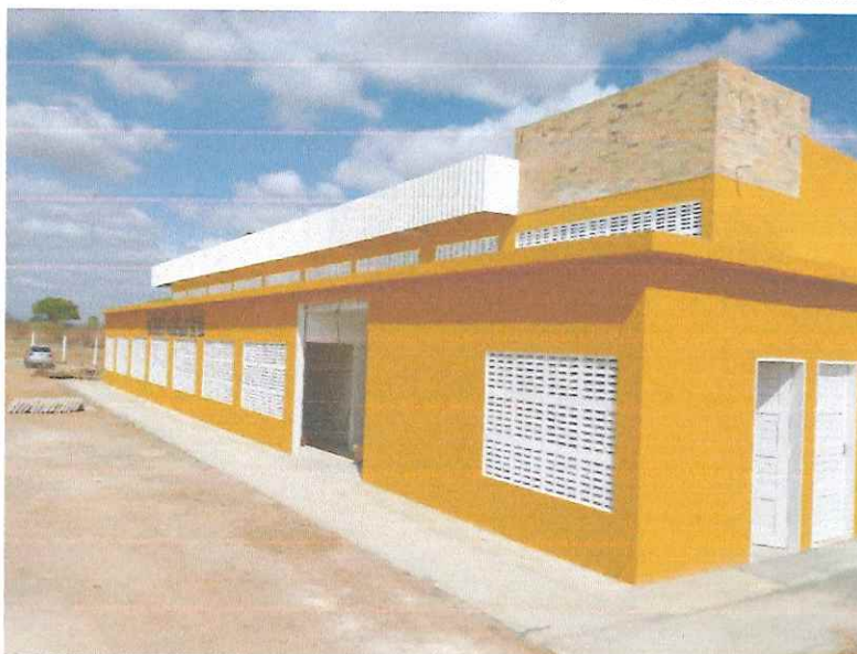
Figura 2 - EXECUÇÃO DE ACABAMENTOS E PINTURA EXTERNA;
