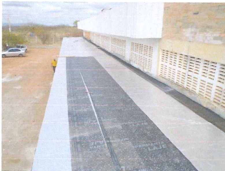
Figura 6 - EXECUÇÃO DE IMPERMEABILIZAÇÃO COM MANTA ASFÁLTICA;
