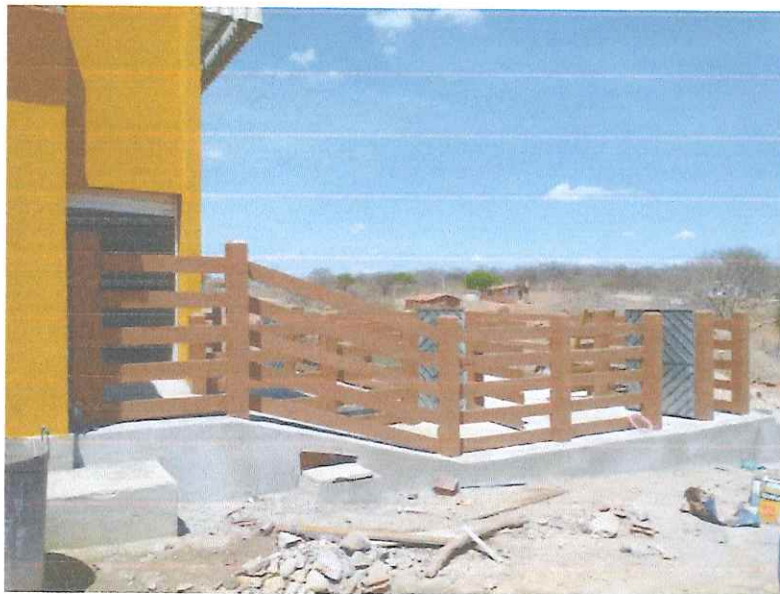
Figura 13 - EXECUÇÃO DE CURRAIS;
