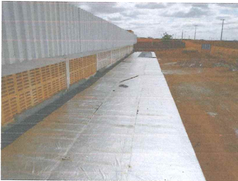
Figura 5 – EXECUÇÃO DE IMPERMEABILIZAÇÃO COM MANTA ASFÁLTICA;
