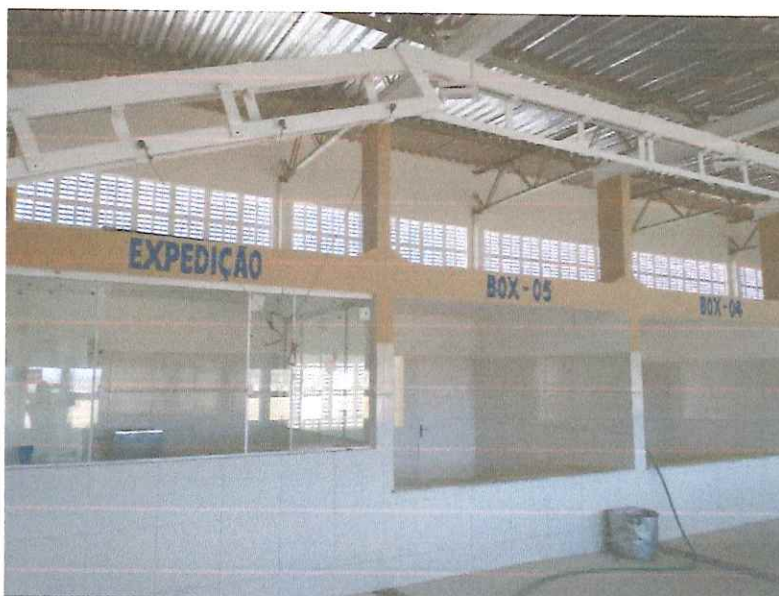
Figura 9 - PINTURA INTERNA DE PAREDES E TETO;
