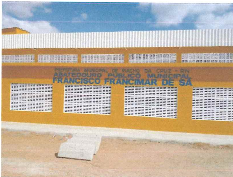
Figura 1 – EXECUÇÃO DE ACABAMENTOS E PINTURA EXTERNA (LETREIRO DE IDENTIFICAÇÃO DA OBRA);
