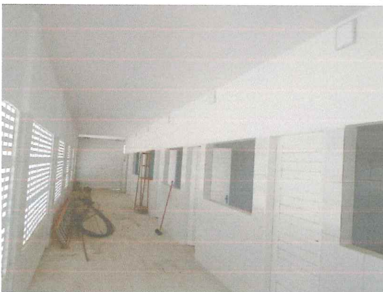
Figura 8 – INSTALAÇÃO DE LUMINÁRIAS LED, PINTURA INTERNA DE PAREDES E TETO;
