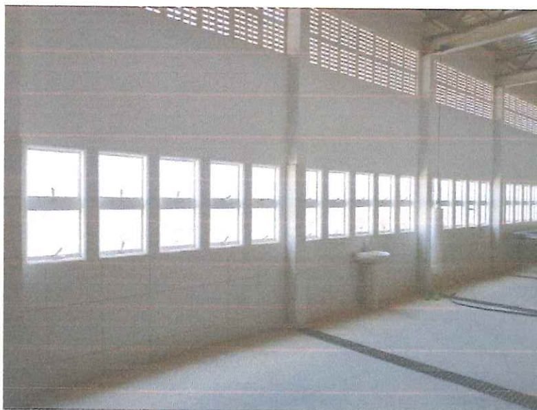
Figura 11 – EXECUÇÃO DE PINTURA INTERNA DE PAREDES, INSTALAÇÃO DE LOUÇAS E METAIS;
