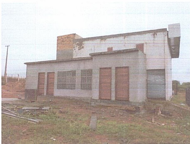
Figura 4 – EXECUÇÃO DE ESQUADRIAS DE MATEIRA (PORTAS);
