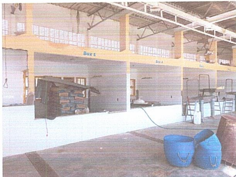
Figura 10 – EXECUÇÃO DE REVESTIMENTO CERÂMICO EM PAREDE;
