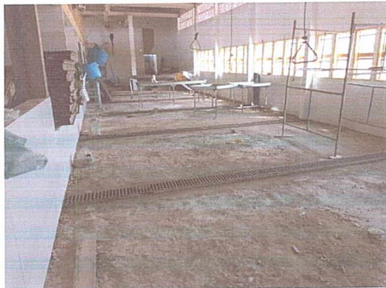
Figura 8 – EXECUÇÃO DE CONTRA PISO ARGAMASSADO;
