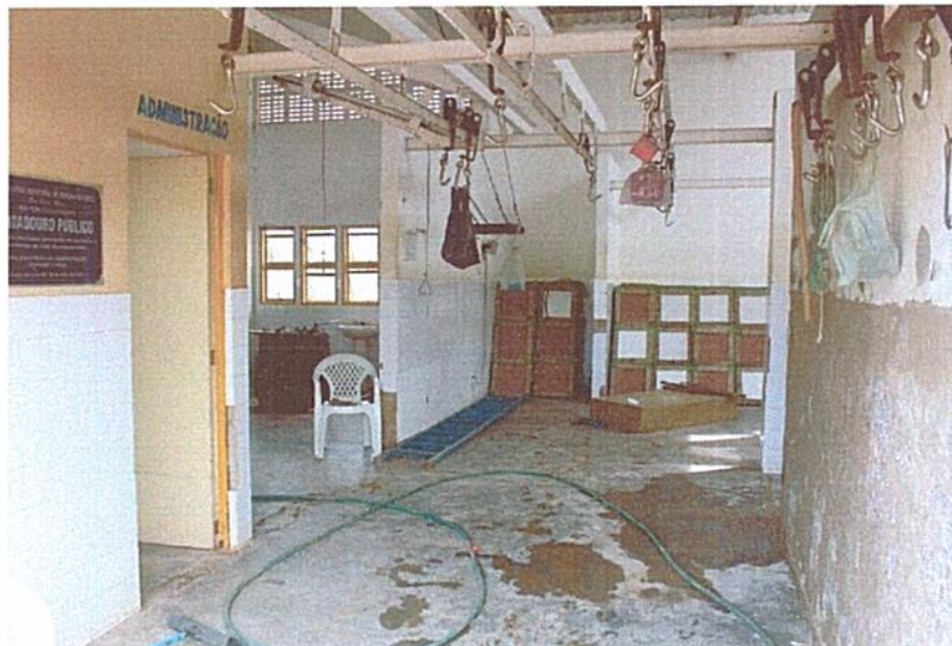
Figura 2 - REMOÇÃO DE REVESTIMENTO CERÂMICO;
