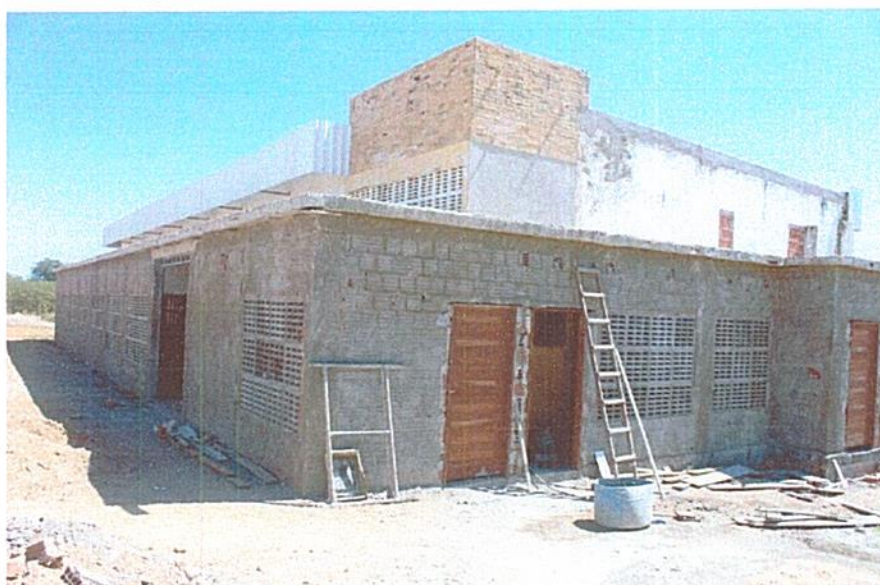
Figura 6 - EXECUÇÃO DE ALVENARIAS E ESTRUTURAS DE CONCRETO ARMADO;
