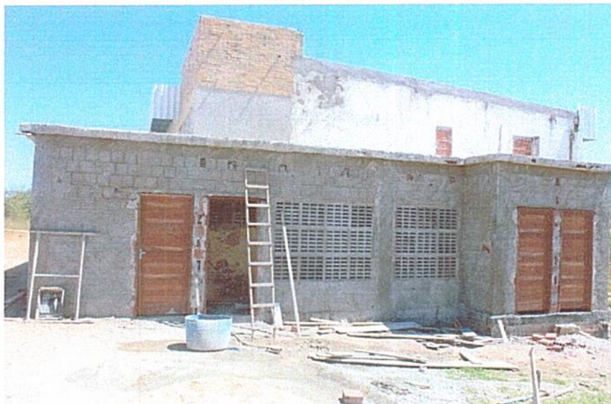
Figura 5 – EXECUÇÃO DE ALVENARIAS E ESTRUTURAS DE CONCRETO ARMADO;
