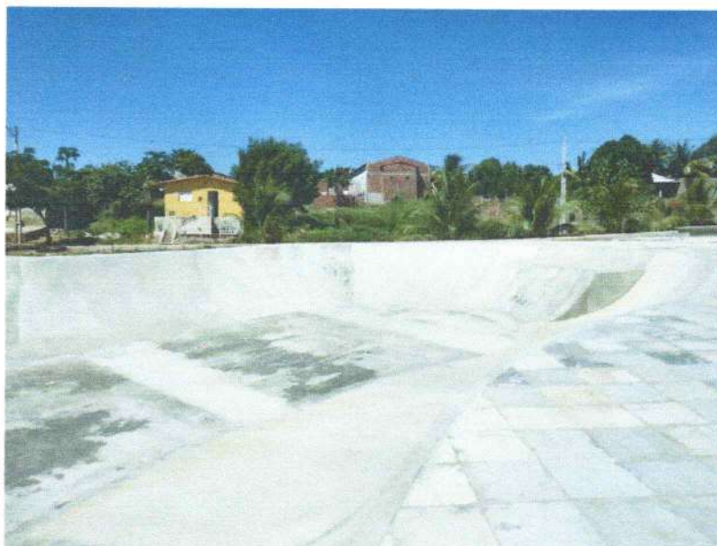
FIGURA 19 – EXECUÇÃO DE PISO EM CONCRETO, ACABAMENTO ARGAMASSADO DAS PAREDES BOWL E PISO EM PEDRA ANTÍQUA;
