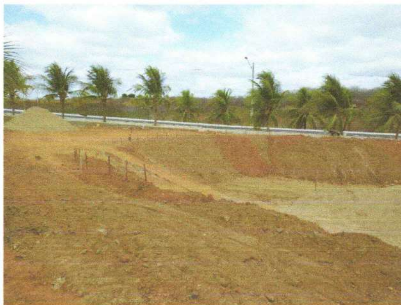
FIGURA 9 – DEMARCAÇÃO PARA INÍCIO DE EXECUÇÃO DE PISTA DE SKATE;
