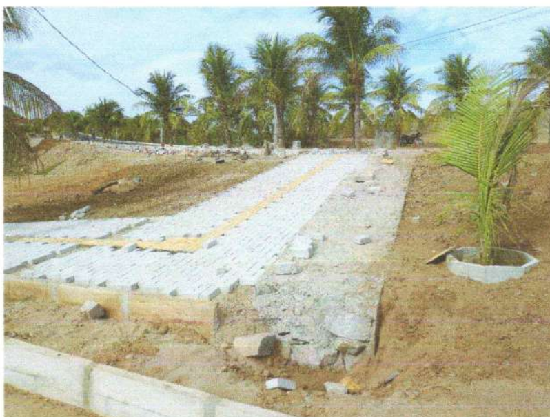
FIGURA 2 – EXECUÇÃO DE PISO INTERTRAVADO E PISO TÁTIL;
