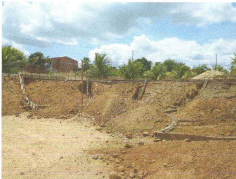
FIGURA 13 – EXECUÇÃO DE ALVENARIA EM TIJOLOS CERÂMICOS E ESTRUTURAS DE CONCRETO ARMADO;
