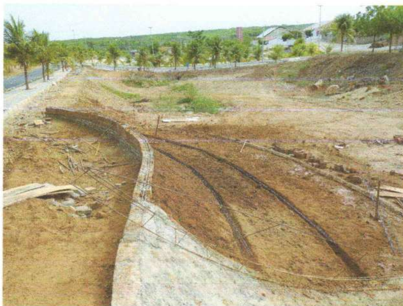
FIGURA 15 – EXECUÇÃO E ESTRUTURAS E PISO DE CONCRETO ARMADO;
