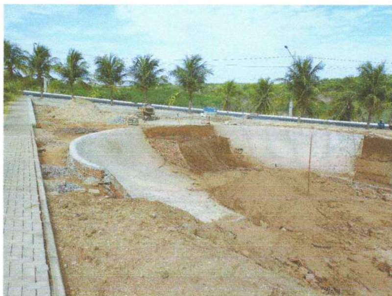
FIGURA 16 - EXECUÇÃO E ESTRUTURAS E PISO DE CONCRETO ARMADO;
