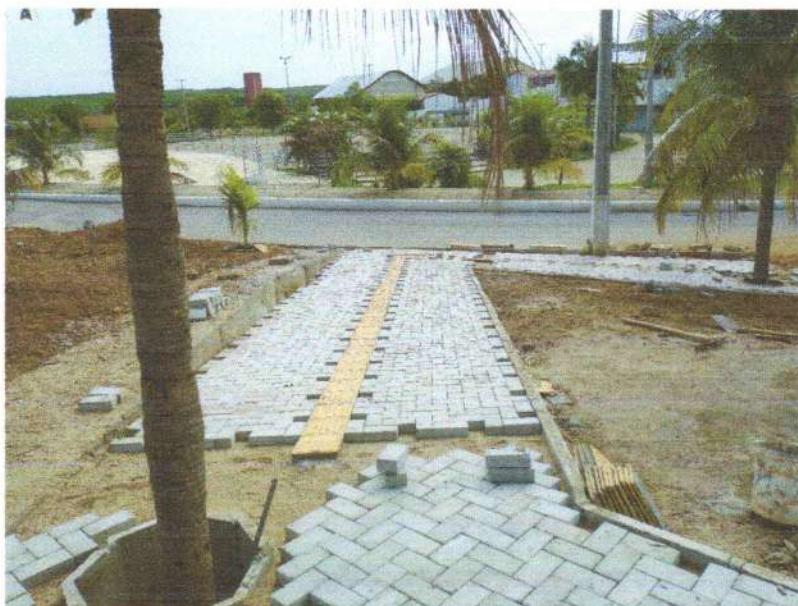
FIGURA 1 – EXECUÇÃO DE PISO INTERTRAVADO E PISO TÁTIL;
