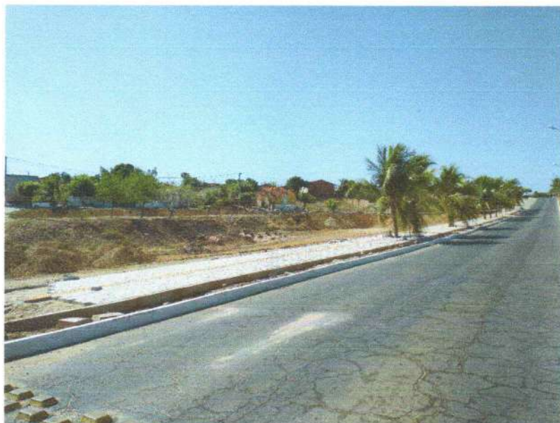
FIGURA 3 – EXECUÇÃO DE PISO INTERTRAVADO E PISO TÁTIL;
