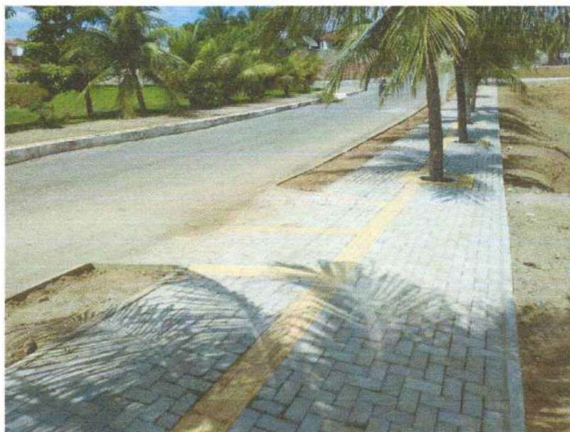
FIGURA 5 – EXECUÇÃO DE PISO INTERTRAVADO E PISO TÁTIL;
