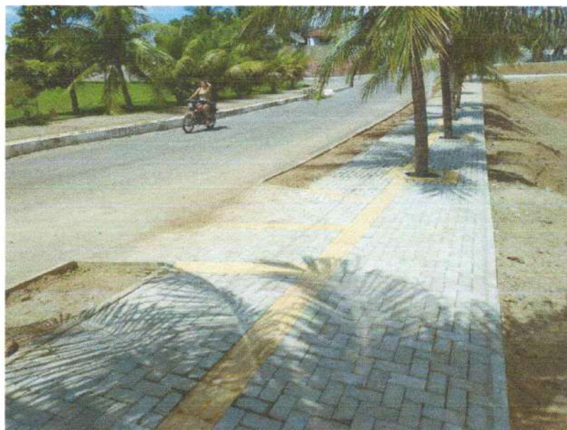
FIGURA 8 - EXECUÇÃO DE PISO INTERTRAVADO E PISO TÁTIL;
