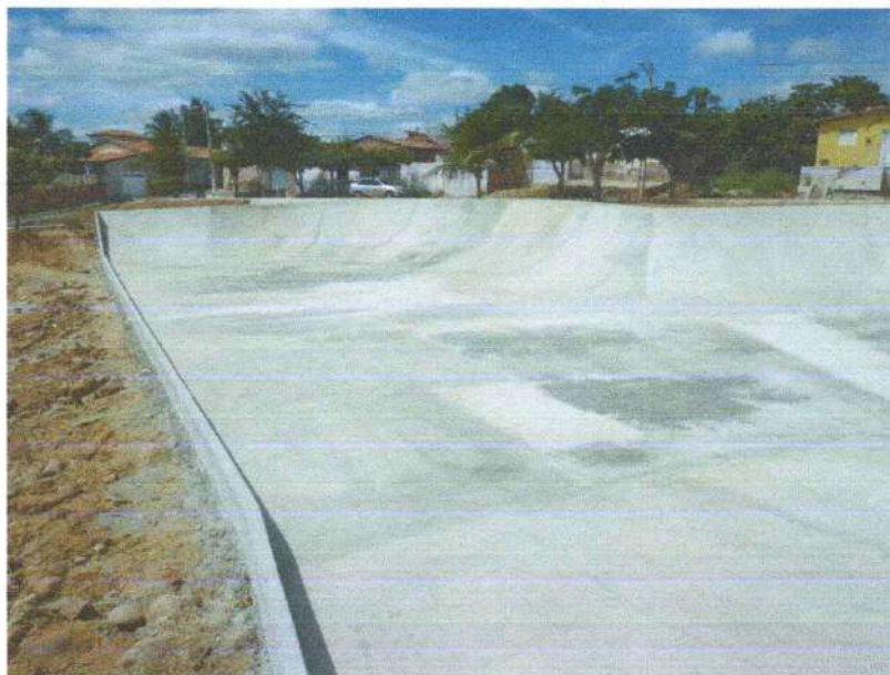
FIGURA 17 – EXECUÇÃO DE PISO EM CONCRETO, ACABAMENTO ARGAMASSADO DAS PAREDES BOWL E EXECUÇÃO DE MURETA DE DELIMITAÇÃO;
