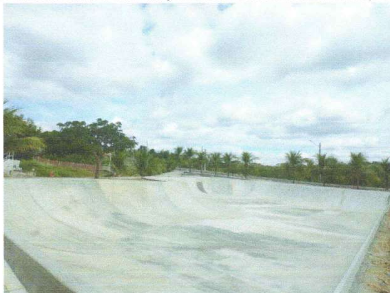
FIGURA 18 - EXECUÇÃO DE PISO EM CONCRETO, ACABAMENTO ARGAMASSADO DAS PAREDES BOWL;
