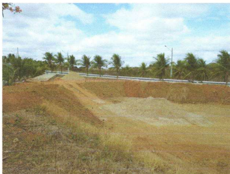
FIGURA 10 - DEMARCAÇÃO PARA INÍCIO DE EXECUÇÃO DE PISTA DE SKATE;
