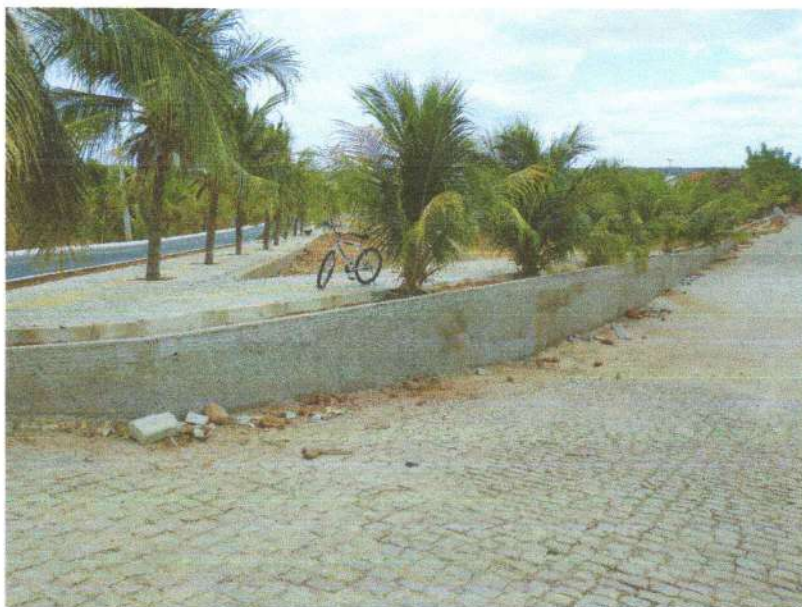
FIGURA 4 - EXECUÇÃO DE PISO INTERTRAVADO E PISO TÁTIL;
