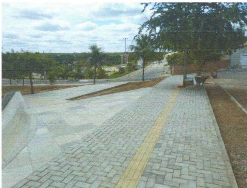
FIGURA 21 – EXECUÇÃO DE PISO EM PEDRA ANTÍQUA;
