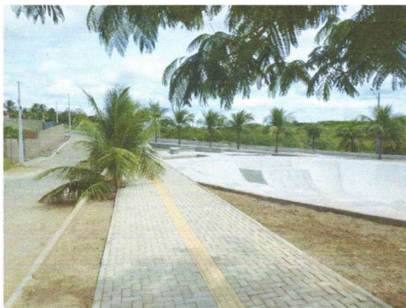
FIGURA 6 - EXECUÇÃO DE PISO INTERTRAVADO E PISO TÁTIL;
