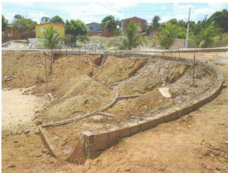
FIGURA 11 – EXECUÇÃO DE ALVENARIA EM TIJOLOS CERÂMICOS E ESTRUTURAS DE CONCRETO ARMADO;
