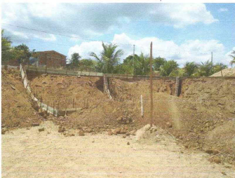
FIGURA 12 - EXECUÇÃO DE ALVENARIA EM TIJOLOS CERÂMICOS E ESTRUTURAS DE CONCRETO ARMADO;
