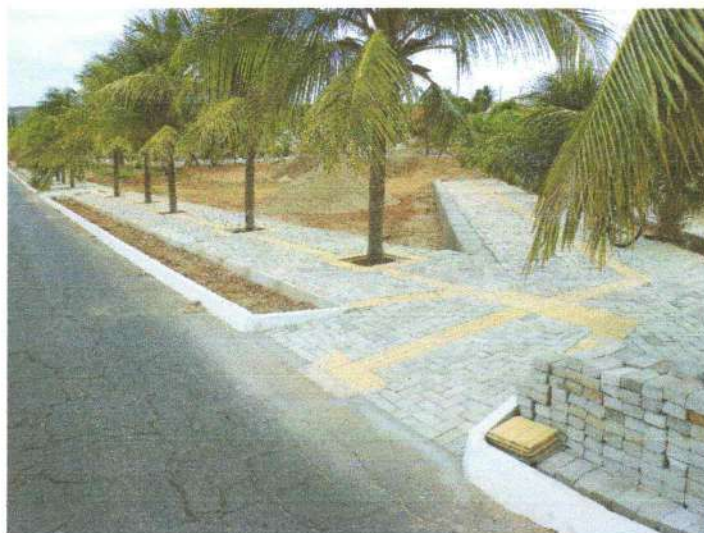
FIGURA 7 – EXECUÇÃO DE PISO INTERTRAVADO E PISO TÁTIL;
