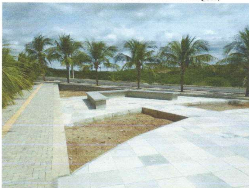
FIGURA 20 - EXECUÇÃO DE PISO EM PEDRA ANTÍQUA E BANCOS EM ALVENARIA;
