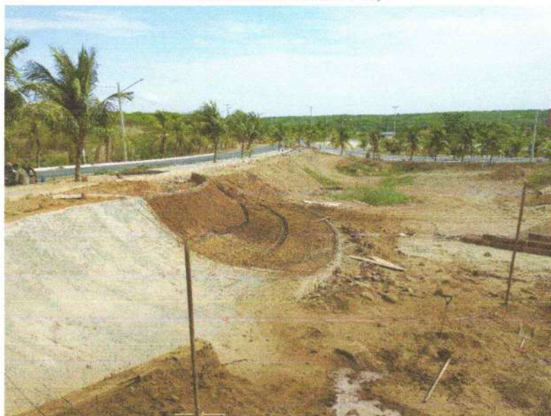
FIGURA 14 - EXECUÇÃO E ESTRUTURAS E PISO DE CONCRETO ARMADO;
