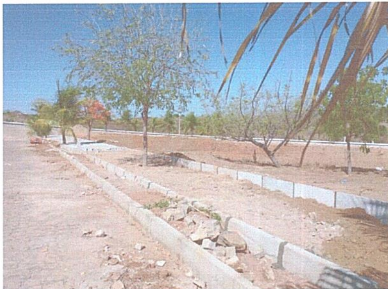
FIGURA 7 – EXECUÇÃO DE SERVIÇOS DE ASSENTAMENTO DE GUIA (MEIO-FIO) EM CONCRETO;
