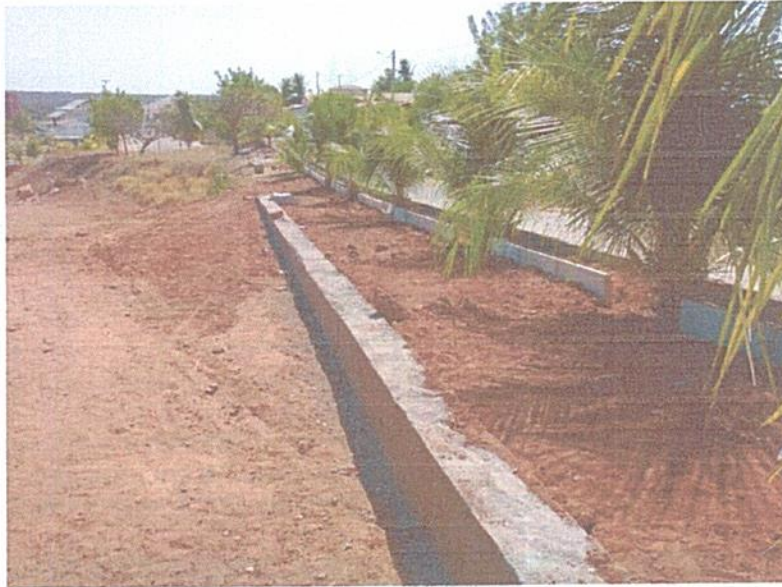
FIGURA 5 – EXECUÇÃO DE SERVIÇOS DE ASSENTAMENTO DE GUIA (MEIO-FIO) EM CONCRETO;
