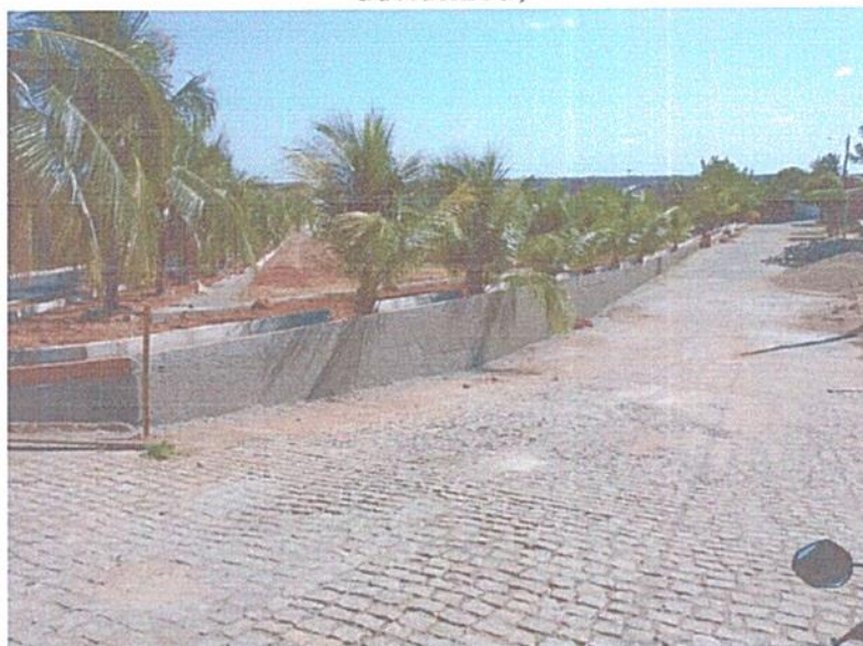
FIGURA 2 – EXECUÇÃO DE SERVIÇOS DE ASSENTAMENTO DE GUIA (MEIO-FIO) EM CONCRETO;
