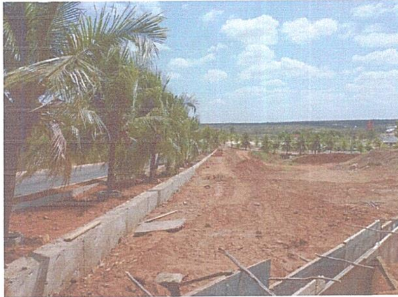
FIGURA 3 – EXECUÇÃO DE SERVIÇOS DE ASSENTAMENTO DE GUIA (MEIO-FIO) EM CONCRETO;
