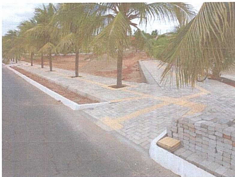
FIGURA 1 – EXECUÇÃO DE SERVIÇOS DE ASSENTAMENTO DE GUIA (MEIO-FIO) EM CONCRETO;
