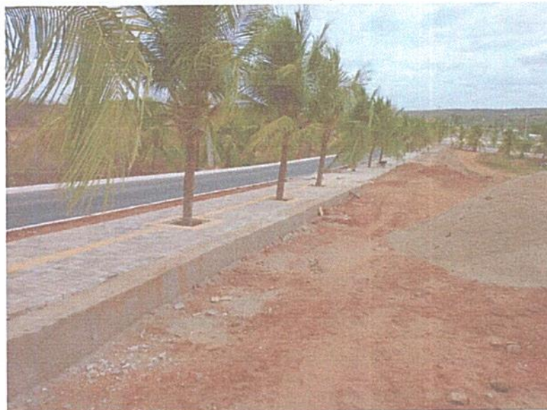
FIGURA 6 - EXECUÇÃO DE SERVIÇOS DE ASSENTAMENTO DE GUIA (MEIO-FIO) EM CONCRETO;
