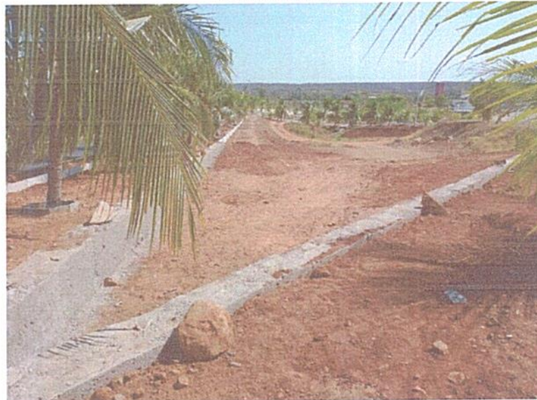
FIGURA 4 - EXECUÇÃO DE SERVIÇOS DE ASSENTAMENTO DE GUIA (MEIO-FIO) EM CONCRETO;
