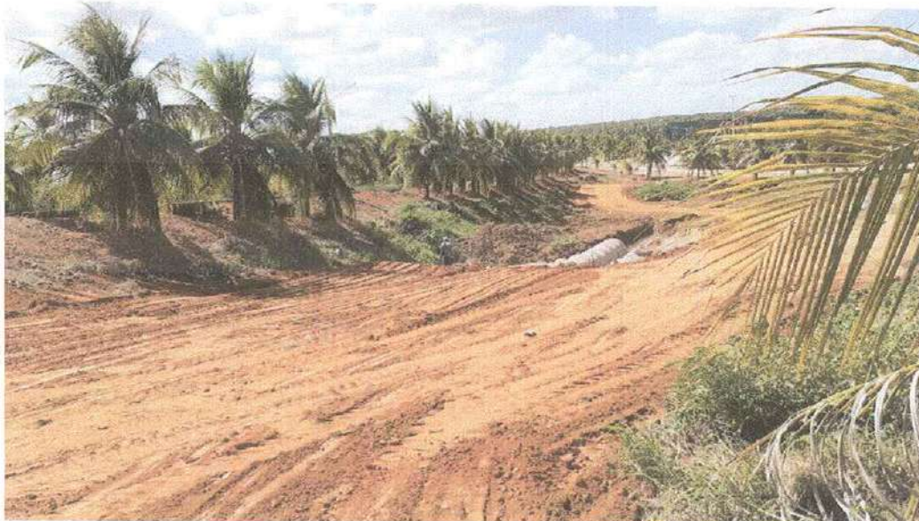
Figura 4 - EXECUÇÃO DE SERVIÇOS DE MOVIMENTAÇÃO DE TERRA;
