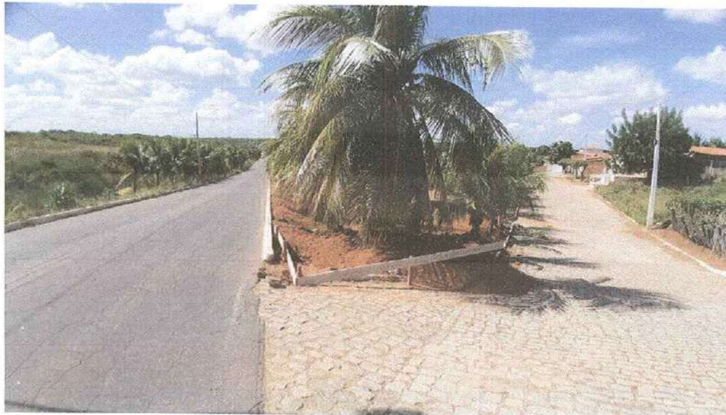
Figura 2 – EXECUÇÃO DE SERVIÇOS DE LOCAÇÃO DE OBRA;
