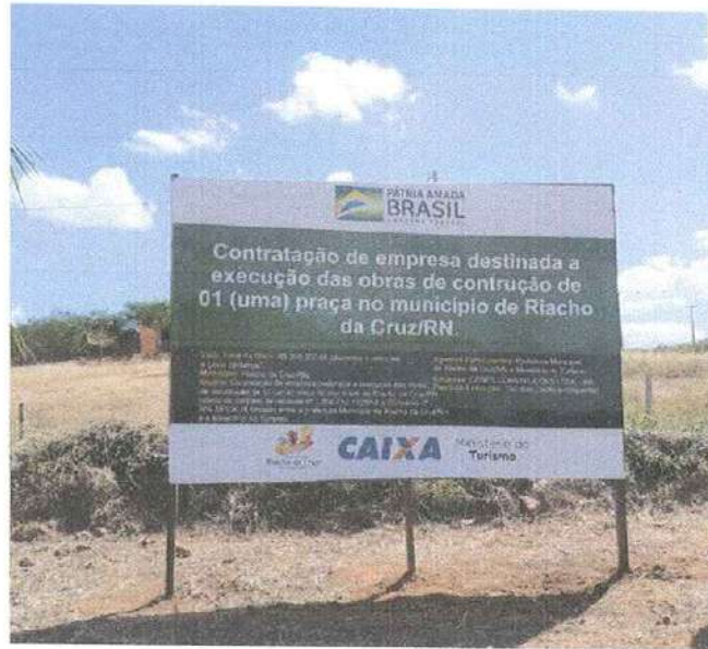
Figura 1 - PLACA DA OBRA EM CHAPA DE AÇO GALVANIZADO;
