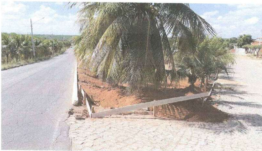
Figura 3 – EXECUÇÃO DE SERVIÇOS DE LOCAÇÃO DE OBRA;
