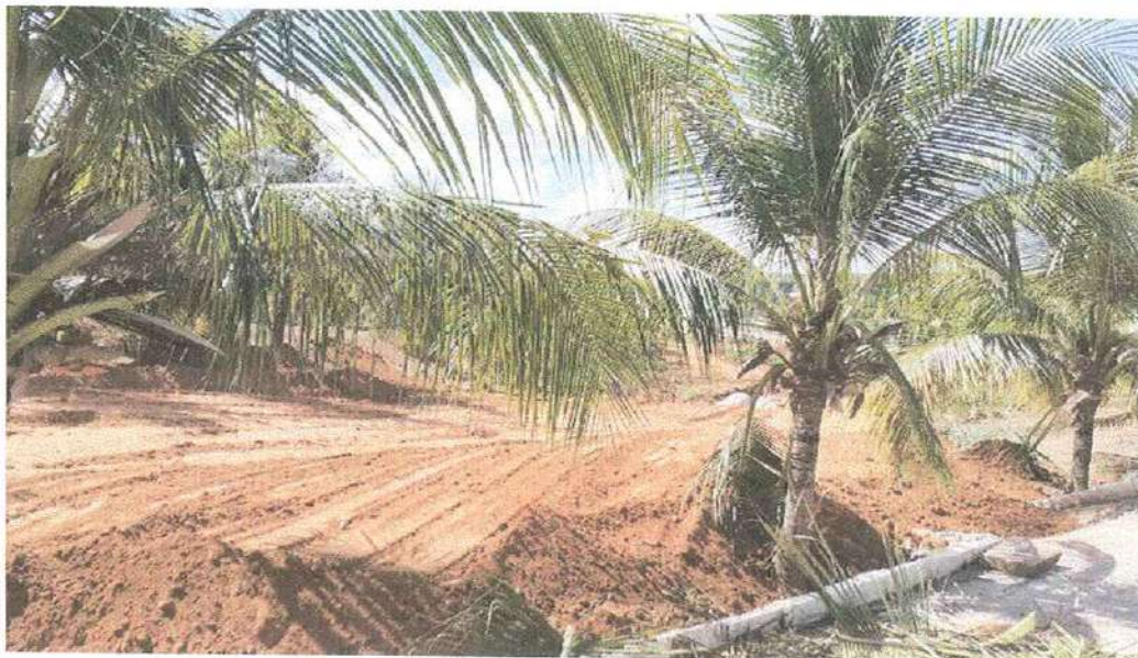
Figura 5 – EXECUÇÃO DE SERVIÇOS DE MOVIMENTAÇÃO DE TERRA;
