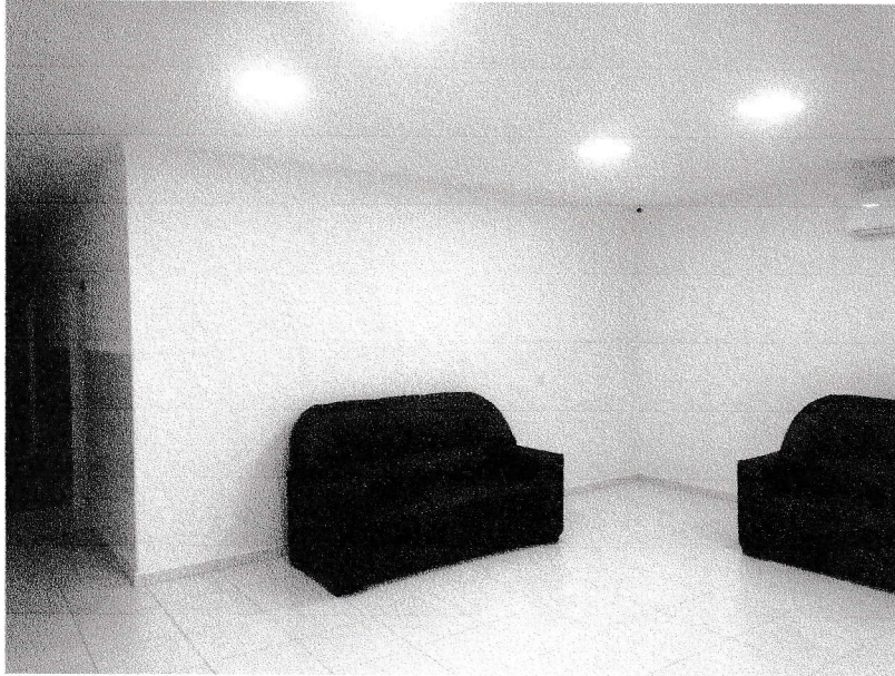
FIGURA 3 – EXECUÇÃO DE PINTURA - RECEPÇÃO;
