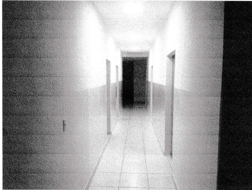
FIGURA 6 – EXECUÇÃO DE PINTURA – CIRCULAÇÃO 01;
