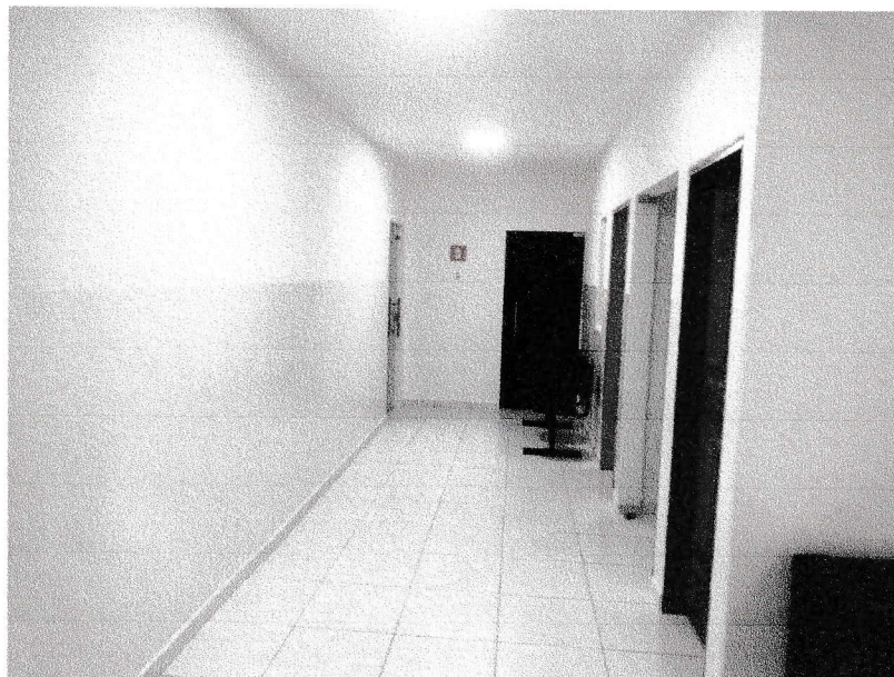
FIGURA 9 – EXECUÇÃO DE PINTURA – CIRCULAÇÃO 03;
