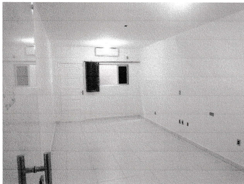
FIGURA 7 – EXECUÇÃO DE PINTURA – SECRETARIA DE CULTURA;
