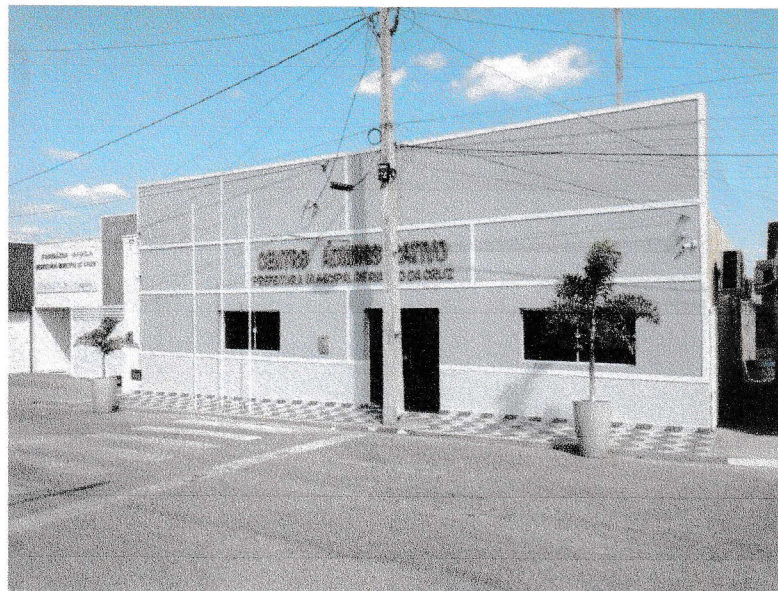
FIGURA 2 - EXECUÇÃO DE REVESTIMENTO CERAMICO CALÇADA DA FACHADA PRINCIPAL
