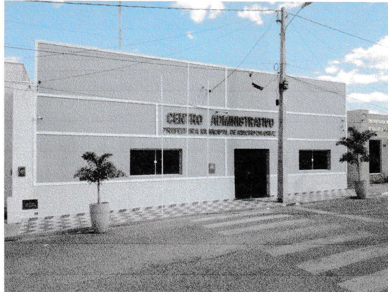
FIGURA 1 – EXECUÇÃO DE REVESTIMENTO CERAMICO CALÇADA DA FACHADA PRINCIPAL;
