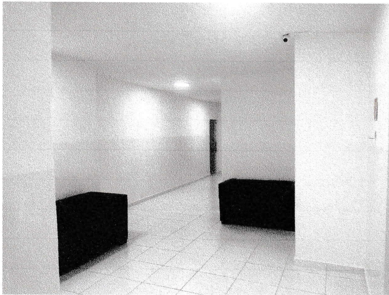
FIGURA 8 – EXECUÇÃO DE PINTURA – CIRCULAÇÃO 02;
