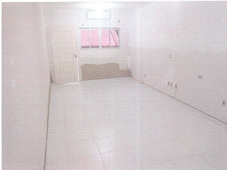
FIGURA 9 - EXECUÇÃO DE REVESTIMENTO CERÂMICO E SERVIÇOS DE PINTURA – SECRETARIA DE CULTURA;
