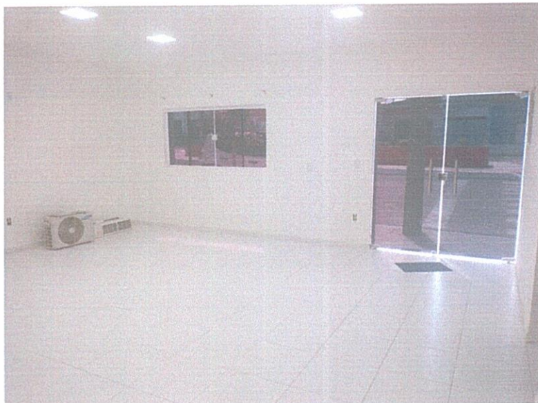
FIGURA 1 – EXECUÇÃO DE REVESTIMENTO CERÂMICO – RECEPÇÃO;
