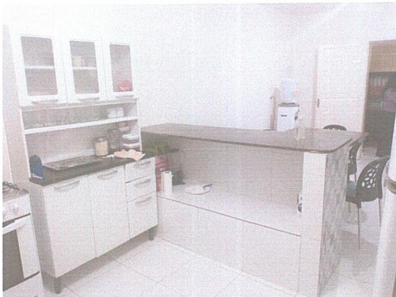
FIGURA 5 – EXECUÇÃO DE REVESTIMENTO CERÂMICO E SERVIÇOS DE PINTURA – COPA;
