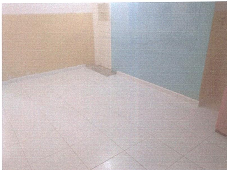
FIGURA 3 – EXECUÇÃO DE REVESTIMENTO CERÂMICO – CIRCULAÇÃO 02;
