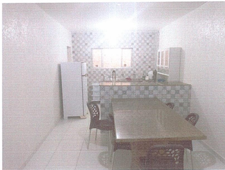
FIGURA 4 - EXECUÇÃO DE REVESTIMENTO CERÂMICO E SERVIÇOS DE PINTURA – COPA;
