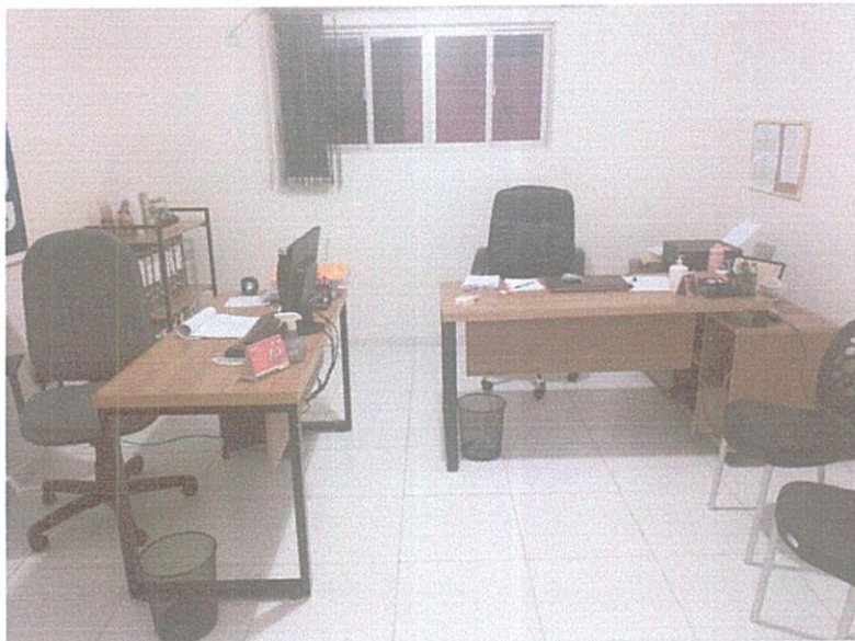
FIGURA 7 – EXECUÇÃO DE REVESTIMENTO CERÂMICO E SERVIÇOS DE PINTURA – SETOR DE COMPRAS;
