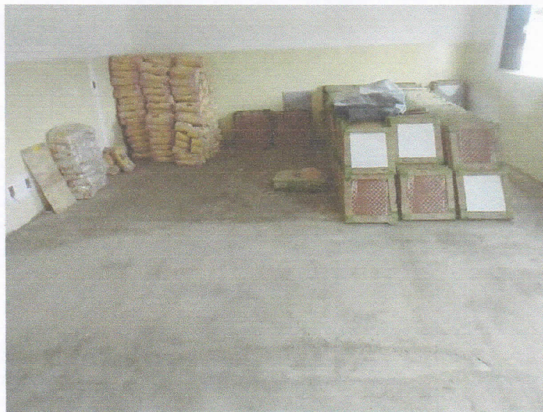
FIGURA 2 - EXECUÇÃO DE PISO CIMENTADO APÓS DEMOLIÇÃO DE PISO EXISTENTE - RECEPÇÃO;
