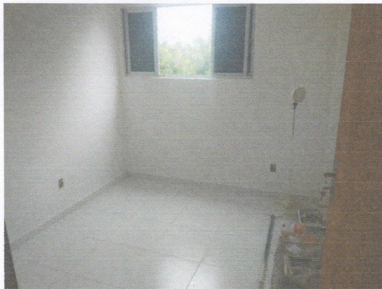
FIGURA 10 - EXECUÇÃO DE PISO CERÂMICO, RODAPÉ CERÂMICO E PINTURA – SALA 05;
