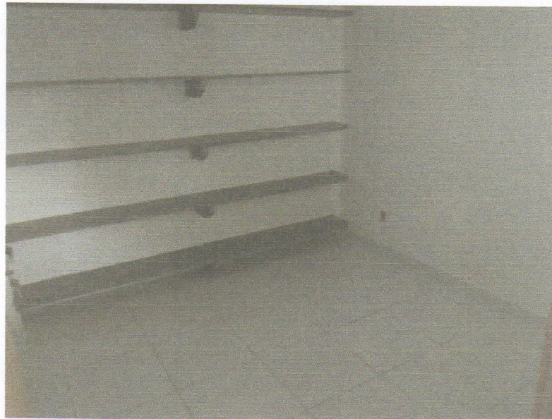
FIGURA 12 - EXECUÇÃO DE PISO CERÂMICO, RODAPÉ CERÂMICO E PINTURA – SALA 03;
