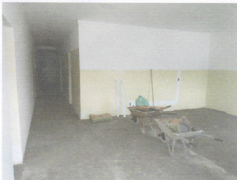
FIGURA 14 – EXECUÇÃO DE RODA TETO EM GESSO;
