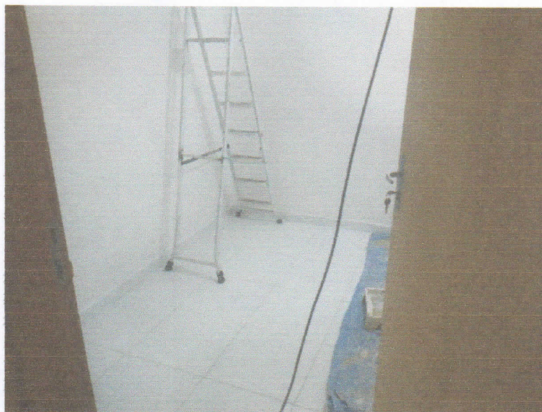
FIGURA 13 – EXECUÇÃO DE PISO CERÂMICO, RODAPÉ CERÂMICO E PINTURA – RECURSOS HUMANOS;
