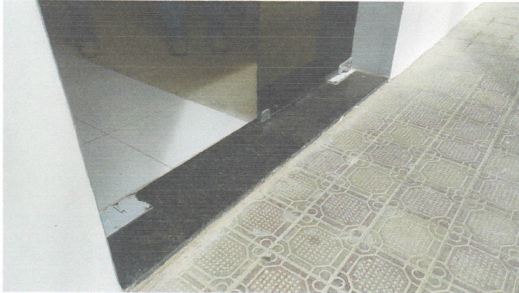
FIGURA 15 – EXECUÇÃO DE SOLEIRA EM GRANITO (PORTA PRINCIPAL DO CENTRO ADMINISTRATIVO);
