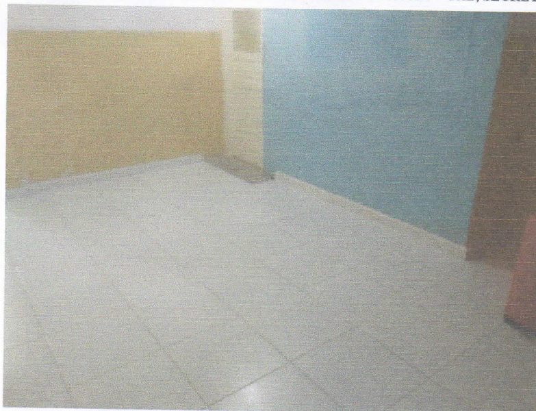
FIGURA 8 – EXECUÇÃO DE PISO CERÂMICO E RODAPÉ CERÂMICO – CIRCULAÇÃO 02;
