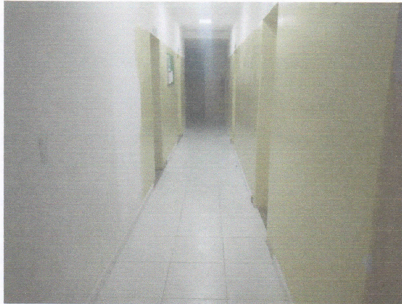
FIGURA 5 – EXECUÇÃO DE PISO CERÂMICO E RODAPÉ CERÂMICO – CIRCULAÇÃO 01;
