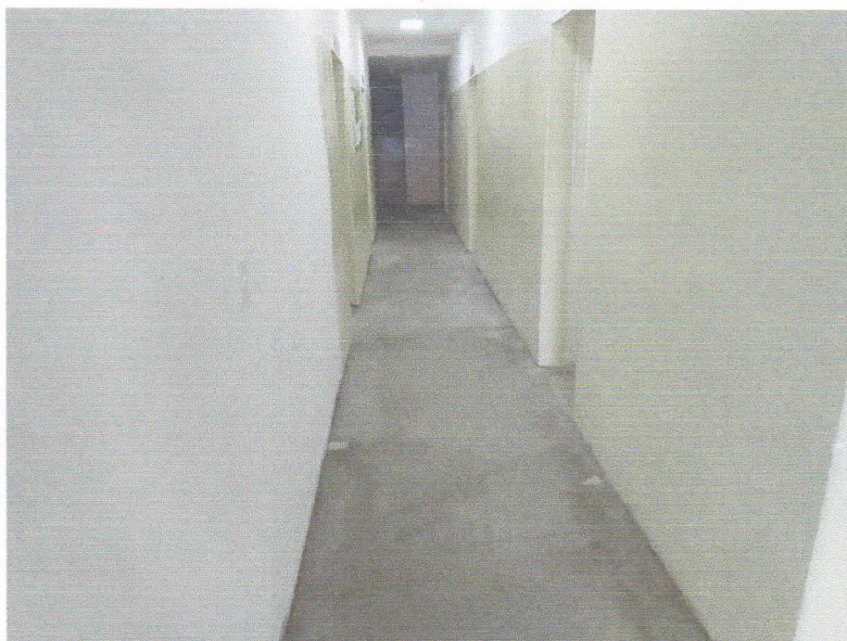
FIGURA 3 – EXECUÇÃO DE PISO CIMENTADO APÓS DEMOLIÇÃO DE PISO EXISTENTE – CIRCULAÇÃO 01;
