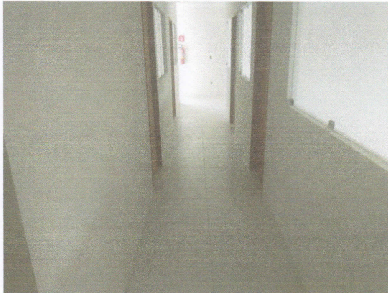
FIGURA 9 – EXECUÇÃO DE PISO CERÂMICO, RODAPÉ CERÂMICO E PINTURA – CIRCULAÇÃO 04;
