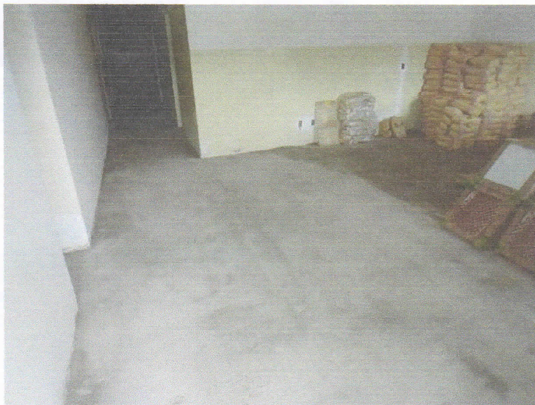
FIGURA 1 – EXECUÇÃO DE PISO CIMENTADO APÓS DEMOLIÇÃO DE PISO EXISTENTE – RECEPÇÃO;
