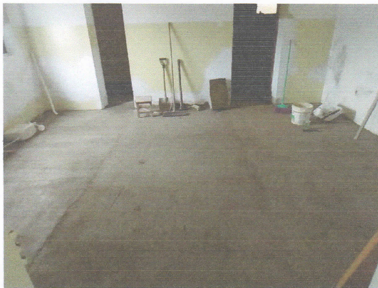
FIGURA 4 - EXECUÇÃO DE PISO CIMENTADO APÓS DEMOLIÇÃO DE PISO EXISTENTE – SECRETARIA DE SAÚDE;
