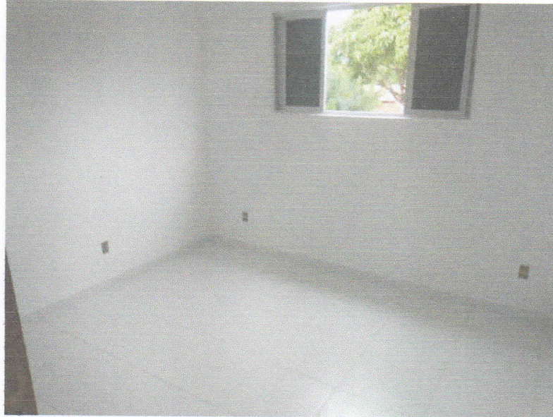
FIGURA 11 – EXECUÇÃO DE PISO CERÂMICO, RODAPÉ CERÂMICO E PINTURA – SALA 04;
