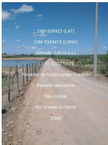
FIGURA 30 – EXECUÇÃO DE ESTRADAS VICINAIS NO MUNICÍPIO DE RIACHO DA CRUZ – RN - TRECHO NA COMUNIDADE BAIXA DO ARROZ;
