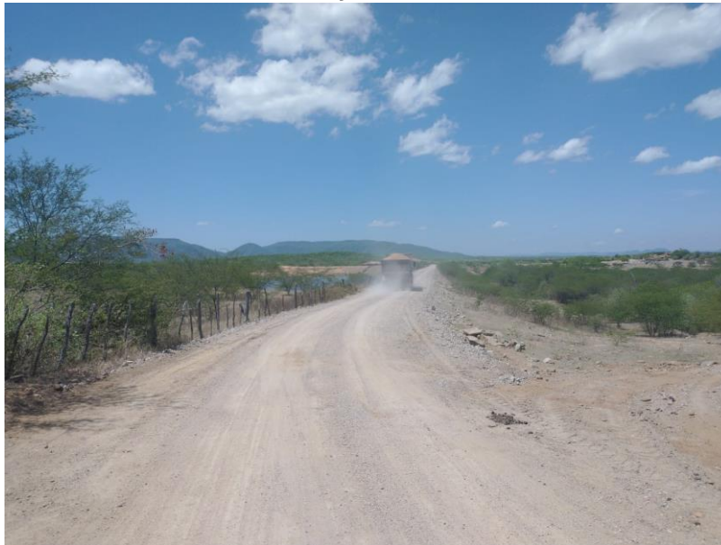
FIGURA 25 – EXECUÇÃO DE ESTRADAS VICINAIS NO MUNICÍPIO DE RIACHO DA CRUZ – RN - TRECHO NA COMUNIDADE BAIXA DO ARROZ;
