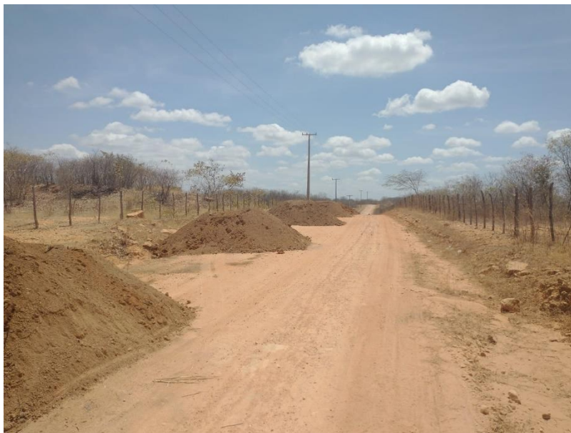
FIGURA 9 – EXECUÇÃO DE ESTRADAS VICINAIS NO MUNICÍPIO DE RIACHO DA CRUZ – RN - TRECHO NA COMUNIDADE BAIXA DO ARROZ;
