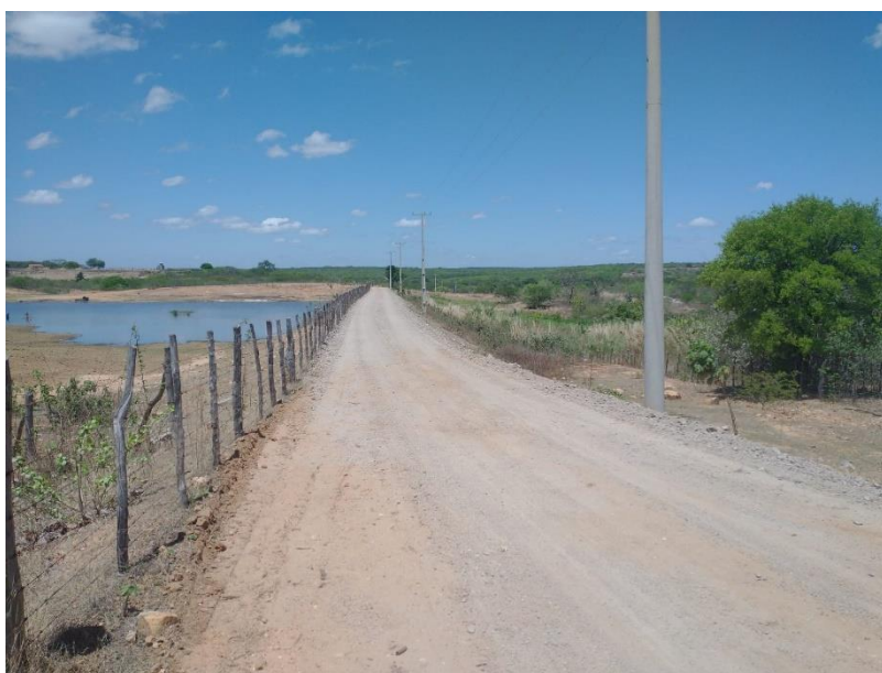
FIGURA 22 – EXECUÇÃO DE ESTRADAS VICINAIS NO MUNICÍPIO DE RIACHO DA CRUZ – RN - TRECHO NA COMUNIDADE BAIXA DO ARROZ;
