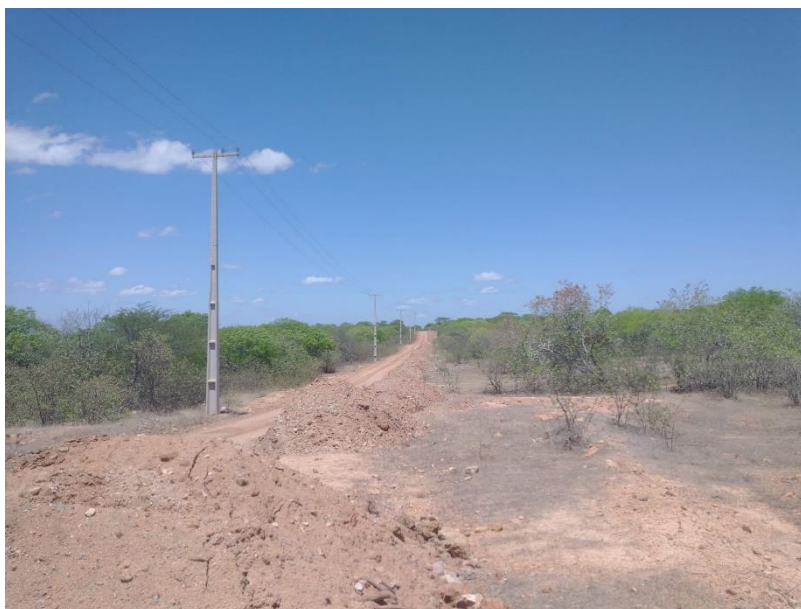
FIGURA 20 – EXECUÇÃO DE ESTRADAS VICINAIS NO MUNICÍPIO DE RIACHO DA CRUZ – RN - TRECHO NA COMUNIDADE BAIXA DO ARROZ;
