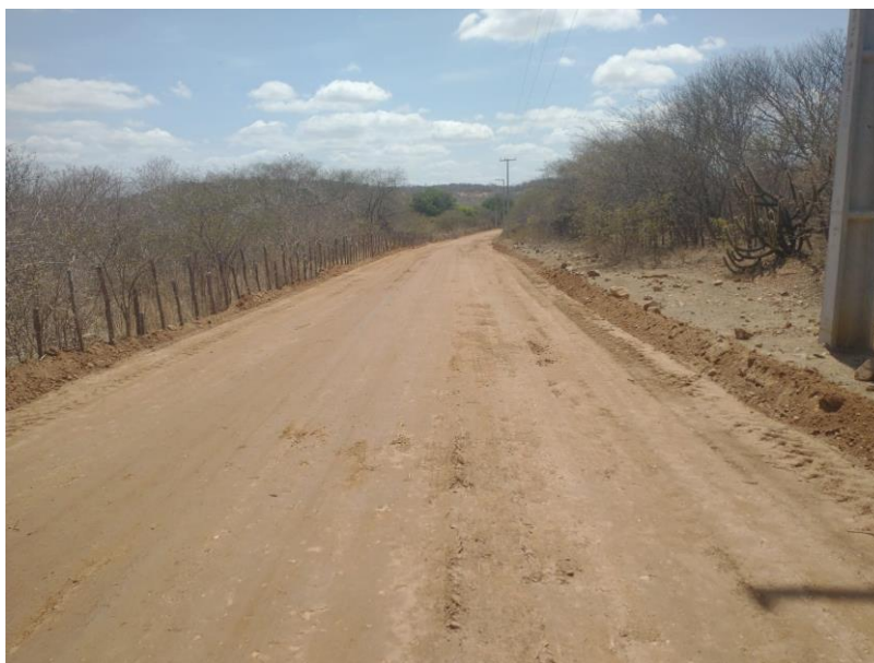
FIGURA 10 – EXECUÇÃO DE ESTRADAS VICINAIS NO MUNICÍPIO DE RIACHO DA CRUZ – RN - TRECHO NA COMUNIDADE BAIXA DO ARROZ;
