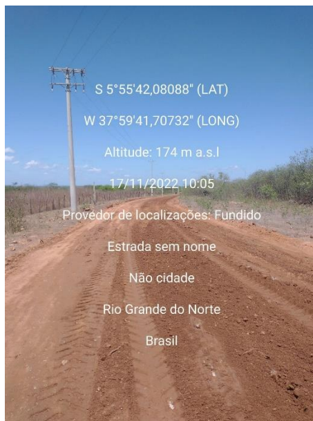
FIGURA 27 – EXECUÇÃO DE ESTRADAS VICINAIS NO MUNICÍPIO DE RIACHO DA CRUZ – RN - TRECHO NA COMUNIDADE BAIXA DO ARROZ;
