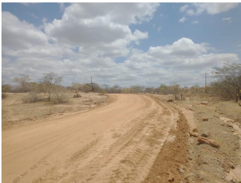
FIGURA 8 – EXECUÇÃO DE ESTRADAS VICINAIS NO MUNICÍPIO DE RIACHO DA CRUZ – RN - TRECHO NA COMUNIDADE BAIXA DO ARROZ;
