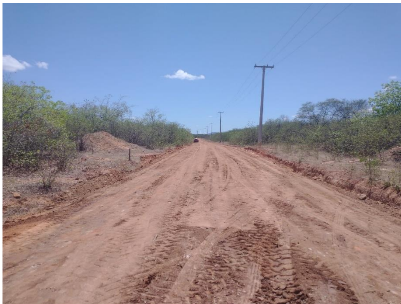
FIGURA 21 – EXECUÇÃO DE ESTRADAS VICINAIS NO MUNICÍPIO DE RIACHO DA CRUZ – RN - TRECHO NA COMUNIDADE BAIXA DO ARROZ;
