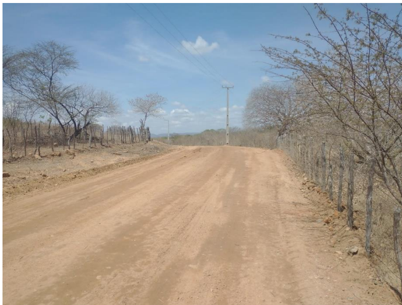
FIGURA 11 – EXECUÇÃO DE SERVIÇOS DE ESPALHAMENTO DE MATERIAL COM MOTONIVELADORA – TRECHO NA COMUNIDADE BAIXA DO ARROZ;
