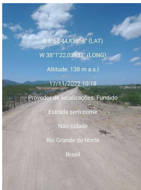
FIGURA 28 – EXECUÇÃO DE ESTRADAS VICINAIS NO MUNICÍPIO DE RIACHO DA CRUZ – RN - TRECHO NA COMUNIDADE BAIXA DO ARROZ;
