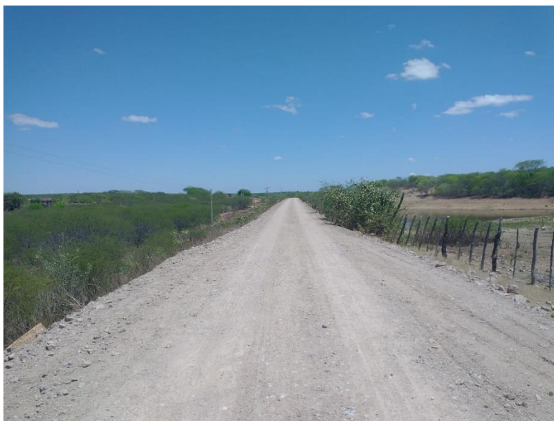
FIGURA 24 – EXECUÇÃO DE ESTRADAS VICINAIS NO MUNICÍPIO DE RIACHO DA CRUZ – RN - TRECHO NA COMUNIDADE BAIXA DO ARROZ;
