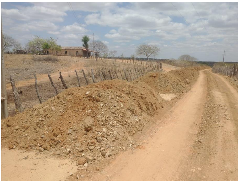
FIGURA 3 – EXECUÇÃO DE ESTRADAS VICINAIS NO MUNICÍPIO DE RIACHO DA CRUZ – RN - TRECHO NA COMUNIDADE BAIXA DO ARROZ;
