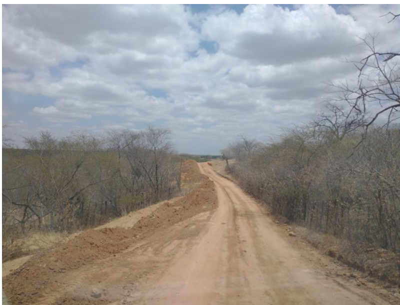
FIGURA 4 – EXECUÇÃO DE ESTRADAS VICINAIS NO MUNICÍPIO DE RIACHO DA CRUZ – RN - TRECHO NA COMUNIDADE BAIXA DO ARROZ;
