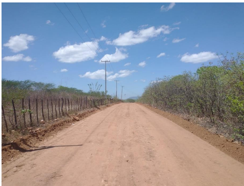
FIGURA 18 – EXECUÇÃO DE ESTRADAS VICINAIS NO MUNICÍPIO DE RIACHO DA CRUZ – RN - TRECHO NA COMUNIDADE BAIXA DO ARROZ;
