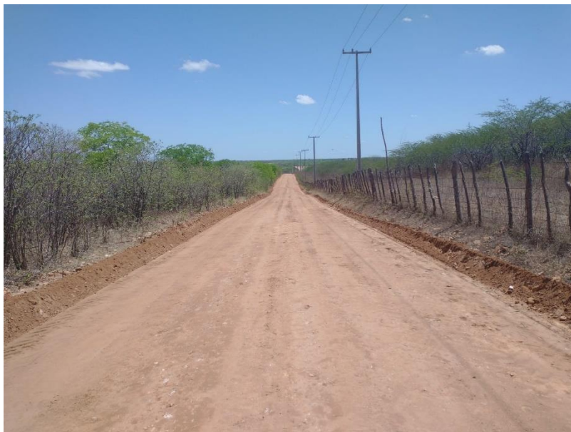
FIGURA 19 – EXECUÇÃO DE ESTRADAS VICINAIS NO MUNICÍPIO DE RIACHO DA CRUZ – RN - TRECHO NA COMUNIDADE BAIXA DO ARROZ;
