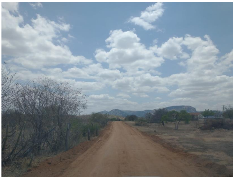
FIGURA 7 – EXECUÇÃO DE ESTRADAS VICINAIS NO MUNICÍPIO DE RIACHO DA CRUZ – RN - TRECHO NA COMUNIDADE BAIXA DO ARROZ;
