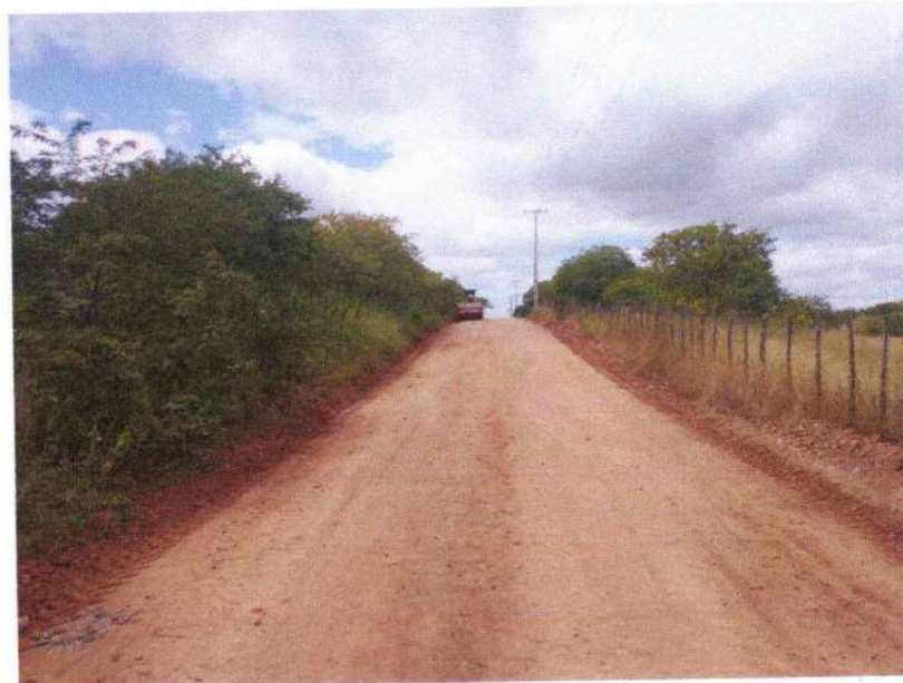
FIGURA 20 – EXECUÇÃO DE ESTRADAS VICINAIS NO MUNICÍPIO DE RIACHO DA CRUZ – RN - TRECHO NA COMUNIDADE BAIXA DO ARROZ;
