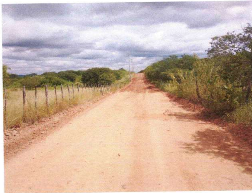
FIGURA 19 – EXECUÇÃO DE ESTRADAS VICINAIS NO MUNICÍPIO DE RIACHO DA CRUZ – RN - TRECHO NA COMUNIDADE BAIXA DO ARROZ;
