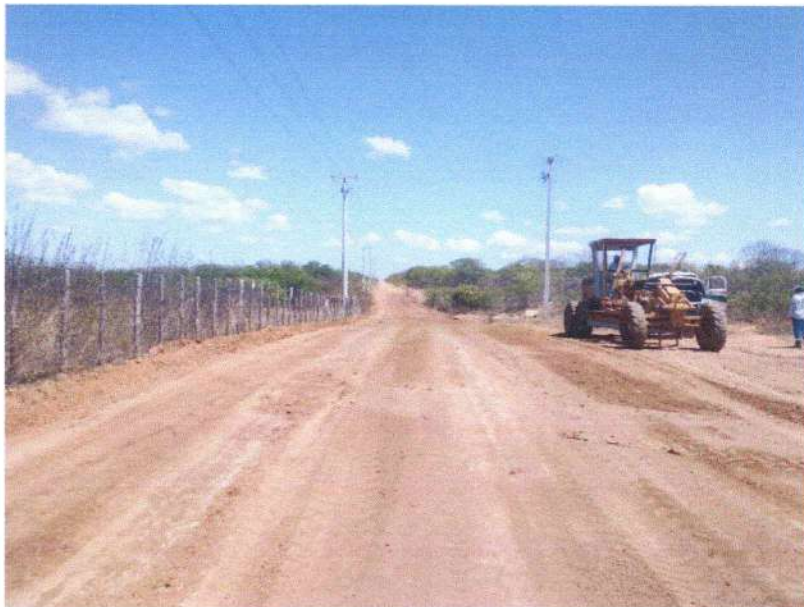
FIGURA 18 – EXECUÇÃO DE ESTRADAS VICINAIS NO MUNICÍPIO DE RIACHO DA CRUZ – RN - TRECHO NA COMUNIDADE BAIXA DO ARROZ;
