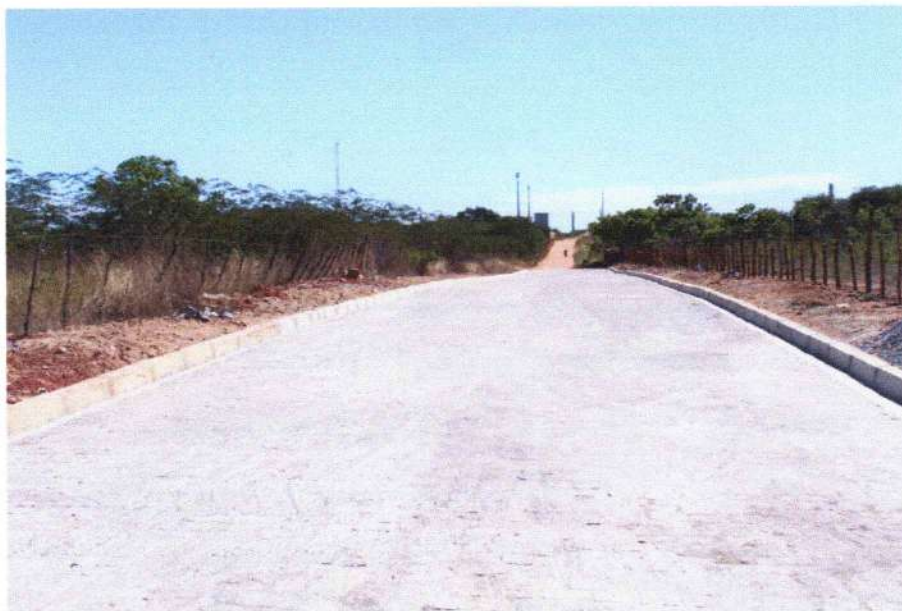
FIGURA 7 – CONCLUSÃO DA EXECUÇÃO DOS SERVIÇOS DE PAVIMENTAÇÃO EM PARALELEPÍPEDO – COMUNIDADE ARACAJU;
