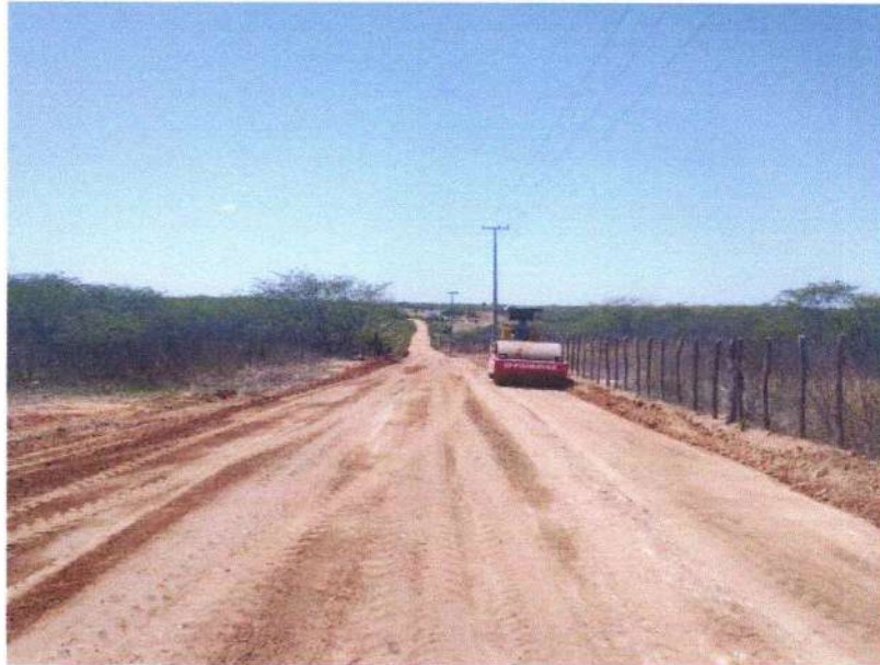
FIGURA 17 – EXECUÇÃO DE SERVIÇOS DE COMPACTAÇÃO DE MATERIAL COM ROLO COMPACTADOR – TRECHO NA COMUNIDADE BAIXA DO ARROZ;
