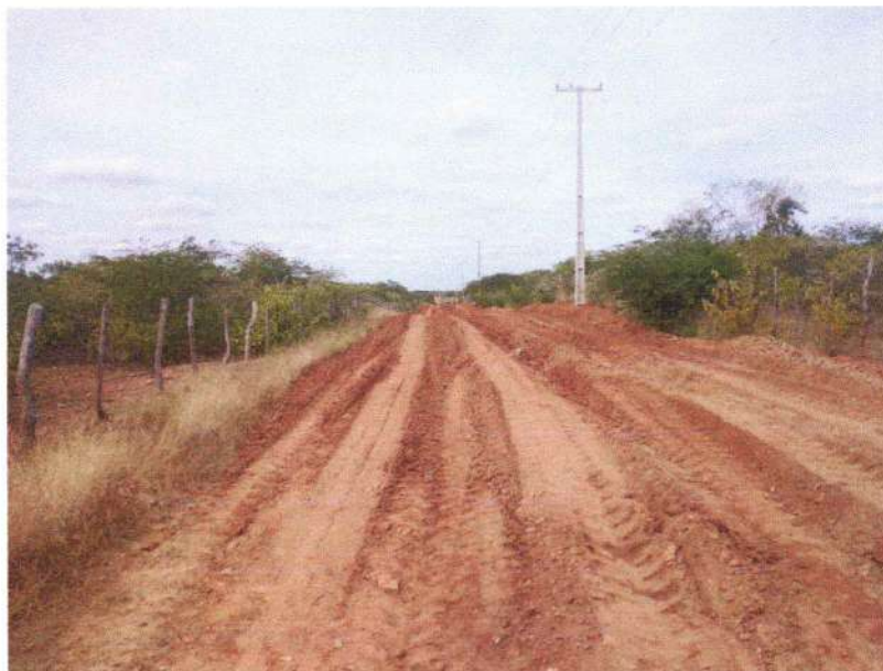
FIGURA 9 – EXECUÇÃO DE SERVIÇOS DE ESPALHAMENTO DE MATERIAL COM MOTONIVELADORA – TRECHO NA COMUNIDADE BAIXA DO ARROZ;
