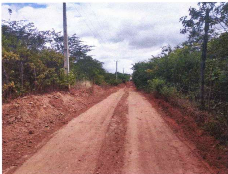
FIGURA 12 – EXECUÇÃO DE SERVIÇOS DE ESPALHAMENTO DE MATERIAL COM MOTONIVELADORA – TRECHO NA COMUNIDADE BAIXA DO ARROZ;
