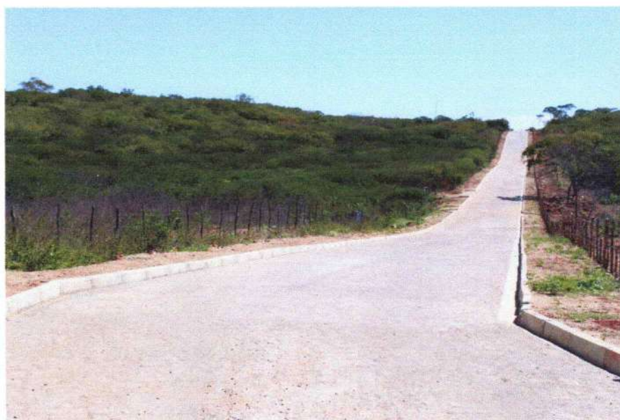
FIGURA 4 – CONCLUSÃO DA EXECUÇÃO DOS SERVIÇOS DE PAVIMENTAÇÃO EM PARALELEPÍPEDO – COMUNIDADE ARACAJU;
