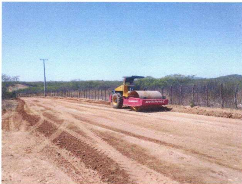
FIGURA 15 – EXECUÇÃO DE SERVIÇOS DE COMPACTAÇÃO DE MATERIAL COM ROLO COMPACTADOR – TRECHO NA COMUNIDADE BAIXA DO ARROZ;
