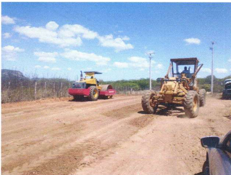
FIGURA 16 – EXECUÇÃO DE SERVIÇOS DE COMPACTAÇÃO DE MATERIAL COM ROLO COMPACTADOR – TRECHO NA COMUNIDADE BAIXA DO ARROZ;
