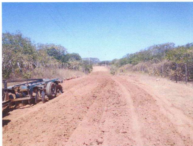
FIGURA 13 – EXECUÇÃO DE SERVIÇOS DE CORTE/HOMOGENEIZAÇÃO DE MATERIAL COM TRATOR E GRADE DE DISCO – TRECHO NA COMUNIDADE BAIXA DO ARROZ;
