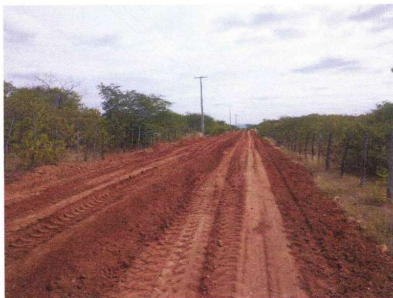
FIGURA 8 – EXECUÇÃO DE SERVIÇOS DE ESPALHAMENTO DE MATERIAL COM MOTONIVELADORA – TRECHO NA COMUNIDADE BAIXA DO ARROZ;
