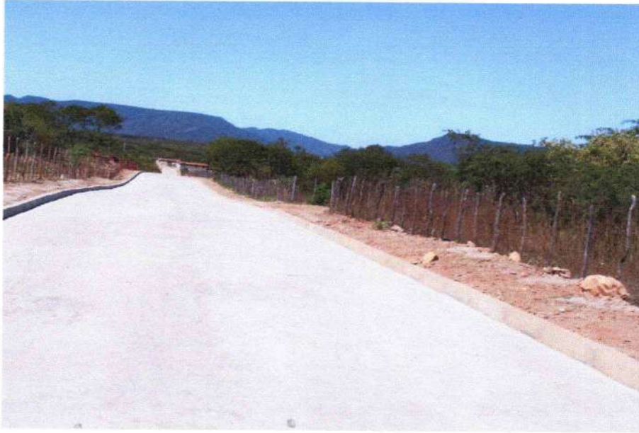
FIGURA 5 – CONCLUSÃO DA EXECUÇÃO DOS SERVIÇOS DE PAVIMENTAÇÃO EM PARALELEPÍPEDO – COMUNIDADE ARACAJU;
