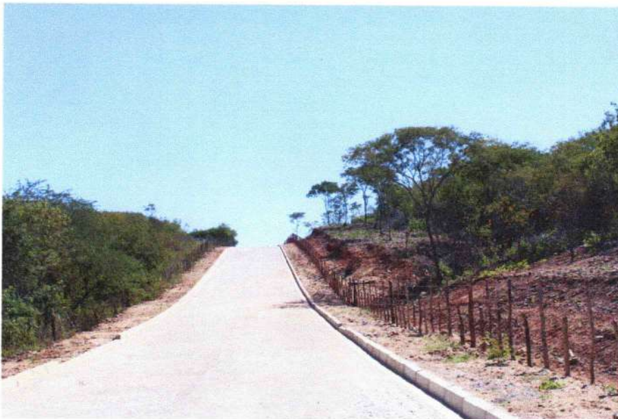
FIGURA 6 – CONCLUSÃO DA EXECUÇÃO DOS SERVIÇOS DE PAVIMENTAÇÃO EM PARALELEPÍPEDO – COMUNIDADE ARACAJU;
