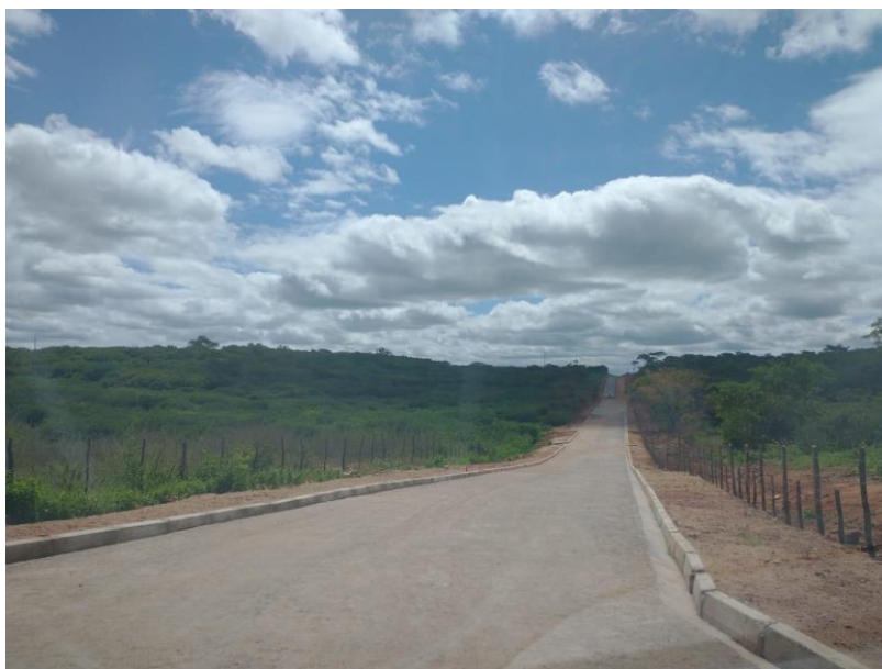
Figura 14 – EXECUÇÃO DE PAVIMENTO EM PARALELEPÍPEDO – COMUNIDADE ARACAJU;
