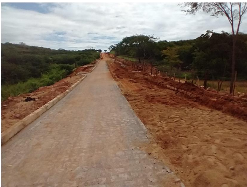
Figura 12 – EXECUÇÃO DE PAVIMENTO EM PARALELEPÍPEDO – COMUNIDADE ARACAJU;
