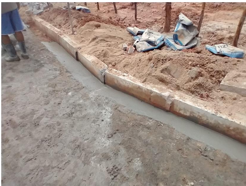
Figura 16 – EXECUÇÃO DE SARJETAS EM CONCRETO – COMUNIDADE ARACAJU;
