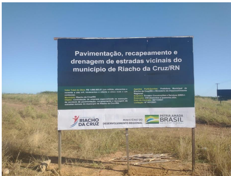
Figura 2 – PLACA DE IDENTIFICAÇÃO DA OBRA;
