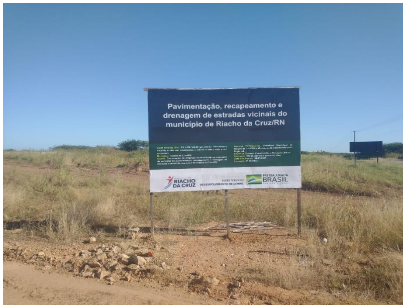
FIGURA 1 – PLACA DE IDENTIFICAÇÃO DA OBRA;
