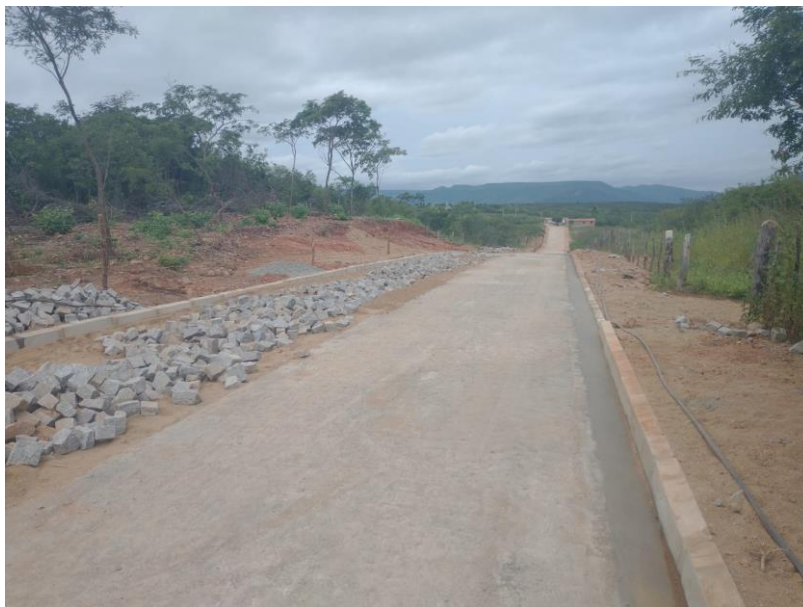
Figura 13 – EXECUÇÃO DE PAVIMENTO EM PARALELEPÍPEDO – COMUNIDADE ARACAJU;
