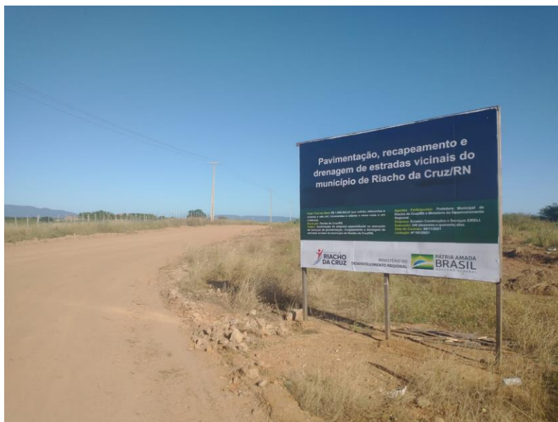
Figura 3 – PLACA DE IDENTIFICAÇÃO DA OBRA;
