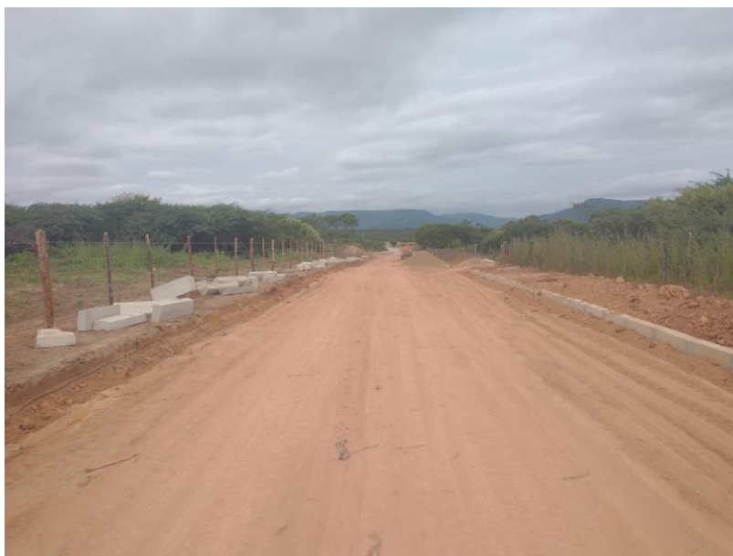
Figura 10 – EXECUÇÃO DOS SERVIÇOS DE REGULARIZAÇÃO, COMPACTAÇÃO DE SOLO E ASSENTAMENTO DE MEIO-FIO EM CONCRETO– COMUNIDADE ARACAJU;
