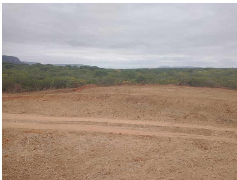
Figura 4 – SERVIÇOS DE LIMPEZA E ESPALHAMENTO DE MATERIAL EM JAZIDAS;
