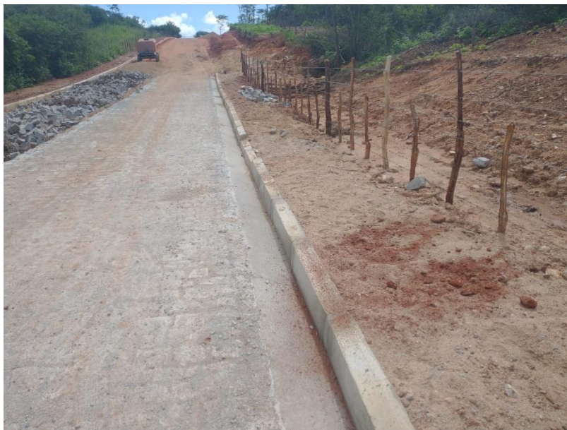
Figura 15 – EXECUÇÃO DE SARJETAS EM CONCRETO – COMUNIDADE ARACAJU;
