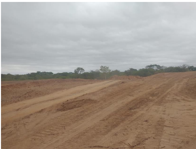
Figura 6 – SERVIÇOS DE LIMPEZA E ESPALHAMENTO DE MATERIAL EM JAZIDAS;
