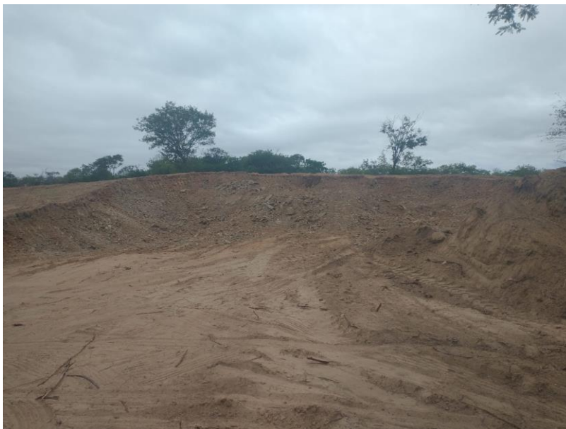
Figura 5 – SERVIÇOS DE LIMPEZA E ESPALHAMENTO DE MATERIAL EM JAZIDAS;
