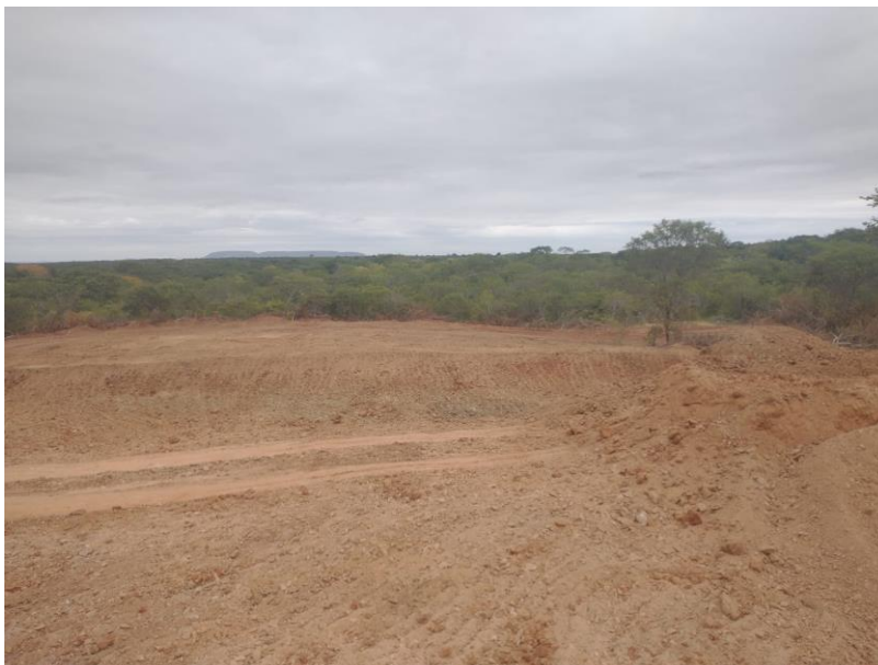
Figura 7 – SERVIÇOS DE LIMPEZA E ESPALHAMENTO DE MATERIAL EM JAZIDAS;
