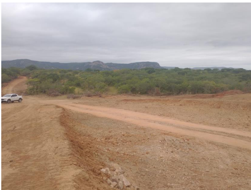
Figura 8 – SERVIÇOS DE LIMPEZA E ESPALHAMENTO DE MATERIAL EM JAZIDAS;
