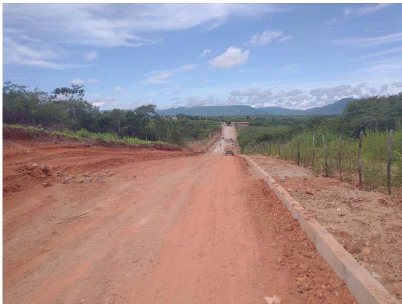
Figura 11 – EXECUÇÃO DOS SERVIÇOS DE REGULARIZAÇÃO, COMPACTAÇÃO DE SOLO E ASSENTAMENTO DE MEIO-FIO EM CONCRETO – COMUNIDADE ARACAJU;
