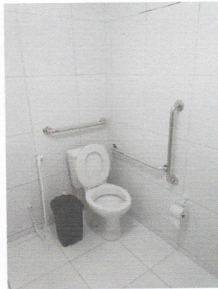
FIGURA 7 – EXECUÇÃO DE REVESTIMENTO CERÂMICO, INSTALAÇÃO DE LOUÇAS, ACESSÓRIOS DE BANHEIROS E BARRAS DE APOIO E ACESSIBILIDADE;
