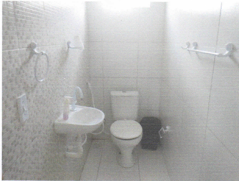
FIGURA 5 – EXECUÇÃO DE REVESTIMENTO CERÂMICO, INSTALAÇÃO DE LOUÇAS E ACESSÓRIOS DE BANHEIROS;
