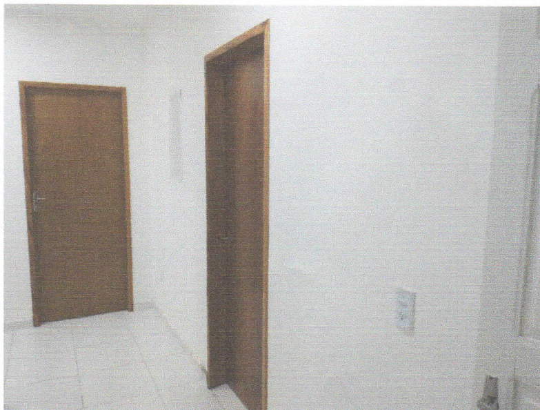
FIGURA 2 – EXECUÇÃO DE INSTALAÇÕES DE INTERRUPTORES E TOMADAS;
