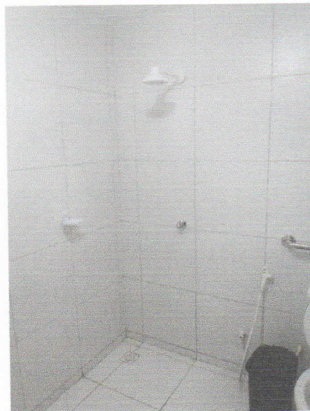
FIGURA 8 – EXECUÇÃO DE REVESTIMENTO CERÂMICO, INSTALAÇÃO DE LOUÇAS, ACESSÓRIOS DE BANHEIROS E BARRAS DE APOIO E ACESSIBILIDADE;
