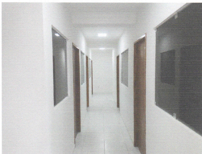
FIGURA 4 – EXECUÇÃO DE INSTALAÇÕES DE LUMINÁRIAS DE LED;
