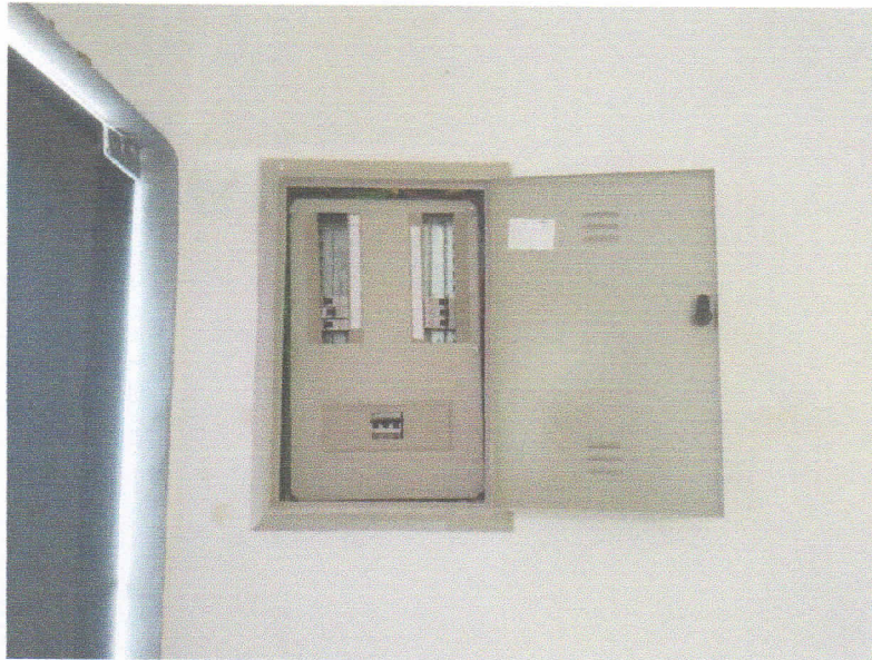
FIGURA 1 – EXECUÇÃO DE INSTALAÇÕES DE QUADRO DE DISTRIBUIÇÃO 02;
