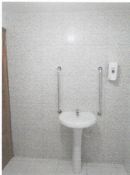
FIGURA 6 – EXECUÇÃO DE REVESTIMENTO CERÂMICO, INSTALAÇÃO DE LOUÇAS, ACESSÓRIOS DE BANHEIROS E BARRAS DE APOIO E ACESSIBILIDADE;
