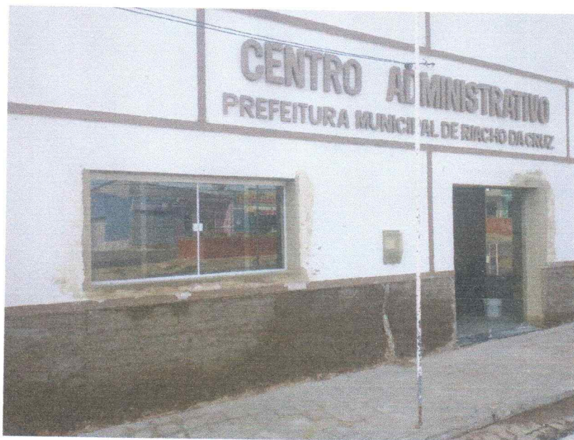
FIGURA 3 – FIXAÇÃO DE ESQUADRIAS (JANELAS) E REPAROS NA FACHADA PRINCIPAL;
