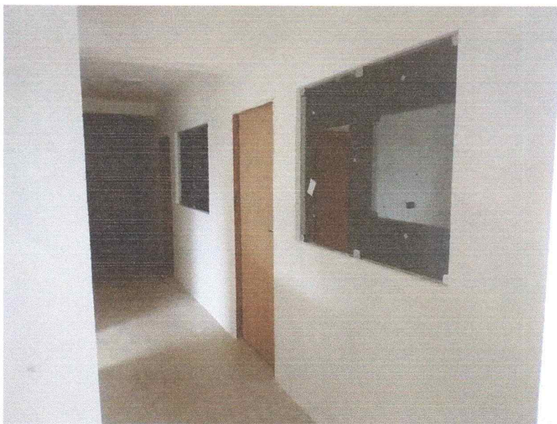
FIGURA 8 – EXECUÇÃO DE EMASSAMENTO, PINTURA E FIXAÇÃO DE ESQUADRIAS (DIVISÓRIAS EM VIDRO);
