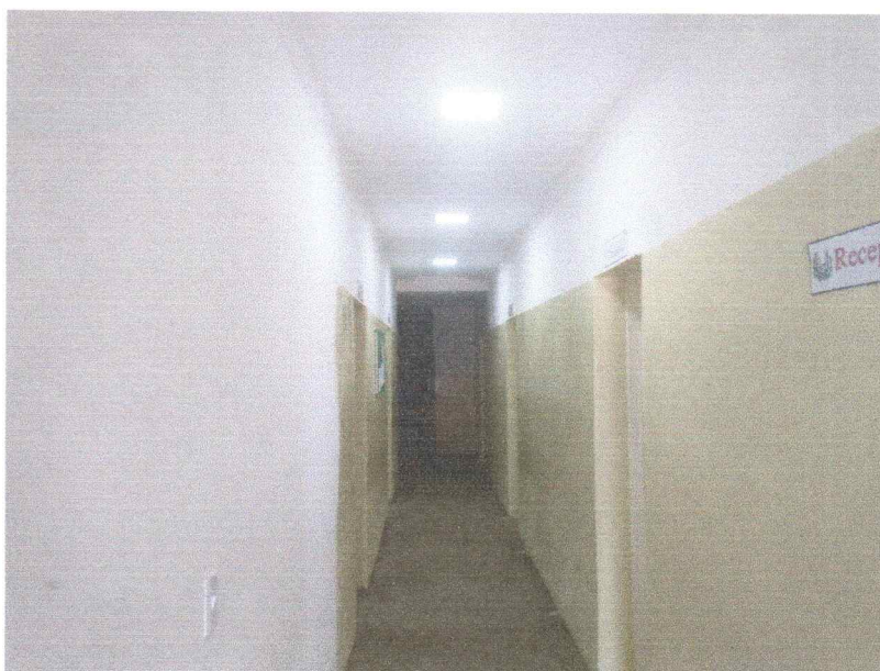
FIGURA 12 - INSTALAÇÕES DE LUMINÁRIAS, EMASSAMENTO E PINTURA DO TETO;
