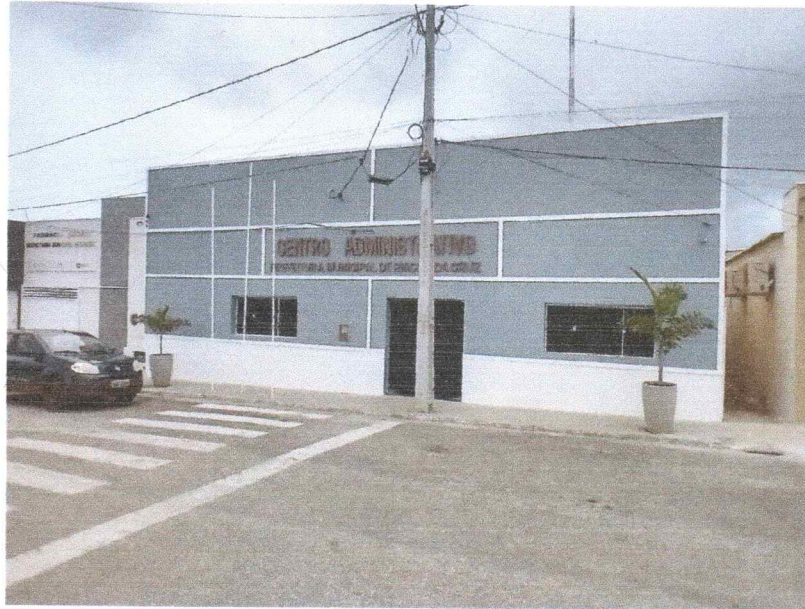
FIGURA 5 – PINTURA DA FACHADA PRINCIPAL DO CENTRO ADMINISTRATIVO;
