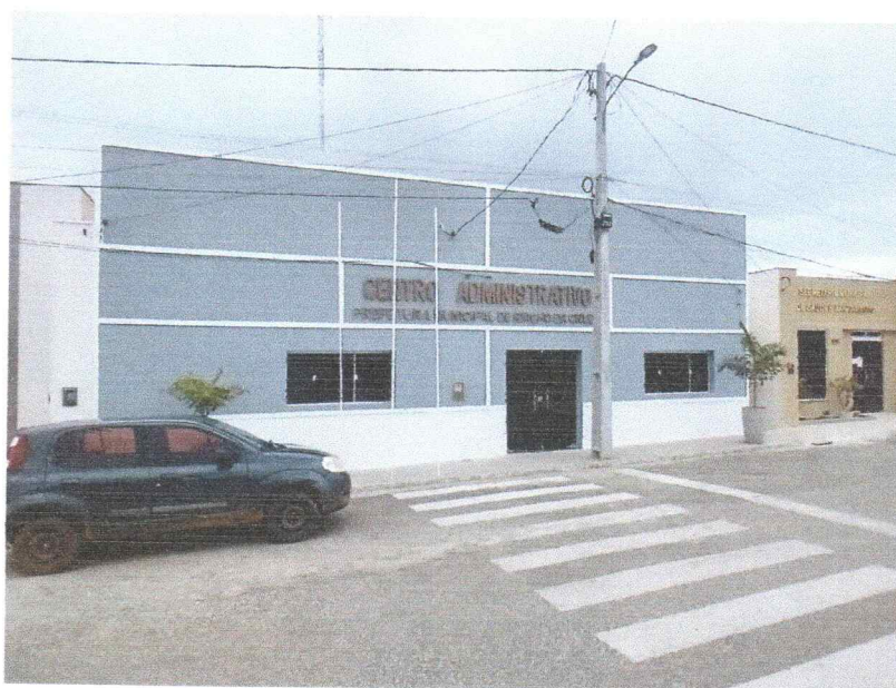
FIGURA 4 – PINTURA DA FACHADA PRINCIPAL DO CENTRO ADMINISTRATIVO;
