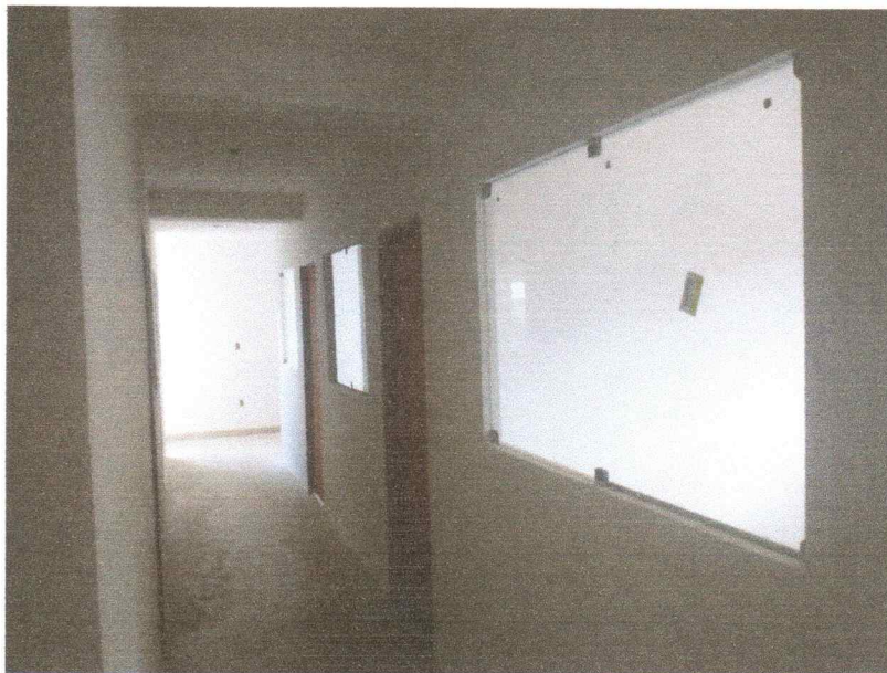
FIGURA 9 – EXECUÇÃO DE EMASSAMENTO, PINTURA E FIXAÇÃO DE ESQUADRIAS (DIVISÓRIAS EM VIDRO);
