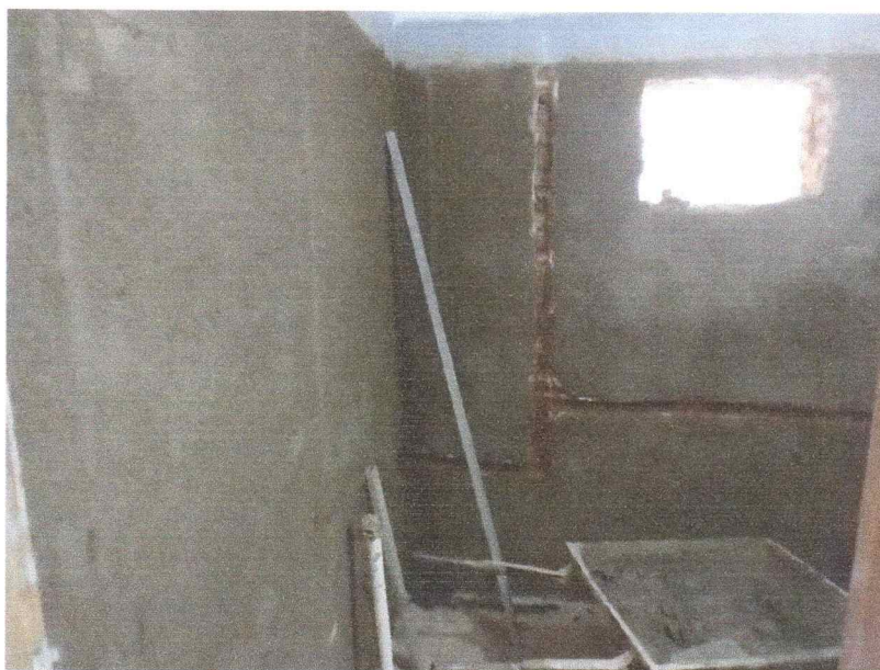
FIGURA 2 - REMOÇÃO DE ESQUADRIAS E EXECUÇÃO DE NOVAS INSTALAÇÕES HIDRÁULICAS;
