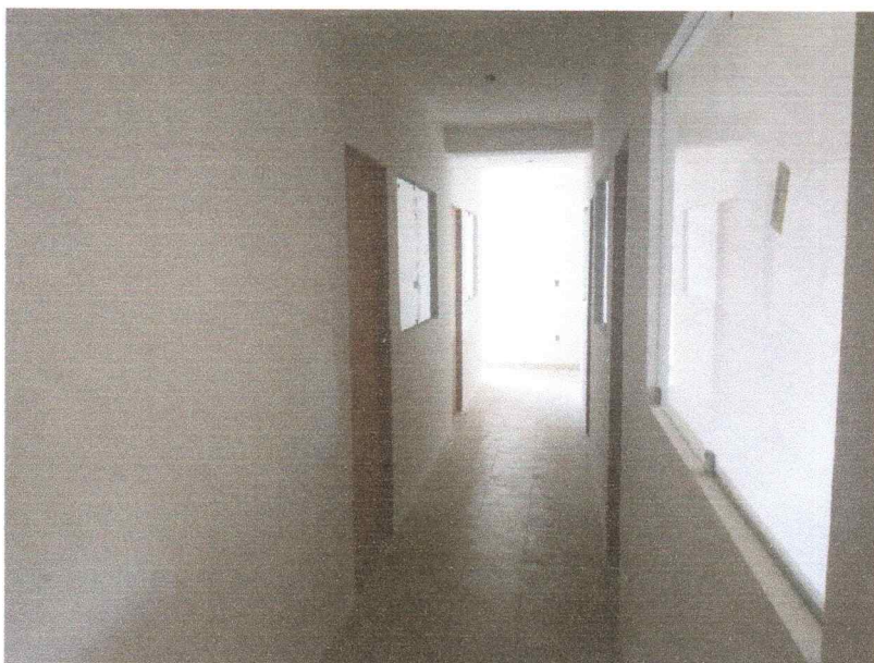
FIGURA 10 - EXECUÇÃO DE EMASSAMENTO, PINTURA E FIXAÇÃO DE ESQUADRIAS (DIVISÓRIAS EM VIDRO);
