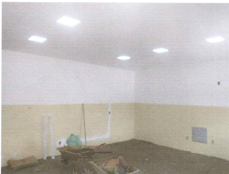
FIGURA 11 – INSTALAÇÕES DE LUMINÁRIAS, EMASSAMENTO E PINTURA DO TETO;
