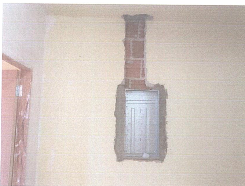
FIGURA 16 - EXECUÇÃO DE INSTALAÇÕES ELÉTRICAS (QUADRO DE DISTRIBUIÇÃO);
