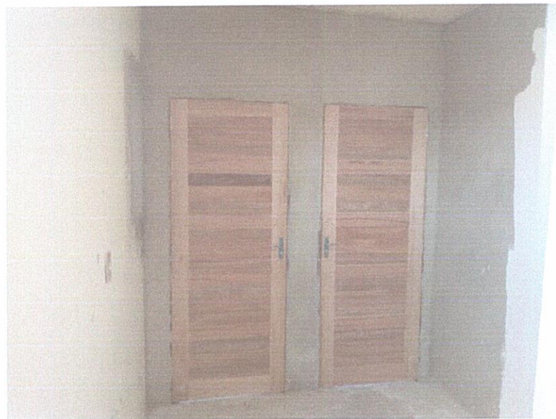
FIGURA 6 – FIXAÇÃO DE CAIXAS DE PORTAS E PORTAS DE MADEIRA;
