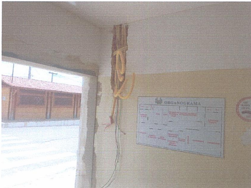
FIGURA 18 - EXECUÇÃO DE INSTALAÇÕES ELÉTRICAS;
