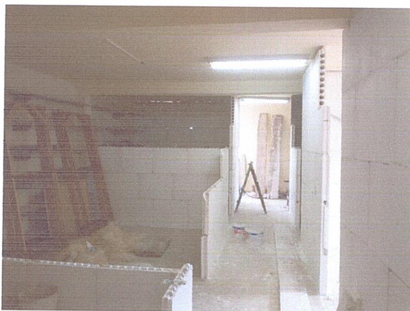
FIGURA 8 – EXECUÇÃO DE ALVENARIA DE VEDAÇÃO DE BLOCOS DE GESSO;
