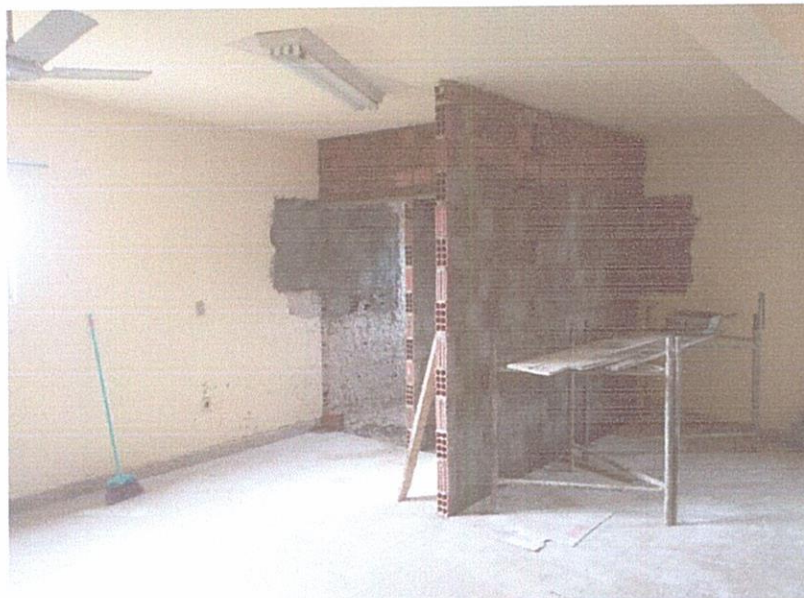
FIGURA 1 – EXECUÇÃO DE ALVENARIA DE TIJOLOS CERÂMICOS, APLICAÇÃO DE CHAPISCO;
