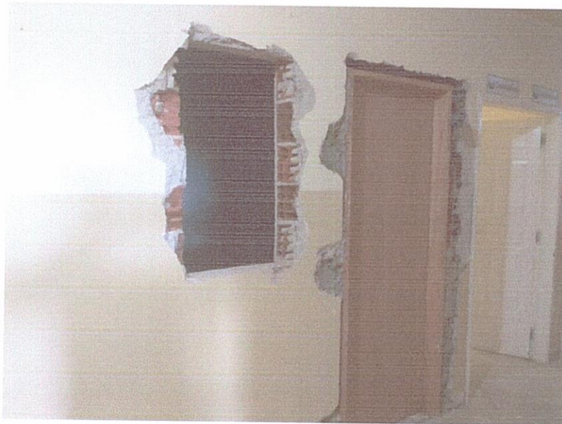
FIGURA 3 – DEMOLIÇÃO DE ALVENARIA EXISTENTES;
