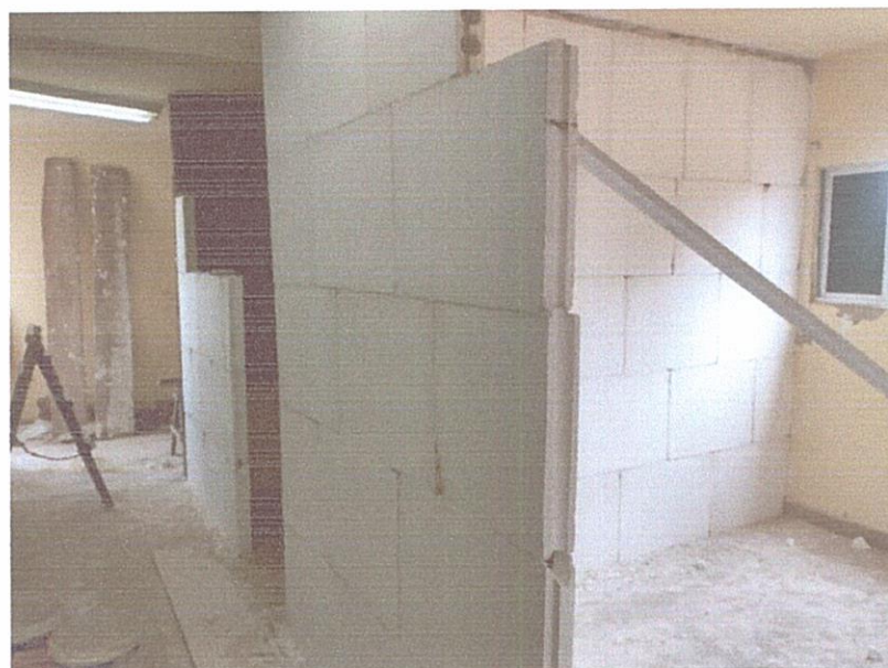
FIGURA 10 - EXECUÇÃO DE ALVENARIA DE VEDAÇÃO DE BLOCOS DE GESSO;
