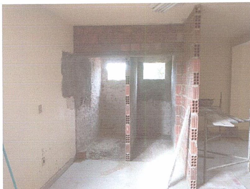
FIGURA 2 - EXECUÇÃO DE ALVENARIA DE TIJOLOS CERÂMICOS, APLICAÇÃO DE CHAPISCO;
