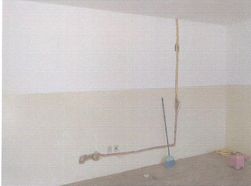
FIGURA 17 – EXECUÇÃO DE INSTALAÇÕES ELÉTRICAS;
