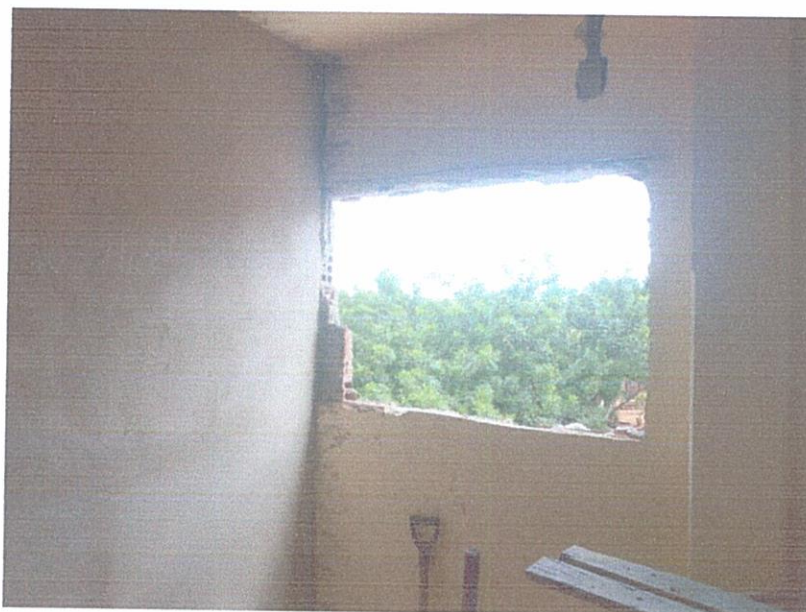
FIGURA 4 - DEMOLIÇÃO DE ALVENARIA EXISTENTES;
