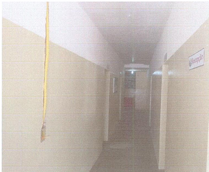
FIGURA 20 - EXECUÇÃO DE FORRO EM PLACAS DE GESSO;
