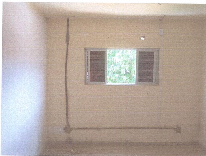
FIGURA 15 – EXECUÇÃO DE INSTALAÇÕES ELÉTRICAS;
