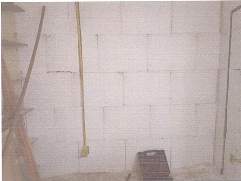
FIGURA 11 – EXECUÇÃO DE ALVENARIA DE VEDAÇÃO DE BLOCOS DE GESSO E INSTALAÇÕES ELETRICAS;
