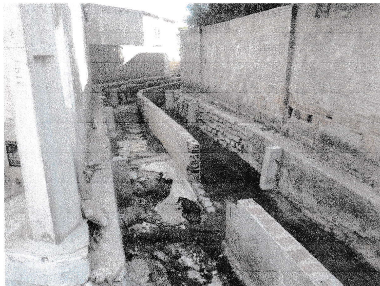
FIGURA 8 - EXECUÇÃO DE CONCRETAGEM DE PILARETES DO TRECHO ENTRE A RUA 07 DE SETEMBRO E A RUA DELFINO FRANCISCO;
