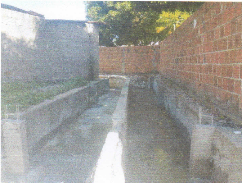
FIGURA 6 - EXECUÇÃO DE CHAPISCO, REVESTIMENTO ARGAMASSADO E CONTRAPISO DO TRECHO ENTRE A RUA 15 DE NOVEMBRO E RUA 07 DE SETEMBRO;
