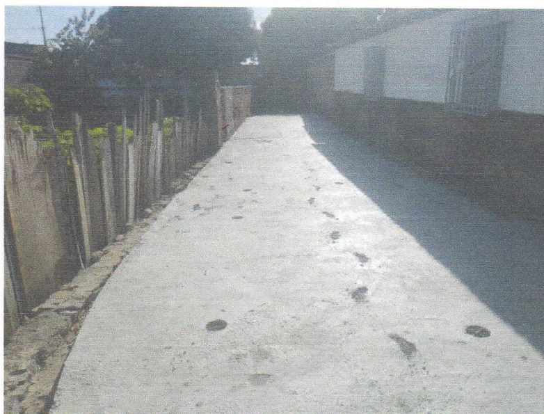
FIGURA 12 – EXECUÇÃO DE CONCRETAGEM DE LAJE E VIGAMENTOS DO TRECHO ENTRE A RUA 15 DE NOVEMBRO E RUA 07 DE SETEMBRO;
