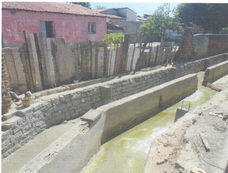
FIGURA 4 – EXECUÇÃO DE CHAPISCO, REVESTIMENTO ARGAMASSADO DO TRECHO ENTRE A RUA 15 DE NOVEMBRO E RUA 07 DE SETEMBRO;
