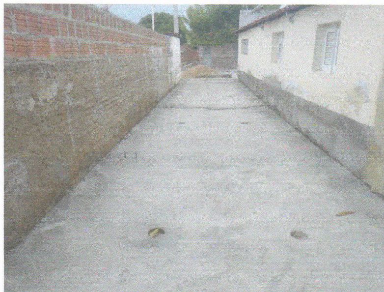
FIGURA 8 - LAJE DO CANAL DE DRENAGEM DO TRECHO ENTRE A RUA PROFESSORA DALILA DA FONSECA ROCHA E RUA 15 DE NOVEMBRO;
