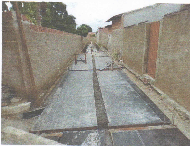
FIGURA 4 - EXECUÇÃO DE FORMAS, ESCORAMENTO E CONCRETAGEM DE PILARETES;
