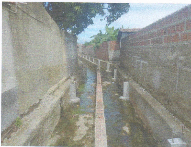
FIGURA 2 - EXECUÇÃO DE FORMAS E CONCRETAGEM DE PILARETES;
