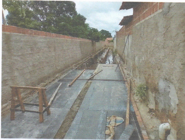
FIGURA 3 – EXECUÇÃO DE FORMAS, ESCORAMENTO E CONCRETAGEM DE PILARETES;
