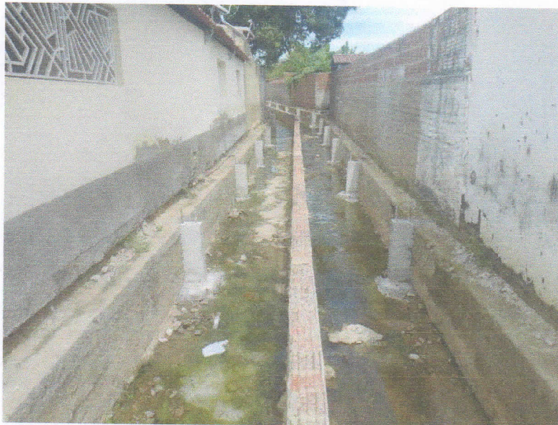
FIGURA 1 – EXECUÇÃO DE FORMAS E CONCRETAGEM DE PILARETES;
