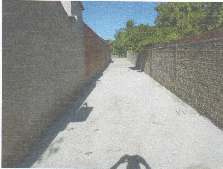
FIGURA 9 – LAJE DO CANAL DE DRENAGEM DO TRECHO ENTRE A RUA PROFESSORA DALILA DA FONSECA ROCHA E RUA 15 DE NOVEMBRO;
