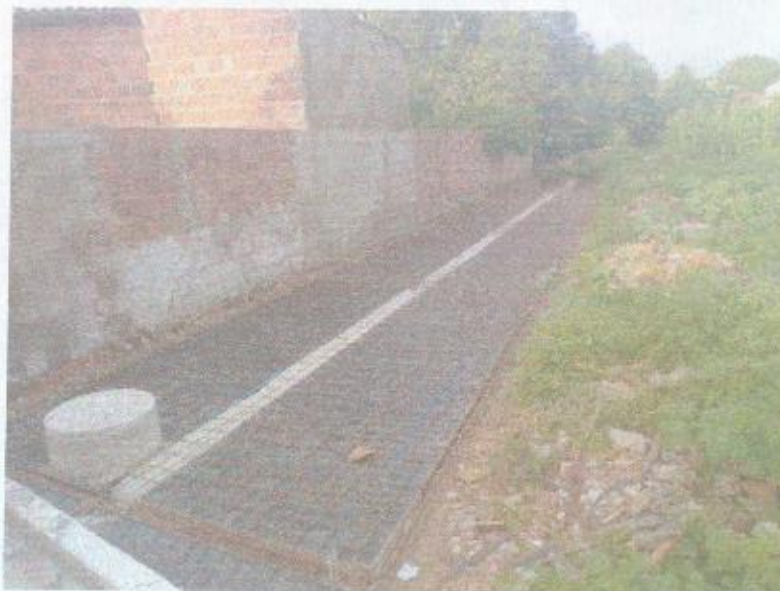
FIGURA 6 - MONTAGEM DE ARMADURA E FORMAS PARA CONCRETAGEM CANAL DE DRENAGEM DO TRECHO ENTRE A RN - 177 E RUA PROFESSORA DALILA DA FONSECA ROCHA;
