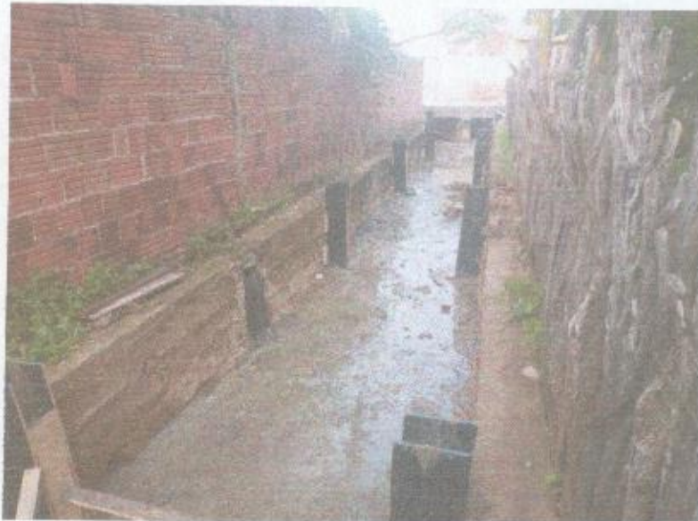
FIGURA 1 – EXECUÇÃO DE FORMAS E CONCRETAGEM DE PILARETES;
