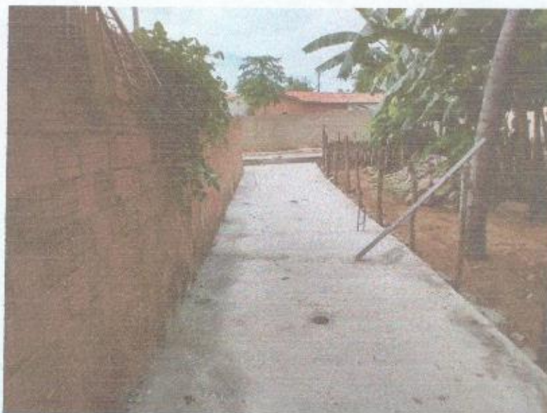
FIGURA 10 – LAJE DO CANAL DE DRENAGEM DO TRECHO ENTRE A RN – 177 E RUA PROFESSORA DALILA DA FONSECA ROCHA;
