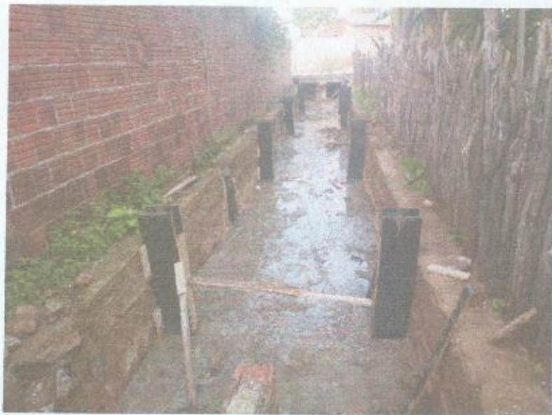
FIGURA 4 - EXECUÇÃO DE FORMAS, ESCORAMENTO E CONCRETAGEM DE PILARETES;
