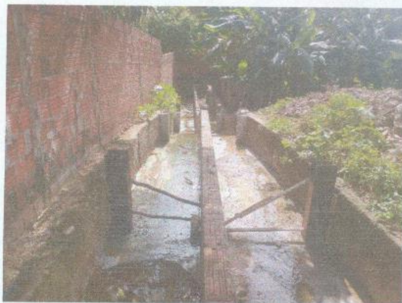
FIGURA 2 - EXECUÇÃO DE FORMAS E CONCRETAGEM DE PILARETES;
